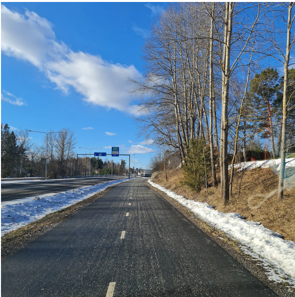
Kuva 27. Valokuva pohjoiselta väylältä Kurkelantien itäpuolelta 5.3.2021 (EVH-Elektroteknikka Oy, 2021).
