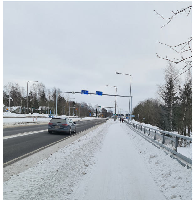
Kuva 21. Valokuva eteläiseltä väylältä Nurkkalankadun risteyskohdalta 16.2.2021 (EVH-Elektroteknikka Oy, 2021).
