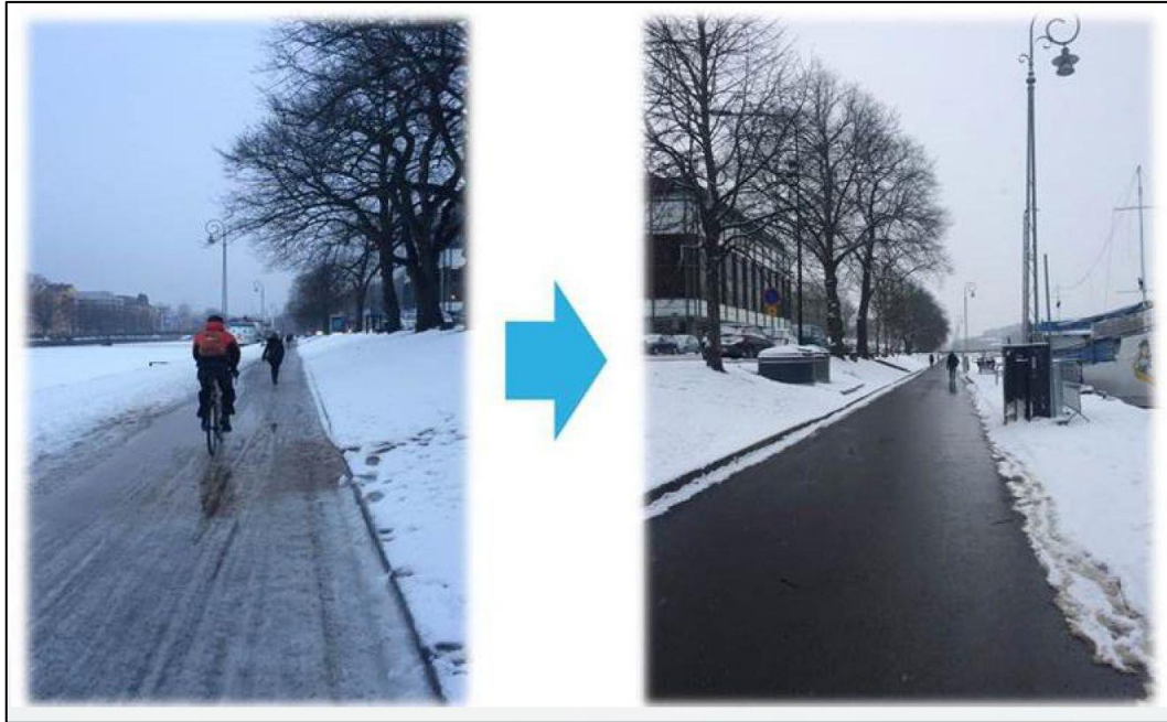
Kuva 2. Tilanne Itäiseltä Rantakadulta talvelta 2016–17 (vasemmanpuoleinen kuva) ja talvelta 2017–18 (oikeanpuoleinen kuva). Kuvapari tuo esille menetelmän selkeimmän vahvuuden eli polanteesta eroon pääsemisen (Karhula et al 2018).
