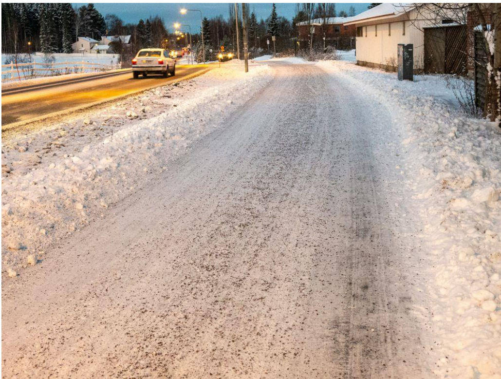
Kuva 6. Tilanne missä hiekoitusmateriaali on painunut väylän reunoilla polanteeseen todennäköisesti pyöräilijöiden vaikutuksesta. Rauno Kuuselan kuva.
