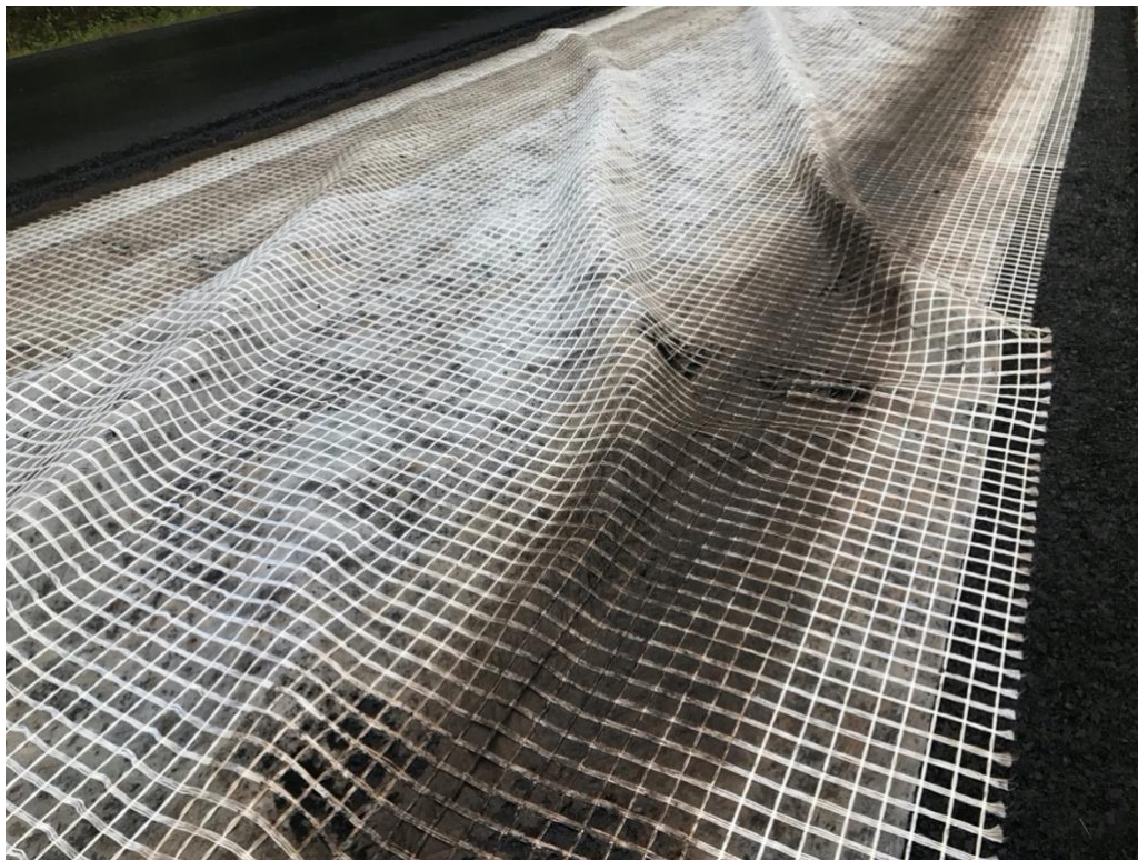
Kuva 11. Cidex G100 -verkko massa-auton peruutettua verkon päälle.
