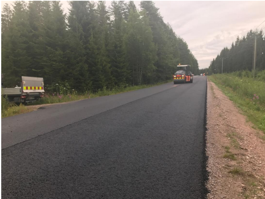
Kuva 21. Storelastic-lisäaineella toteutetun koeosuuden pinta, tiivistys käynnissä.
