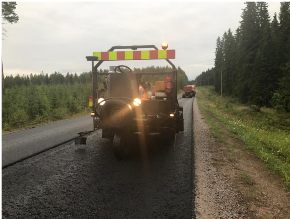
Kuva 9. Massapintauksen liimaukseen käytettävä liimamopo.
