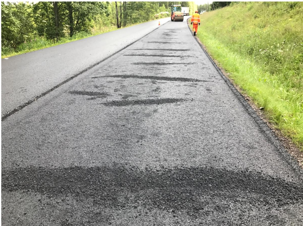
Kuva 15. Suojamassan AB 16 80\text{kg/m}^2 levitys Bitutex Stargrid 100/100-30 -verkon päälle koekaistalle. Koekaistalta puuttuu pintakerros ja referenssikaista (vasen kaista) on valmis.
