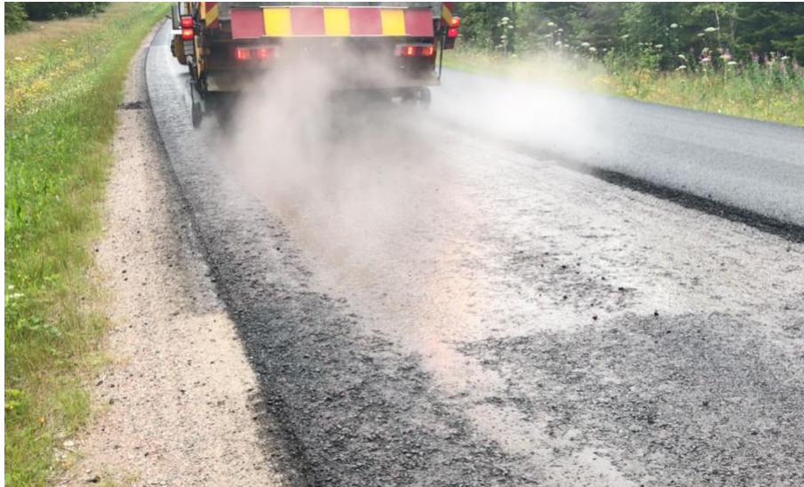
Kuva 10. Kumibitumiemulsion liimausta SIP-kalustolla.
