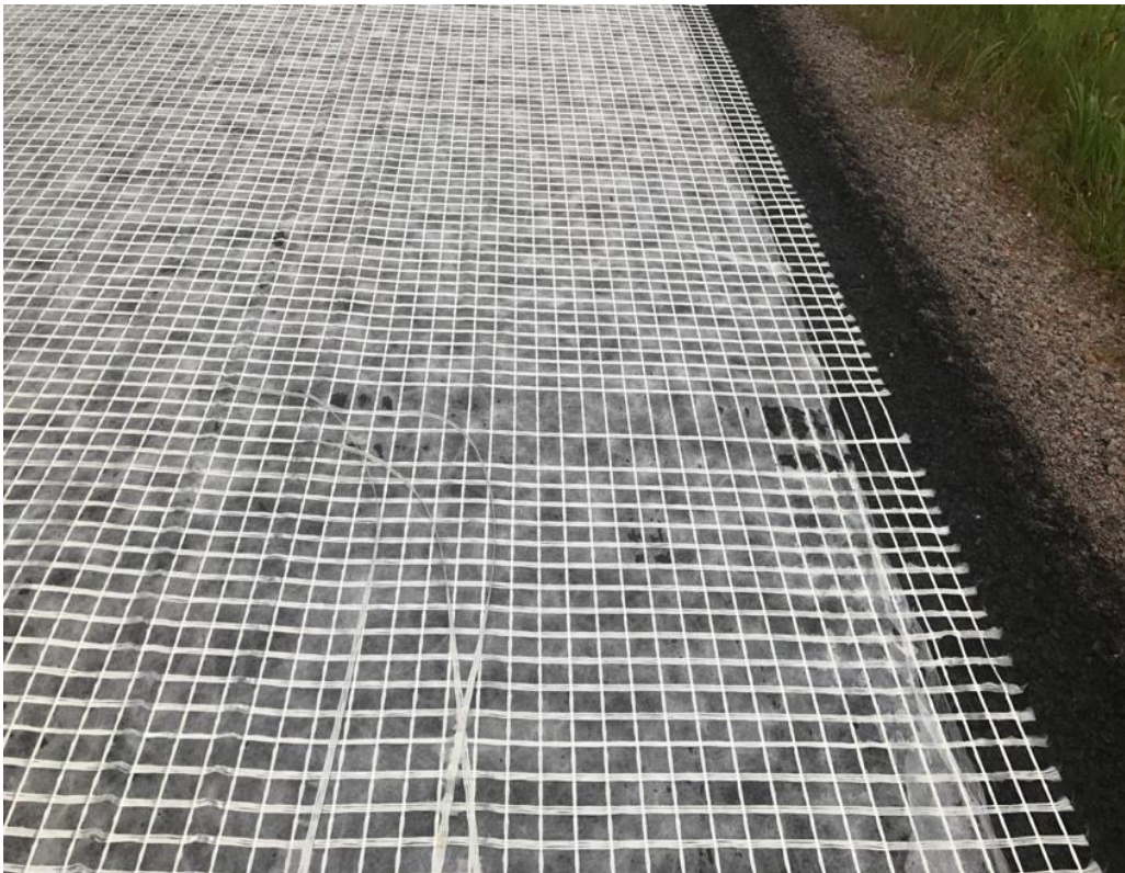
Kuva 13. Verkon valmistusvirheitä.
