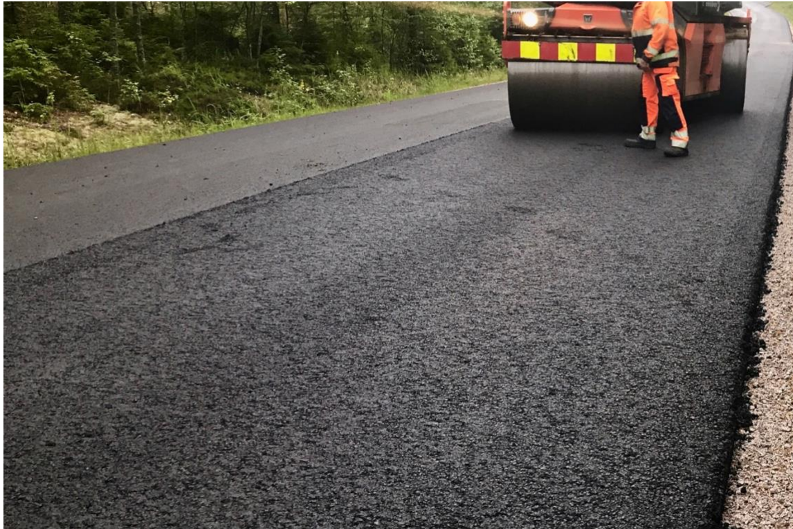
Kuva 25. Jyrän valssia piti puhdistaa Storelastic kohteella kuten myös VIATOP FEP kohteella normaalia useammin.
