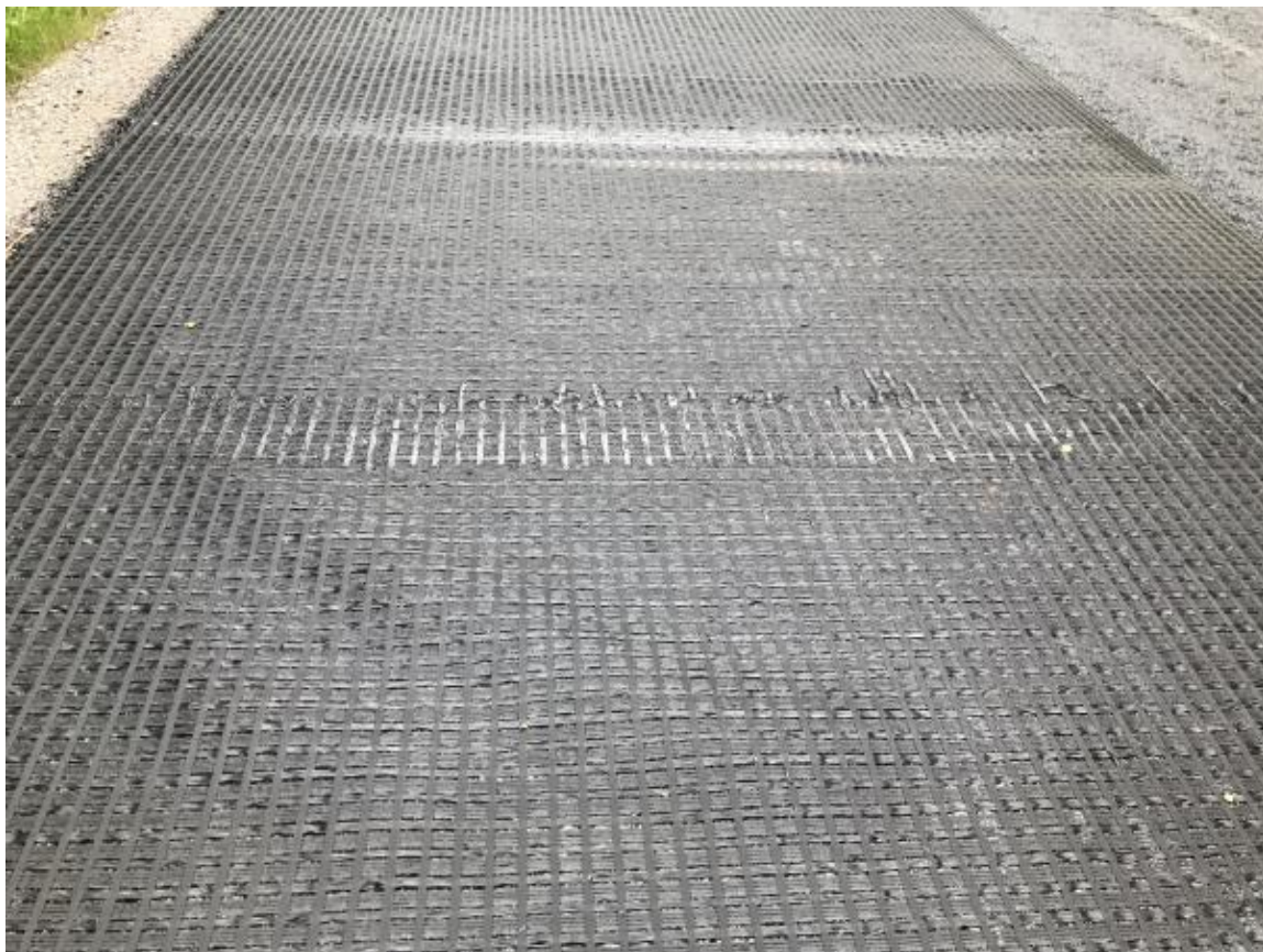
Kuva 14. Bitutex Stargrid 100/100-30 -verkon valmistusvirheitä.
