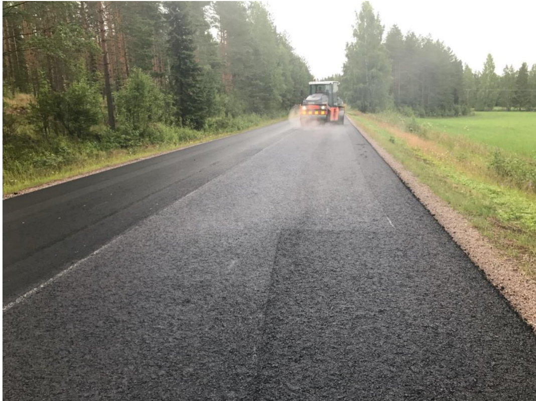
Kuva 22. VIATOP plus FEP osuudella tiivistys käynnissä.
