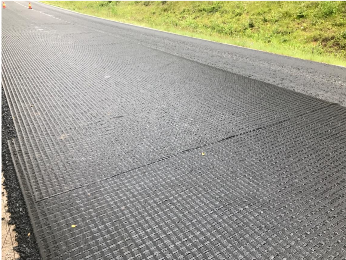
Kuva 20. Lasikuituverkon poikittaislimitys noin 50 cm.
