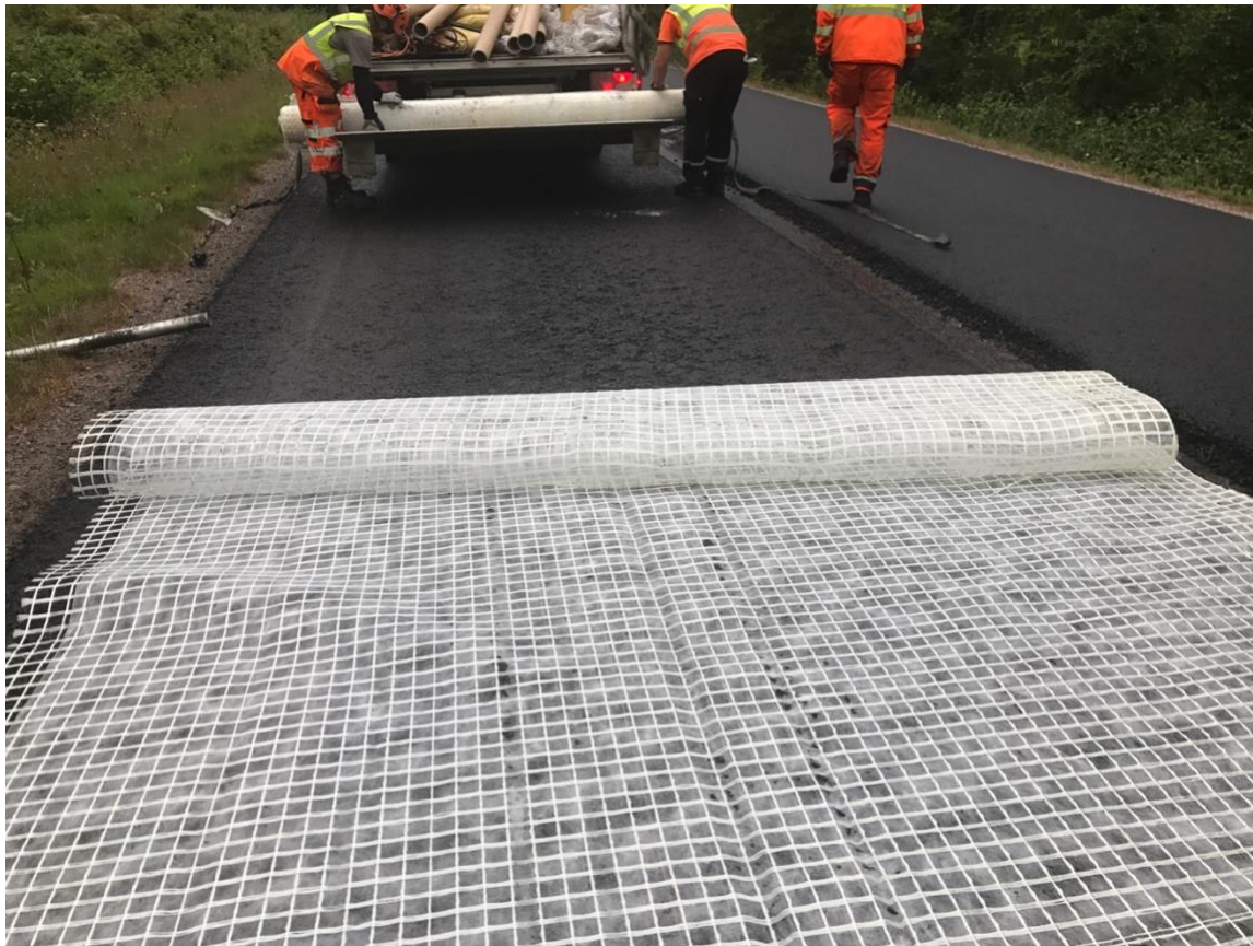
Kuva 18. Cidex G 100 -verkon asennus huoltoautoon asennetun aisan avulla.
