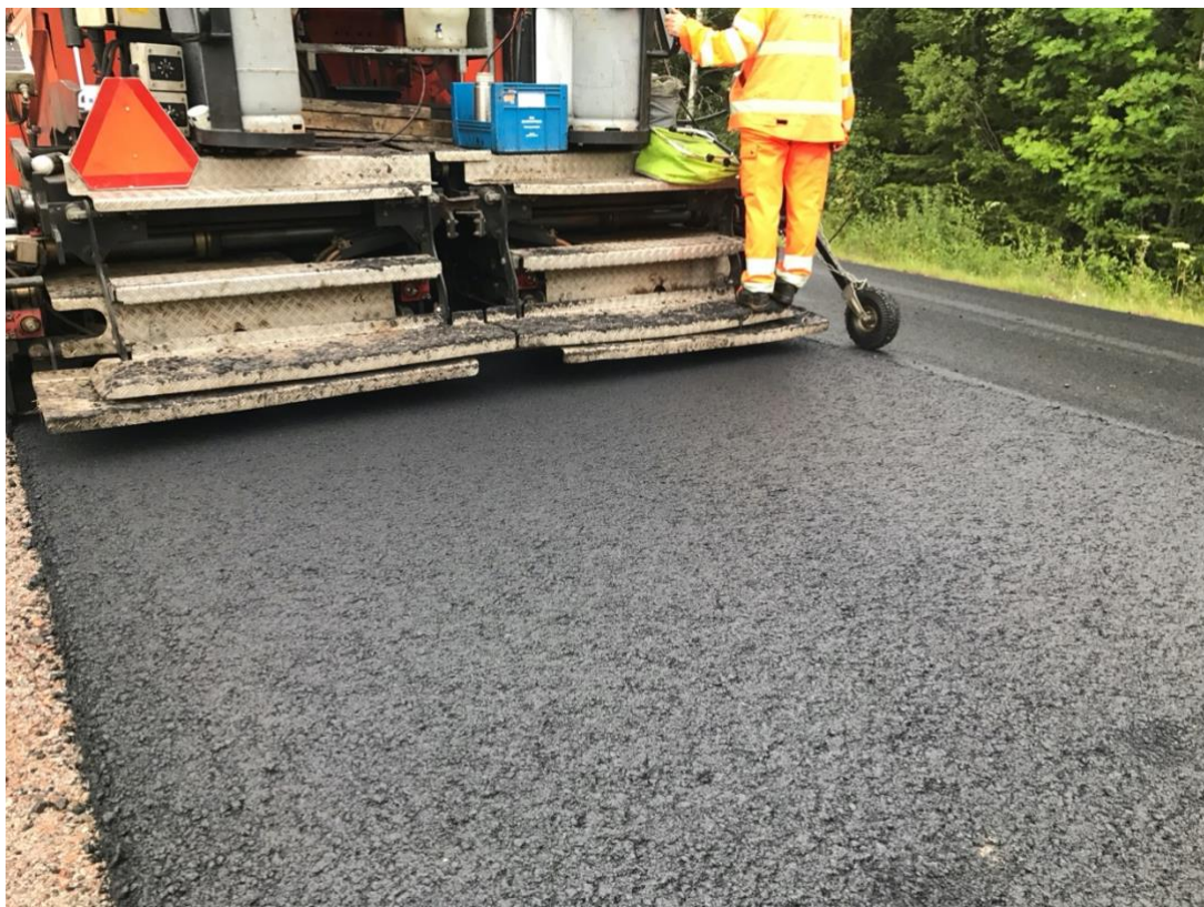
Kuva 23. VIATOP plus FEP osuuden pinta levittäjän perästä kuvattuna ennen tiivistystä.
