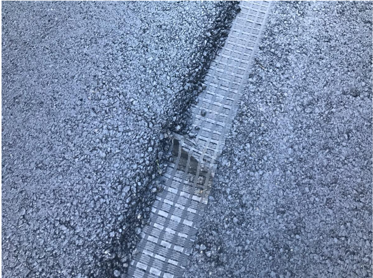
Kuva 16. Referenssikaistalla verkko poimuttui (osuuden 5 kohdalla referenssikaistalla).
