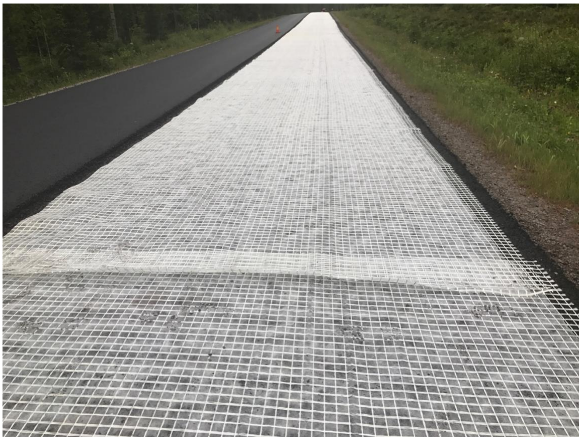
Kuva 19. Poikittaislimitykset onnistuivat hyvin.
