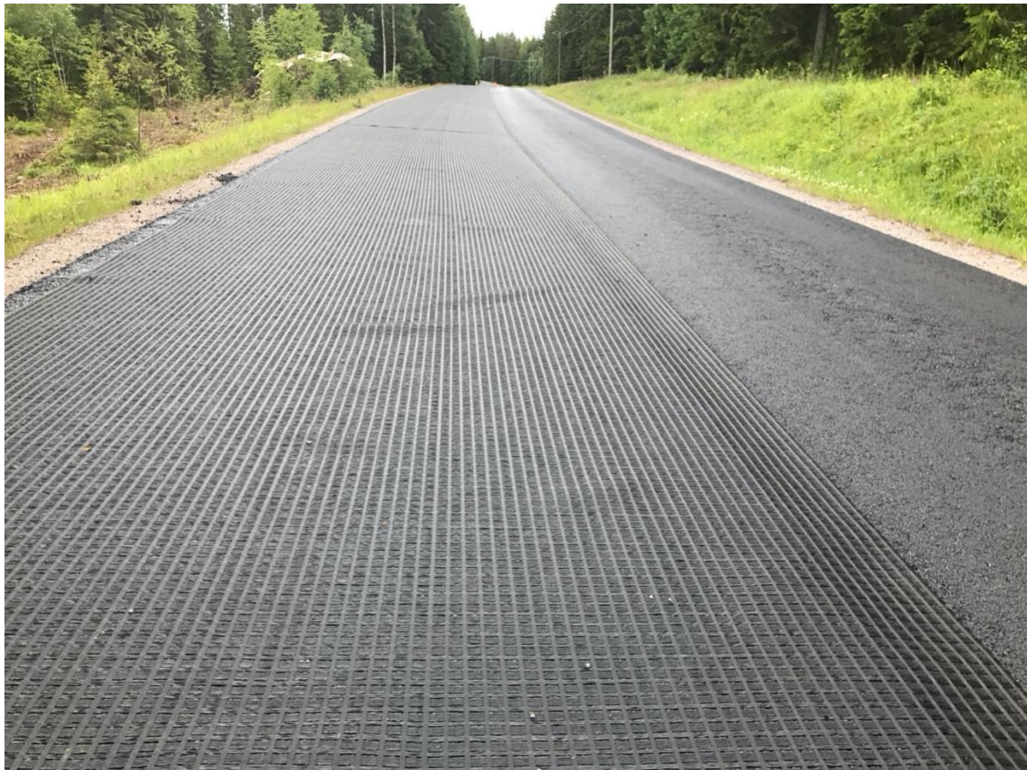
Kuva 3. Korotetun tasauksen päälle referenssikaistalle asennettu lasikuituverkko. Verkko on ulotettu sauman yli ja limitysvaraa oikean kaistan verkon kanssa jää noin 15-20 cm.
