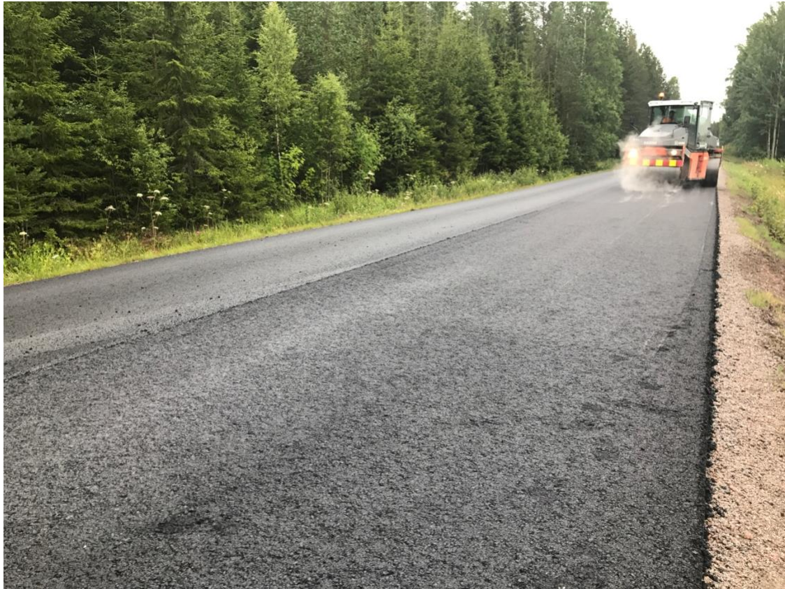
Kuva 24. Viatop Plus FEP osuus ennen tiivistystä.
