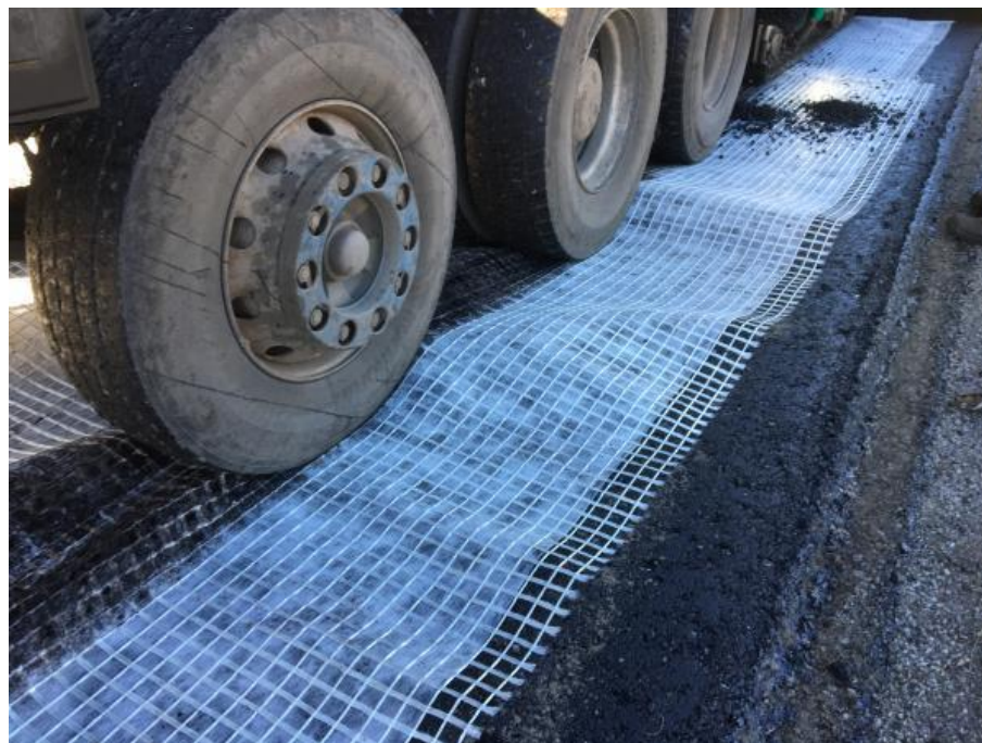
Kuva 9.2.3 Lasikuituverkon liikkuminen ja alustastaan irtoaminen massa-auton peruuttaessa verkon päälle.
