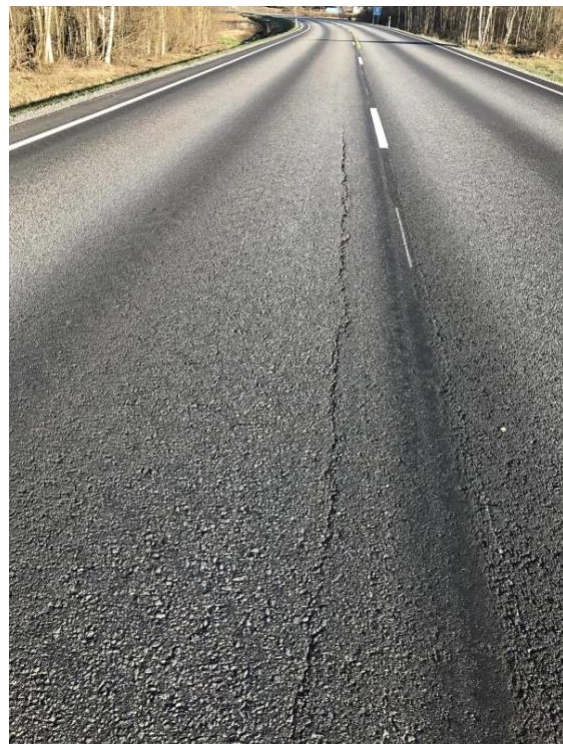
Kuva 9.2.2 Bitutex Stragrid -verkon leveys ei riittänyt keskisaumalle saakka ja keskisauman vieressä oli nähtävissä halkeama heti päällysteen tiivistyksen jälkeen.
