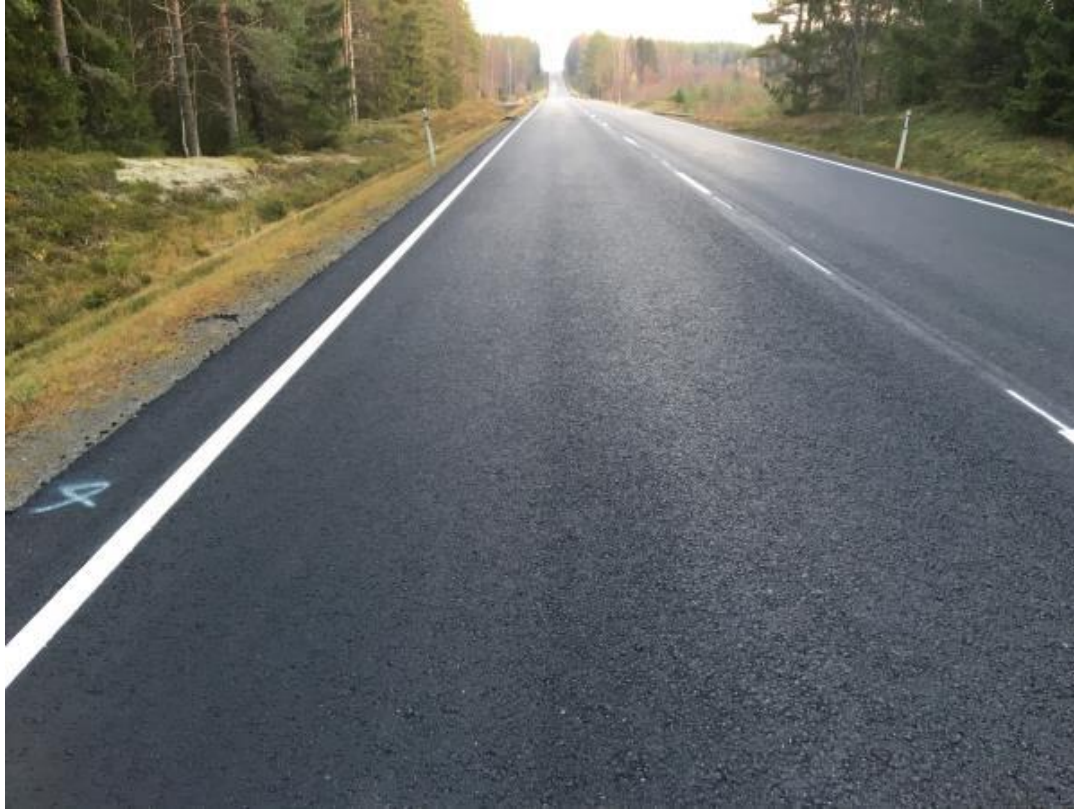
Kuva 8.1.2 Kt 68/33/2529 koeosuus, jossa lisäaineena SBS polymeeri Kraton. Kuva otettu 20.10.2016.
