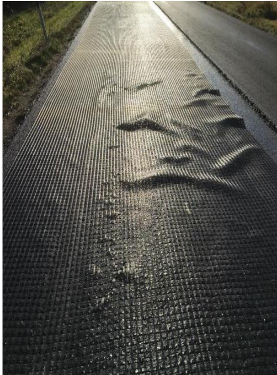
Kuva 9.2.2 Bitutex Stragrid -verkon leveys ei riittänyt keskisaumalle saakka ja keskisauman vieressä oli nähtävissä halkeama heti päällysteen tiivistyksen jälkeen.
