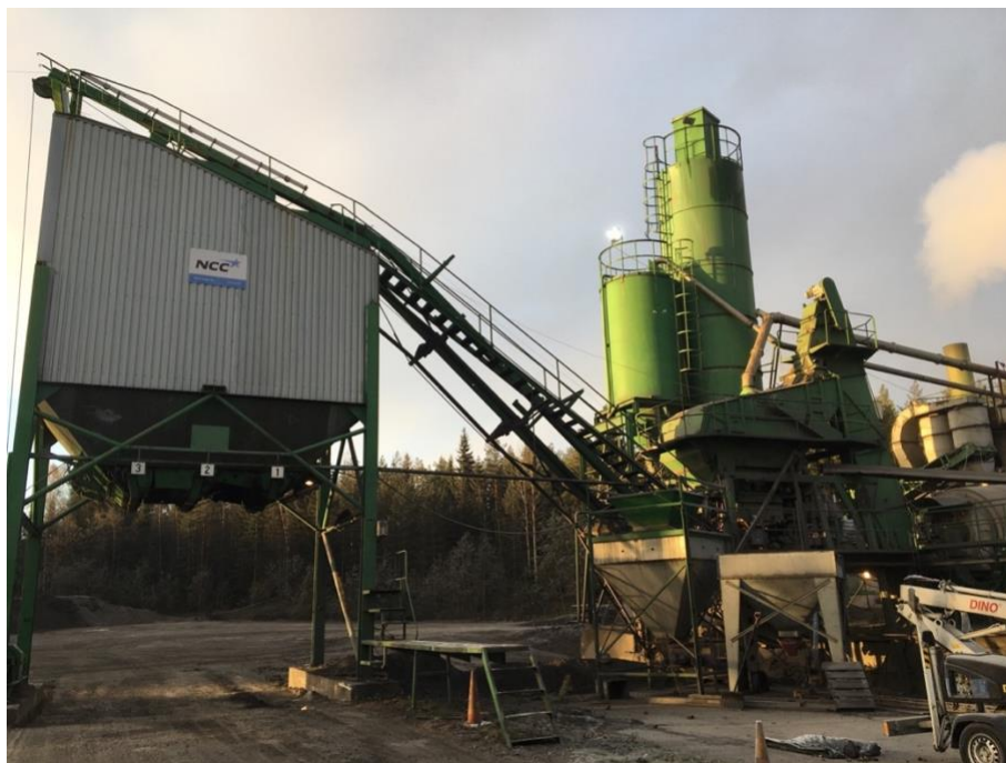
Kuva 4.1.2. Leppälaxin asfalttiasema, jossa sekoitettiin koetielle toimitettu asfalttimassa.
