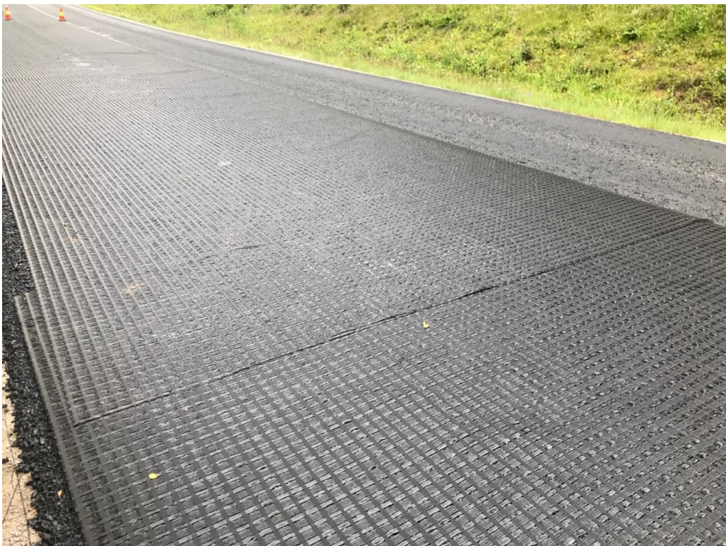
Kuva 32. Bitutex Stargrid 100/100 -lasikuituverkon päiden limittäminen.
