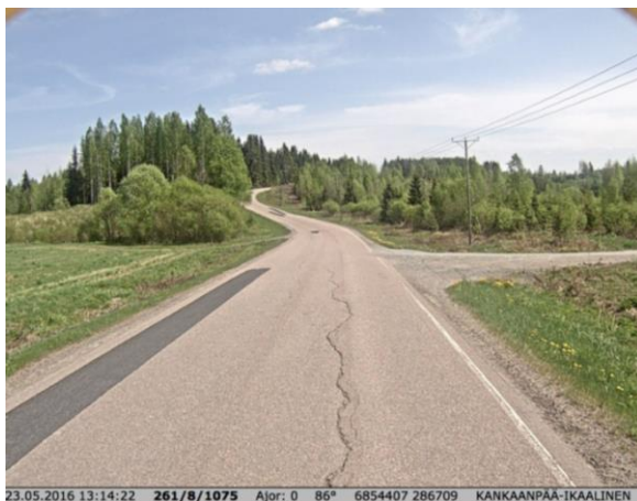
Kuva 36. Kuva kohdasta 261/8/1075 ennen koerakentamista vuonna 2016 ja 2 vuotta koerakentamisen jälkeen vuonna 2019. Sama halkeama on heijastunut uuteen pintaan (aramidikuitua sisältänyt koeosuus).
