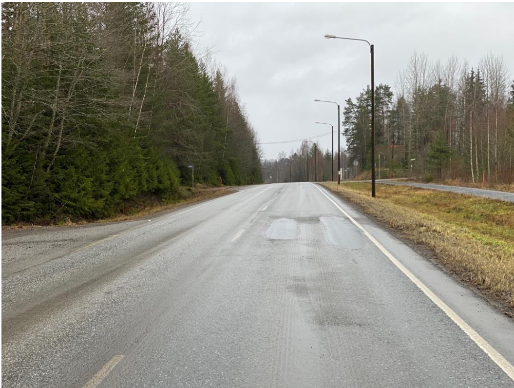
Kuva 12. Referenssiosuudelle (vasen kaista) ohuella AB-pintaauksella tehty paikkaus.
