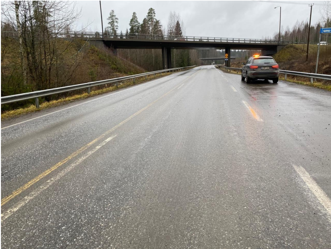
Kuva 8. Aramidikuitua sisältänyt koeosuus oikealla kaistalla. (Urautuminen nähtävissä syksyllä 2019)
