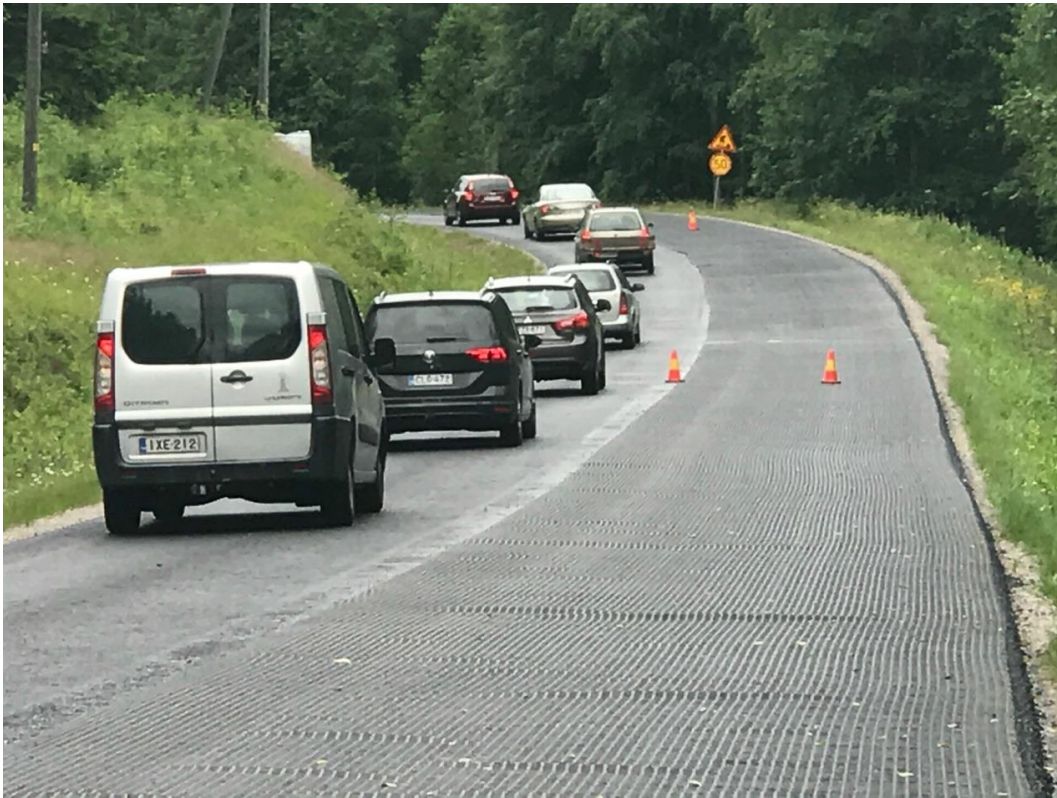
Kuva 33. Liikenteenohjaus lasikuituverkkoja asennettaessa.
