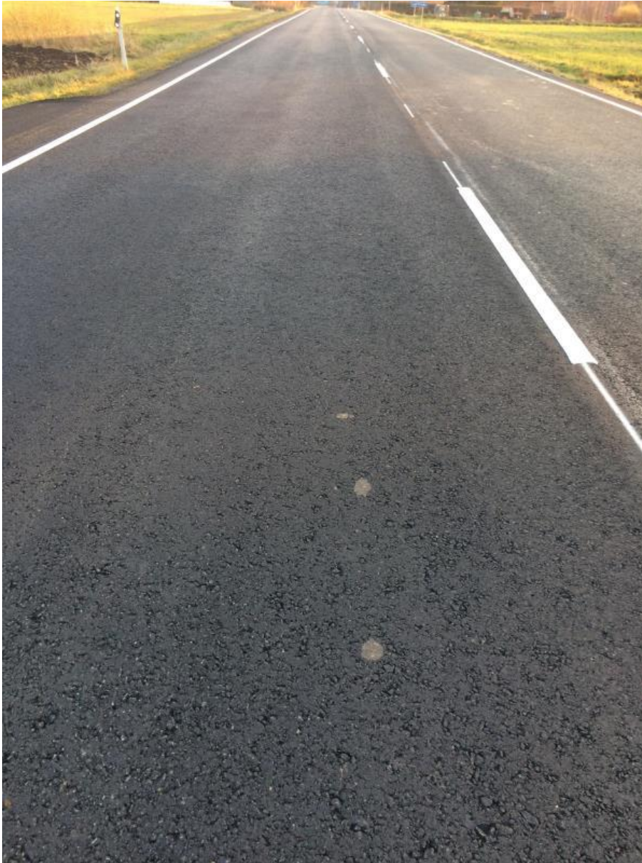
Kuva 21. Rubbertec-lisäainekoeosuudella oli pieniä sideainelaikkuja pinnassa.
