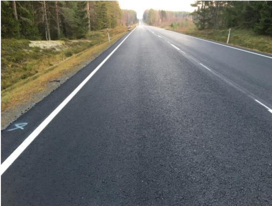
Kuva 18. Kt 68/33/2529 koeosuus, jossa lisäaineena SBS polymeeri Kraton. Kuva otettu 20.10.2016.
