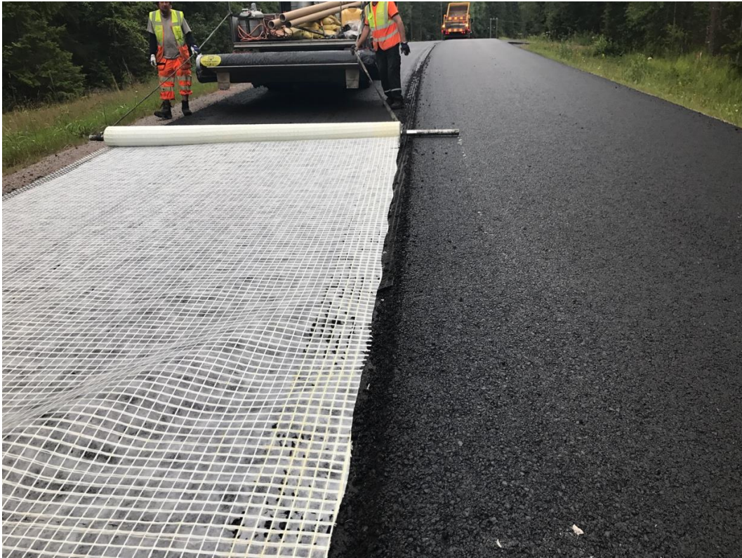
Kuva 27. Verkojen asennukseen kokeiltiin useita erilaisia levittämismenetelmiä.
