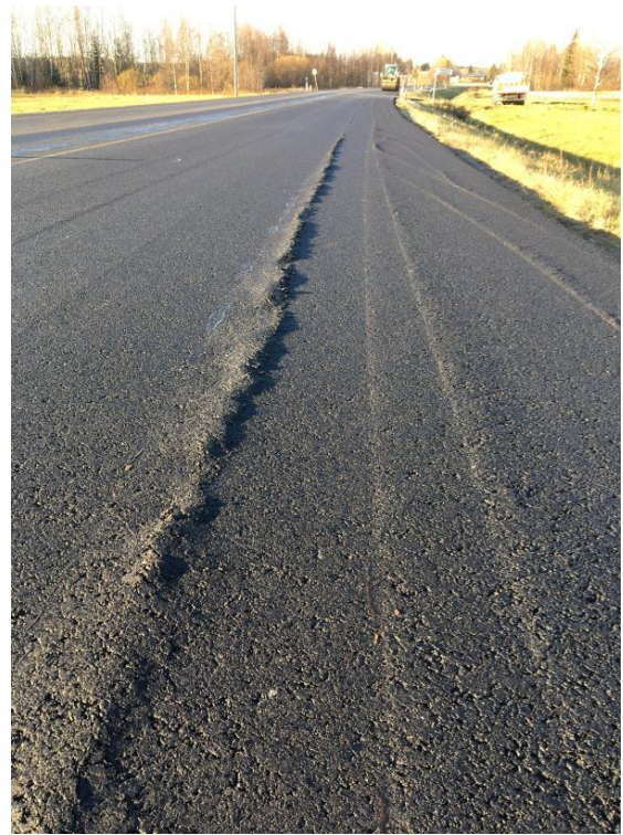
Kuva 16. Limittäen (3,05+1,5 m) asennetun Cidex SB 100 -verkon liukuminen tiivistettäessä (68/33/82-182).
