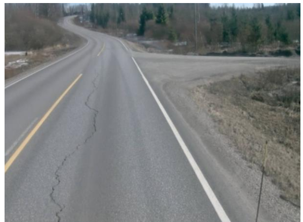
Kuva 36. Kuva kohdasta 261/8/1075 ennen koerakentamista vuonna 2016 ja 2 vuotta koerakentamisen jälkeen vuonna 2019. Sama halkeama on heijastunut uuteen pintaan (aramidikuitua sisältänyt koeosuus).
