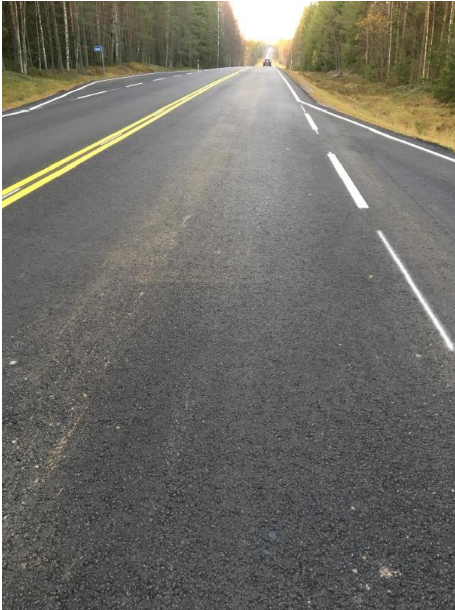
Kuva 20. VIATOP FEP -lisäainetta sisältänyt osuus.
