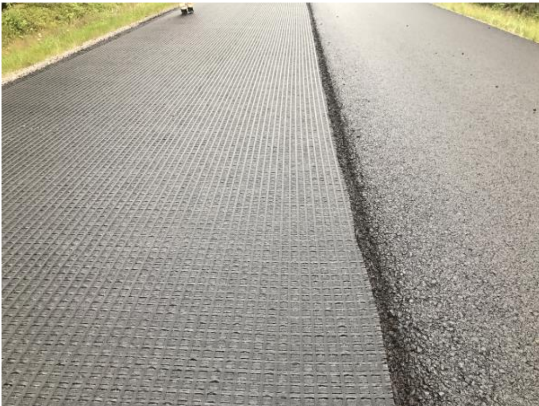
Kuva 26. Bitutex 100/100 -verkon asennus koekaistalle
