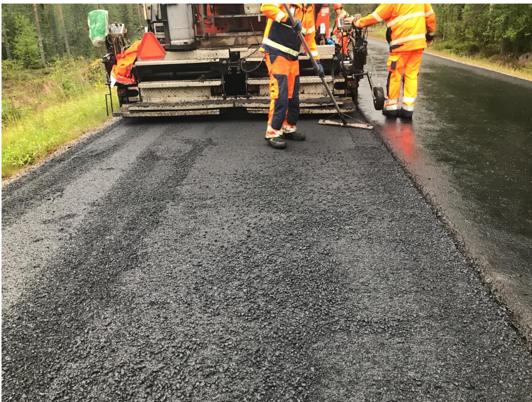
Kuva 28. Ohut suojamassa (AB 16) lasikuituverkon päälle asennettuna ennen tiivistystä.
