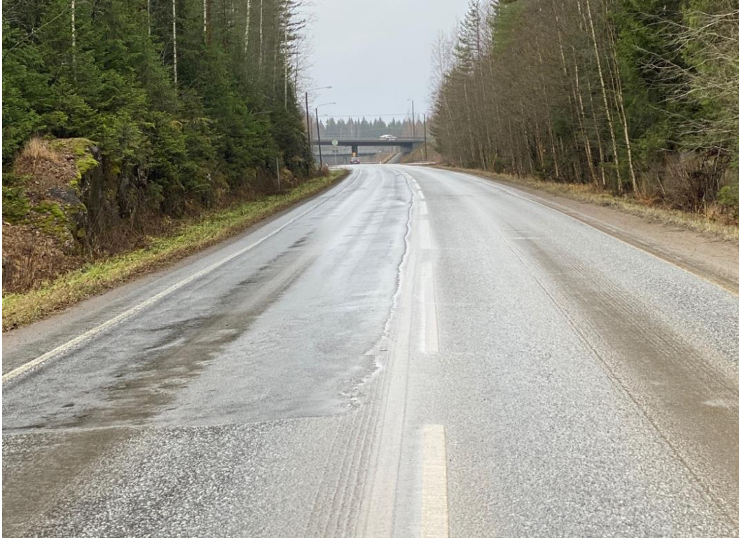
Kuva 12. Referenssiosuudelle (vasen kaista) ohuella AB-pintaauksella tehty paikkaus.
