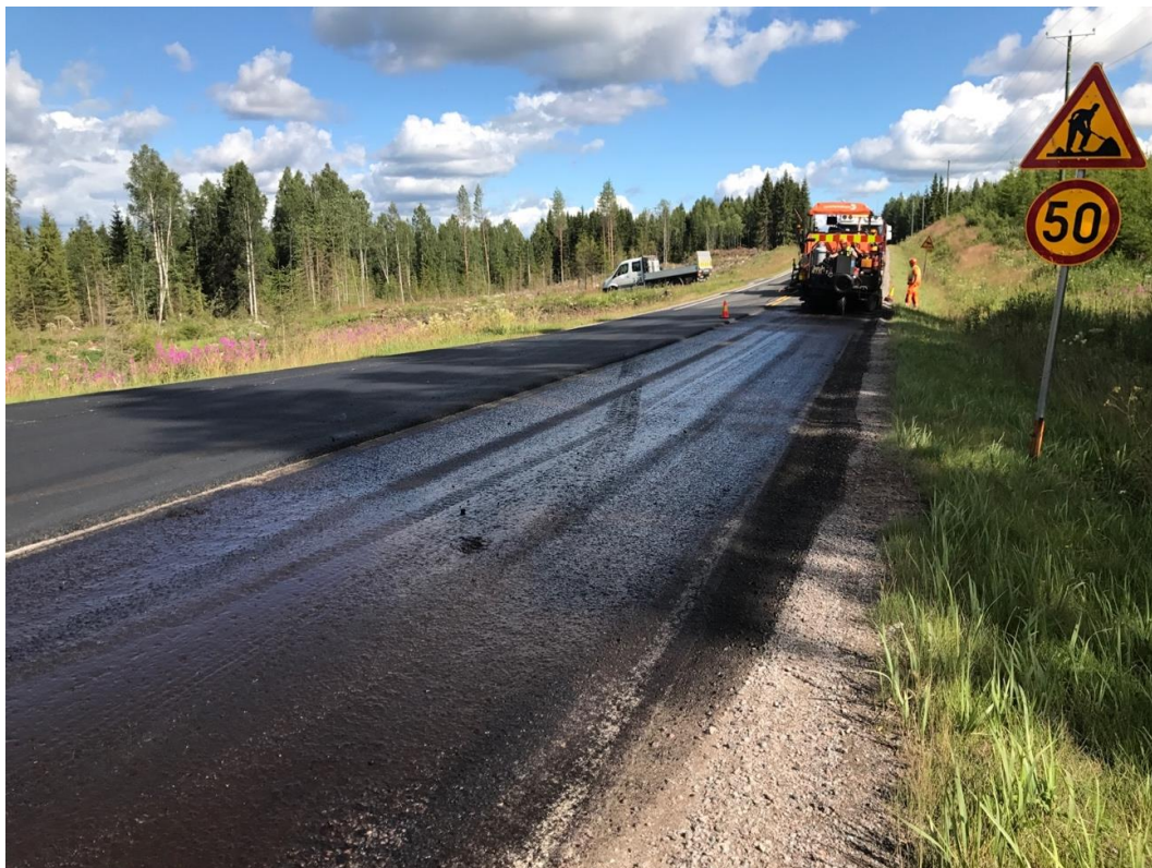
Kuva 30. Lasikuituverkon alustan liimausta bitumiemulsiolla.
