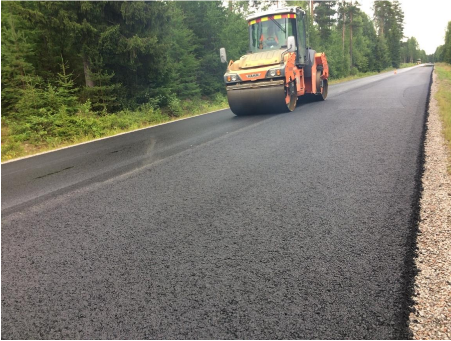
Kuva 35. Storelastic-osuuden tiivistys käynnissä.
