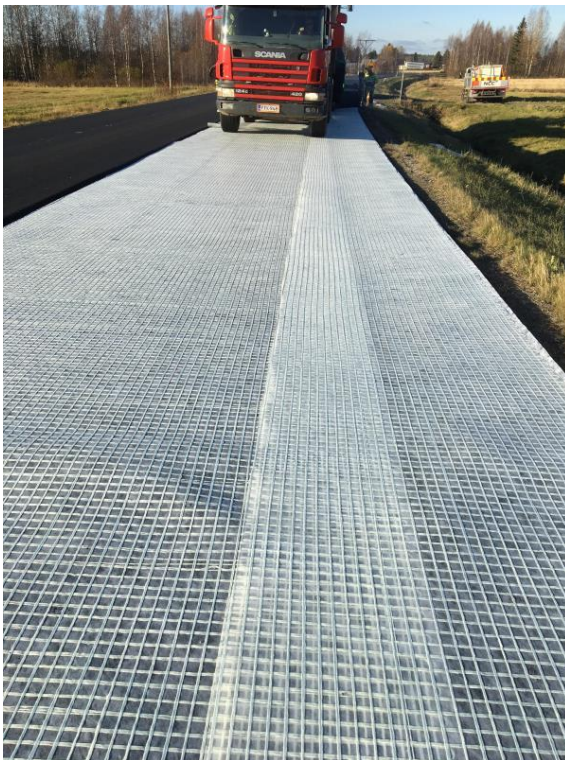
Kuva 16. Limittäen (3,05+1,5 m) asennetun Cidex SB 100 -verkon liukuminen tiivistettäessä (68/33/82-182).
