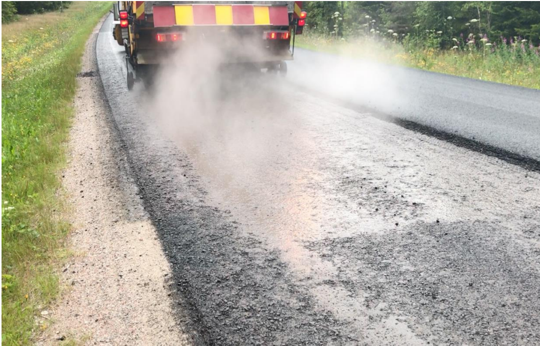
Kuva 31. Lasikuituverkon alustan liimaus kumibitumilla 300 g/m 2 .
