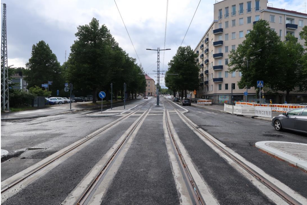
Kuva 17. Katurata on raitiotien rakennustavoista perinteisin. Radalla käytetään urakiskoa ja se on sulautettu ympäröivään kaupunkirakenteeseen ja liikennenympäristöön. Katuradan nopeus on sama kuin muulla kadulla kulkevalla liikenteellä. Kuva: Jouni Kiviniitty. Tampere, 9.7.2020.
