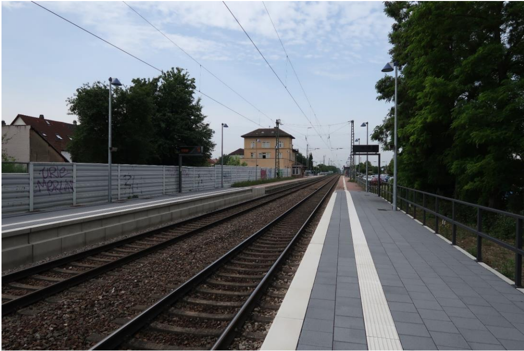
Kuva 18. Kaksi eri matkustajalaiturikorkeutta Karlsruheesta Heidelbergiin johtavalla pääradalla Saksassa. Kuvassa etualalla harmailla laatoilla päällystetyllä, 760 mm korkealla laiturisektorilla pysähtyvät alue liikenteen veturivetoiset aluejunat (Regionalbahn) ja sähkömoottorivaunut. Kauempana näkyvällä punertavalla laatoilla päällystetyllä, matalammalla, 550 mm korkealla laiturisektorilla pysähtyvät Karlsruhen duoraitiovaunut. Koska korkeusero on vähäinen (210 mm), on ero toteutettu loivalla luiskalla. Kuva: Jouni Kiviniitty. Weingarten (Württemberg), 11.6.2018.
