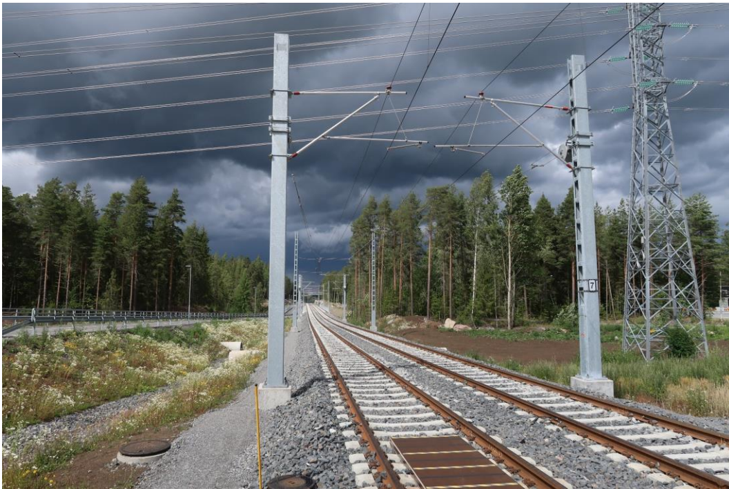
Kuva 15. Erillistrata kulkee omissa maastokäytävässään katuverkon ulkopuolella. Rata voi silti kulkea asutuksen keskellä, mutta risteävät kadut ja jalankulun ja pyöräilyn väylät toteutetaan joko eritasoratkaisuin tai varoituslaittoin varustettuin tasoristeyksin. Erillistradoilla voidaan ajaa enimmillään 70 km/h. Rataa ei ole välttämätöntä eristää aidoin. Kuva: Jouni Kiviniitty, Tampere, 9.7.2020.
