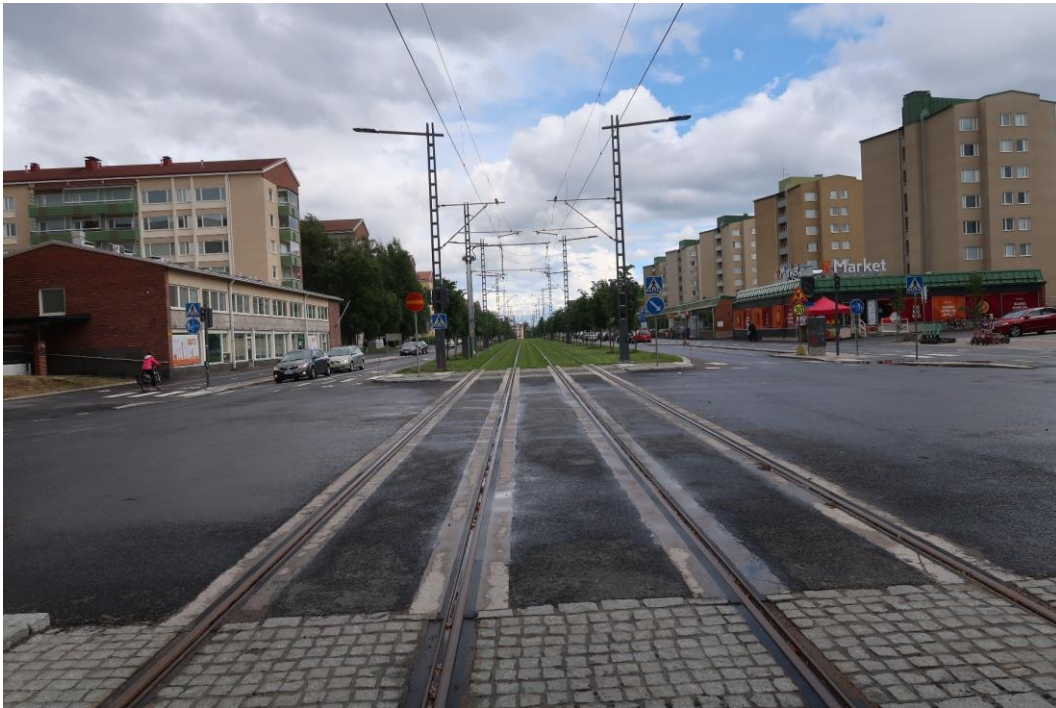
Kuva 16. Erotettu rata kulkee yleensä kadun reunassa tai sen keskellä. Rata erotetaan muusta kadulla kulkevasta liikenteestä viherkaistoin ja istutuksin. Aitoja ei yleensä käytetä. Erotetun radan nopeus on sama kuin muulla kadulla kulkevalla liikenteellä. Kuva: Jouni Kiviniitty. Tampere, 9.7.2020.
