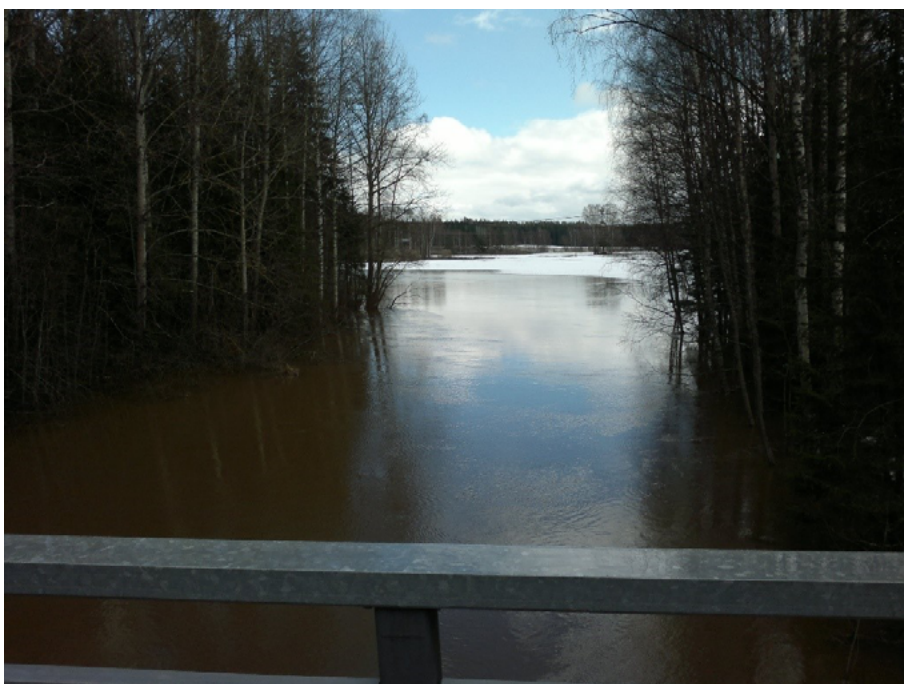
Kuva 15. Puujoki 18.4.2012, Varunteenkoski ylä (Hausjärvi). Kuva: Jouni Riihimäki
