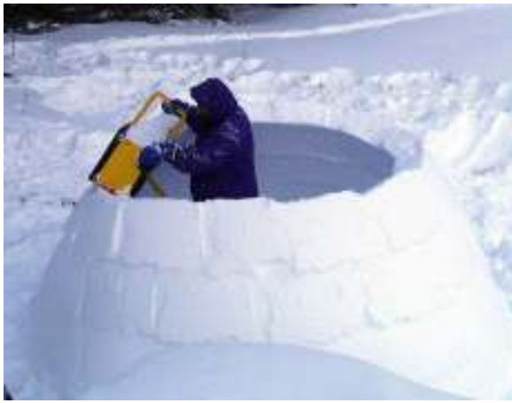
Kuva 27 Iglun rakentaminen lumiharkoista[66]
