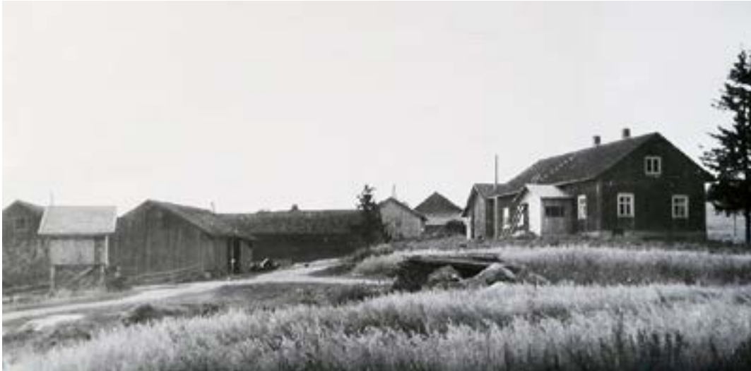
Pihapiirin rakennuskantaa 1950-luvun jälkipuoliskolta. Oikealla päärakennus, jonka takana pilkottaa aitta. Aitan takana näkyy riihi. Vasemmanpuolimmainen rakennus on navetta ja sen vieressä on kermalaituri. Lisäksi pihapiiriin kuului myös jäävarasto, tallirakennus ja lato. Kuva Keijo Luostarisen kokoelma.
