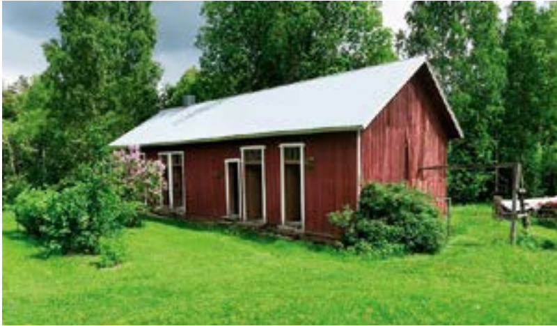
Koulun vieressä oleva varastorakennus lienee valmistunut samoihin aikoihin koulurakennuksen kanssa. Tähän viittaavat ovien yläpuolella olevat pieniruutuiset ikkunat. Kuva Pekka Piiparinen.
