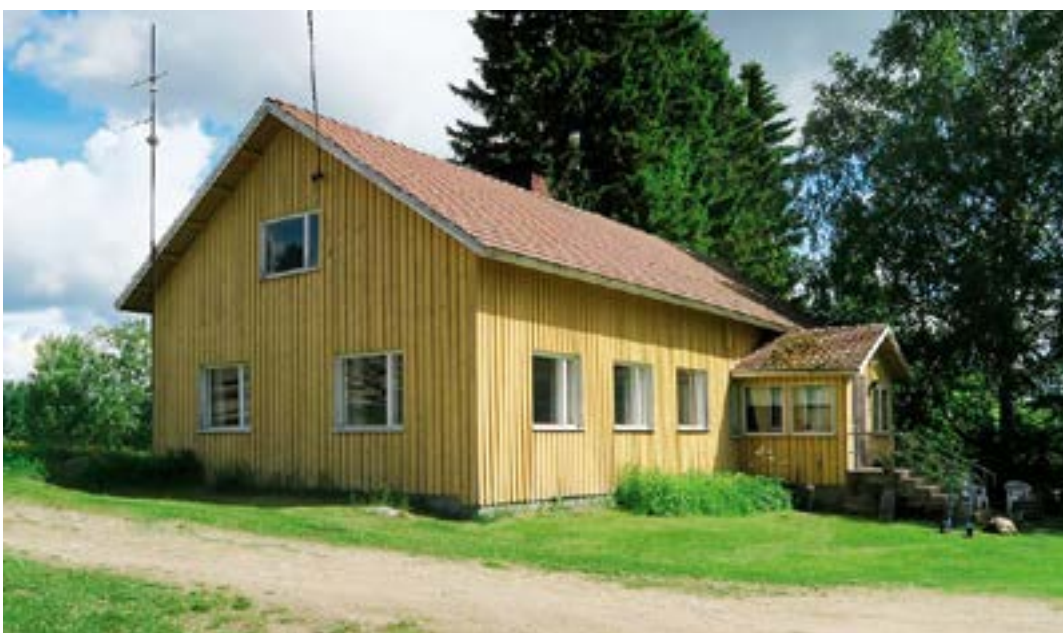
Päärakennuksen ulkoinen olemus on lähes täysin 1960-luvun lopun asussa. Viimeisin ulkomaalaus on vuodelta 1991. Kuva Pekka Piiparinen.
