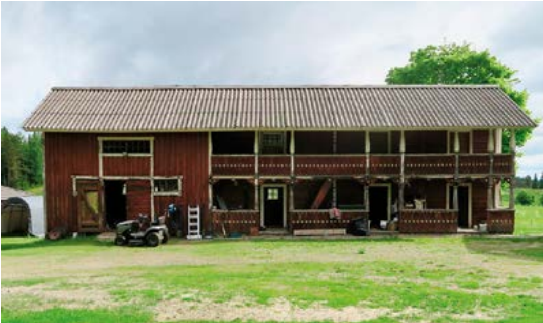
Kaksikerroksinen luhtiaitta-osuus on valmistunut vuonna 1869, sen sijaan vasemmanpuoleinen lautarunkoinen osa on nuorempi. Kuva Pekka Piiparinen.
