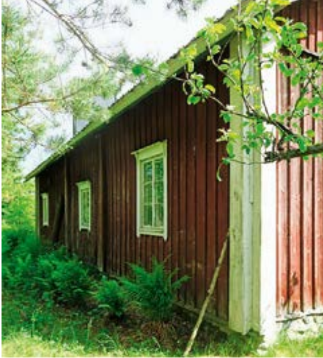
Rakennuksen julkisivut ovat pystyrimalautoitettuja ja ikkunat ovat kuusiruutuisia. Kuva Pekka Piiparinen.
