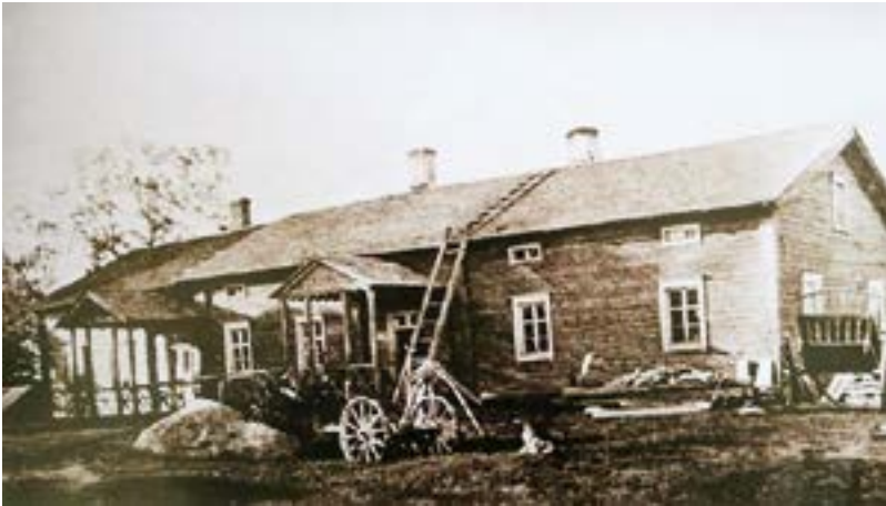
Ajoittamaton kuva Pennalan päärakennuksesta. Kuvassa olevat kivistit on korvattu uusilla ja pienet ullakkoikkunat on poistettu. Kuva Jaana ja Matti Ahtiaisen kokoelma.
