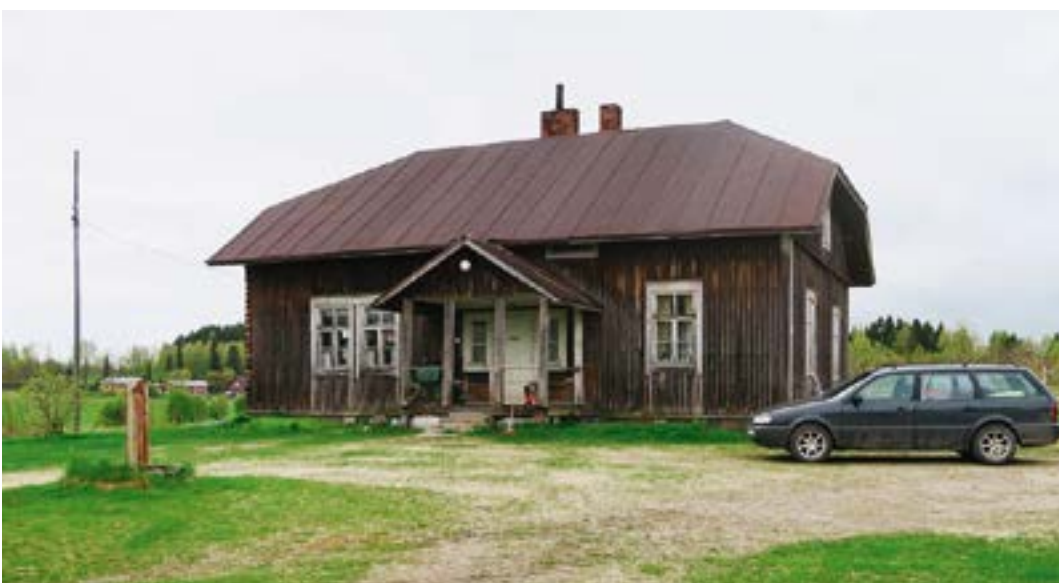
Aholan päärakennuksen kate on satulakatto, mutta katon päädyt ovat viistetyt. Kuva Pekka Piiparinen.
