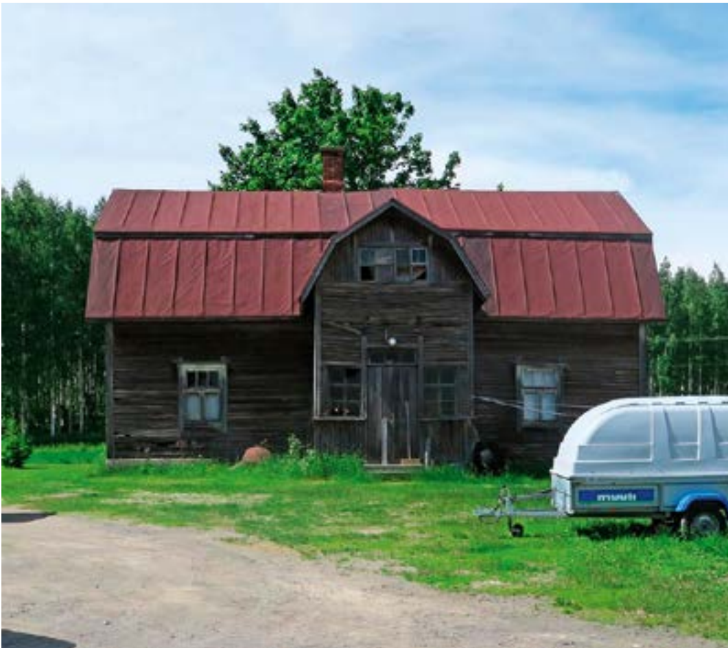
Päärakennusta pihan suunnalta kuvattuna. Sekä päämassassa että kuistissa on mansardikatot. Kuva Pekka Piiparinen.
