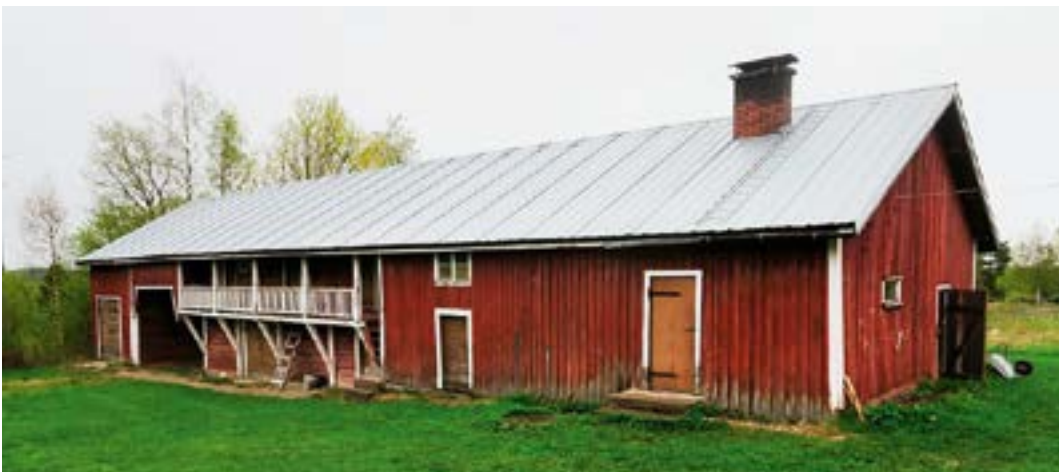
Aitassa on kaksikerroksinen luhti-aitta-osa ja sen vieressä pohjoiskarjalaisittain harvinainen läpiajettava aittarati. Kuva Pekka Piiparinen.
