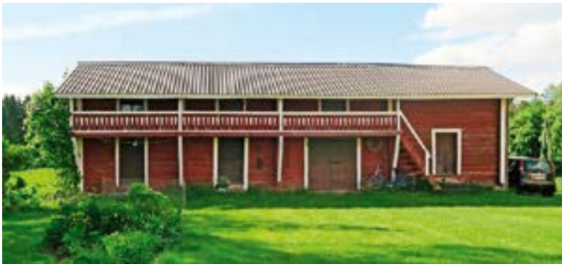
Aitassa on kaksikerroksinen luhtiaitta-osuus ja oikealla on yksikerroksinen entinen vilja-aitta. Kuva Pekka Piiparinen.
