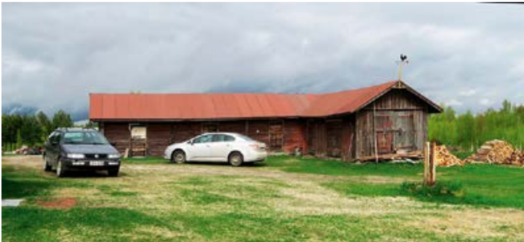
Aittarakennus on vinkkelinmuotoinen. Itäisempi osa on hirsirunkoinen ja eteläosa lautarunkoinen. Kuva Pekka Piiparinen.
