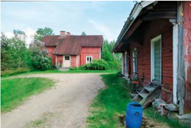
Uusi-Kolehmalan ydinpihapiirin muodostavat taustalla näkyvä päärakennus ja oikealla oleva aitta. Kuva Pekka Piiparinen.
