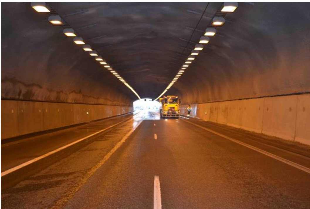
Kuva 20. Näkymä Isokylän eteläisen tunnelin sisältä länteen päin. (Taitorakennerekisteri 2020)
