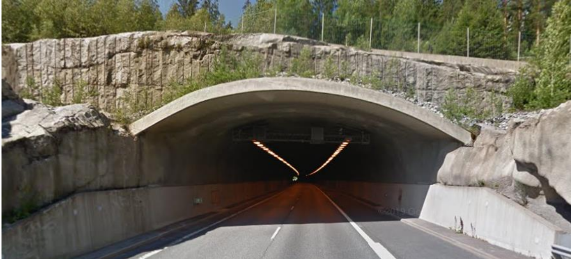
Kuva 38. Näkymä pohjoisen ajoneuvotunnelin itäpäästä (Google Maps 2020).
