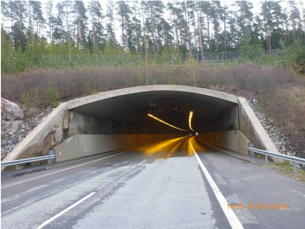
Kuva 19. Isokylän eteläisen tunnelin länsipään suuaukko. (Taitorakennerekisteri 2020)
