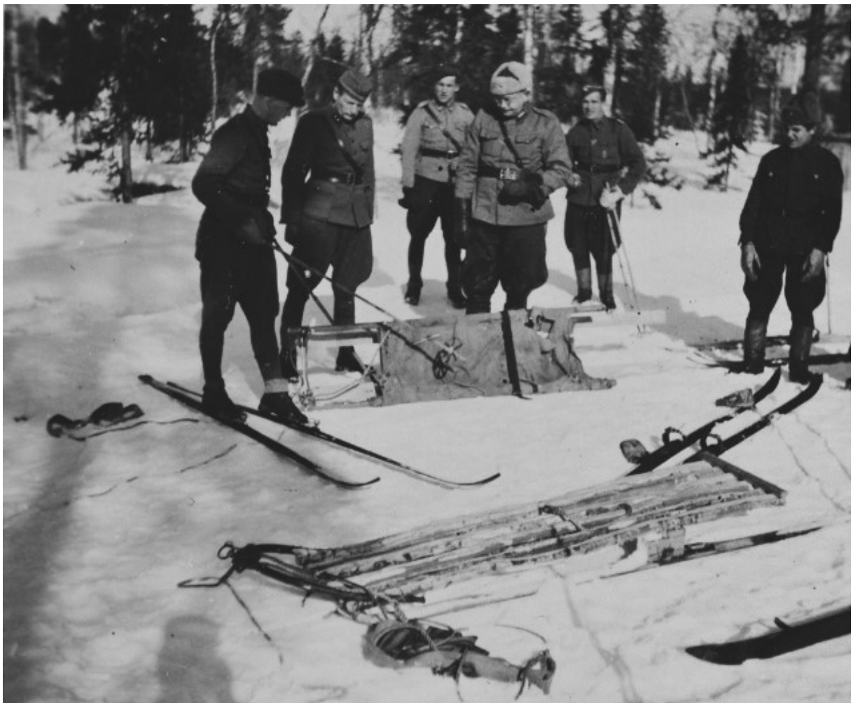
Kuva: 10: Luutnantti Ahola ja kapteeni Paatsalo tarkastelevat erilaisia suksiahkioita. Suksiahkioiden välissä avositeillä varustetut partiosukset. Suksiahkiota esittelevällä luutnantilla käytössä kiintositeet. 142
