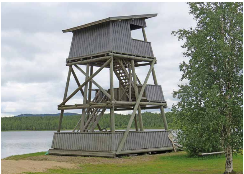
Helposti saavutettava lintutorni Naapurinvaaran lomakeskuksen rannassa. Kuva Liisa Korhonen.
