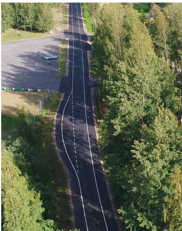
Kuva 24. Tiemerkinntä ylhäältä katsottuna.
