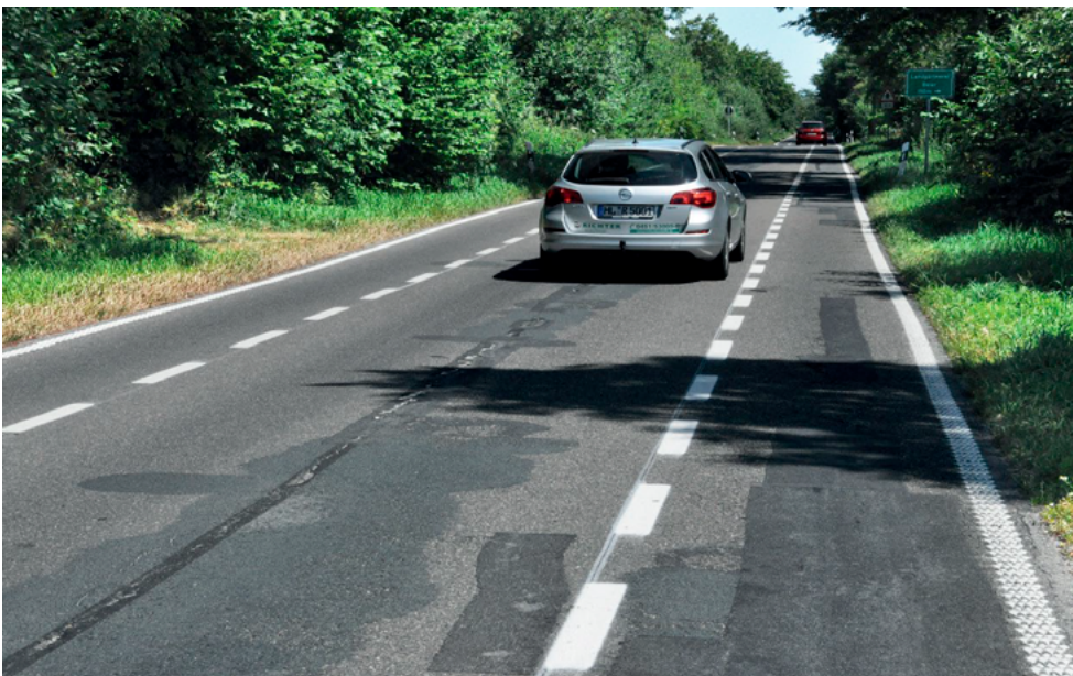
Kuva 7. Hoisdorf, Saksa Pituussuuntaisissa tiemerkinnoissä käytetty yhtenäistä ajoradan reunaviivaa ja katkonaista kaistojen erotusviivaa. Kuva Ministère du Développement Durable et des Infrastructures. Département des Transport. Luxemburg. 2018. I-03.
