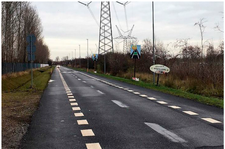
Kuva 10. Silkeborg, Tanska 2-1 -tieksi muutettu maantie. Huomaa käytöstä poistetut vanhat kaistaviivat tien keskel- lä. Kuva: https://idekatalogfor- cykeltrafik.dk/2-minus-1-veje/
