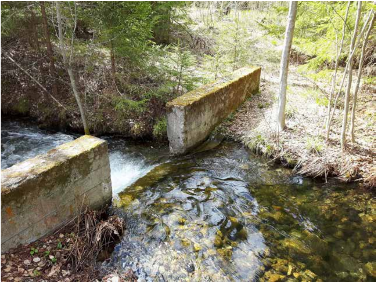
Kuva 2: Kuoringanpuron betoninen pohjapato Kuoringan luusuassa. Kuvaaja: Mira Lukkarila, 23.5.2017.
