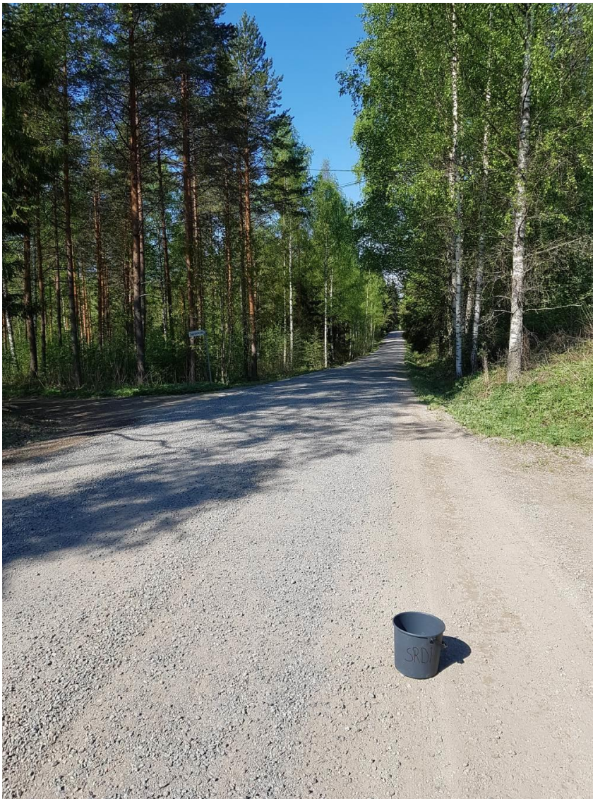
Kuva 24. Soratien pinta alueurakan SRD kohteessa 1.
