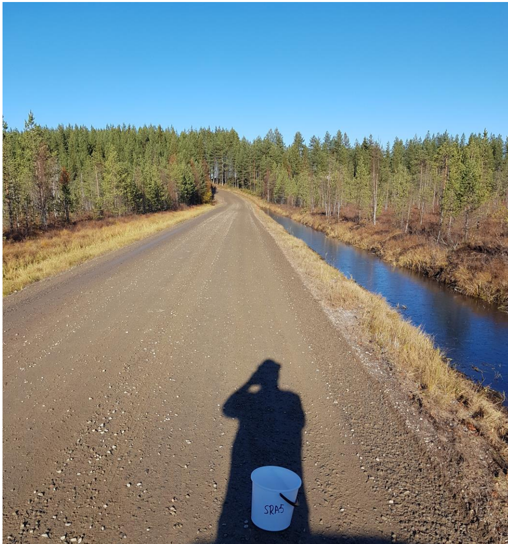
Kuva 9. Soratien pinta alueurakan SRA kohteessa 2.
