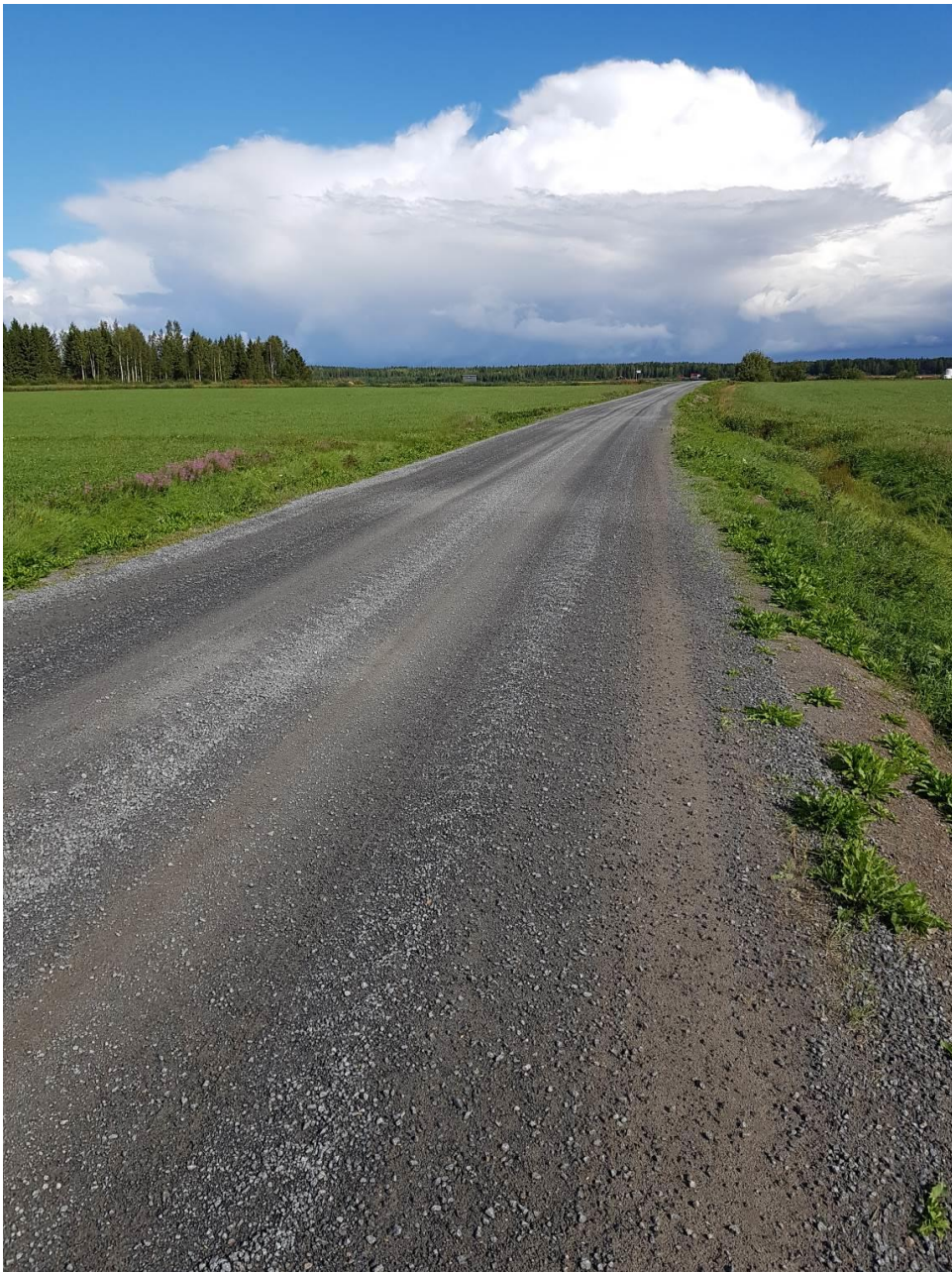
Kuva 15. Soratien pinta alueurakan SRB kohteessa 2.
