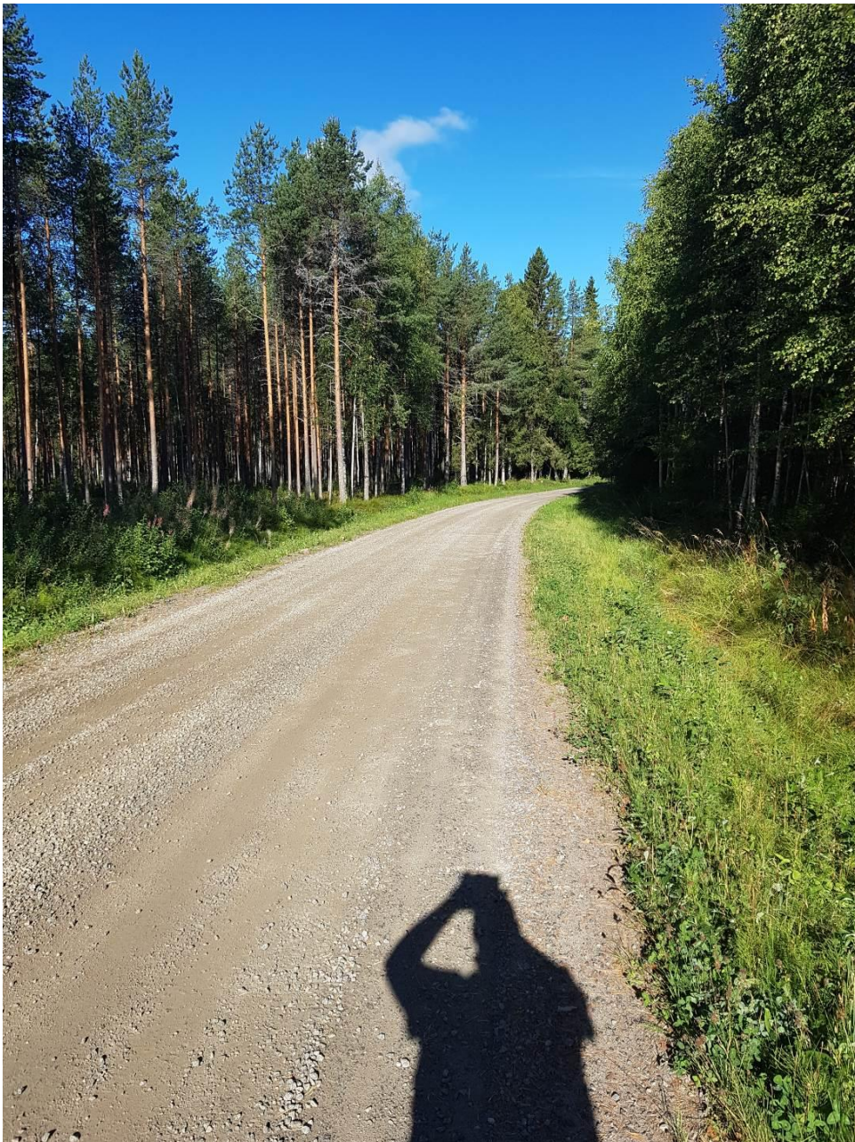
Kuva 12. Soratien pinta alueurakan SRB kohteessa 1.
