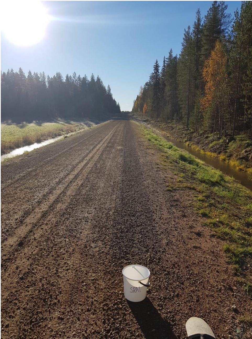
Kuva 6. Soratien pinta alueurakan SRA kohteessa 1.
