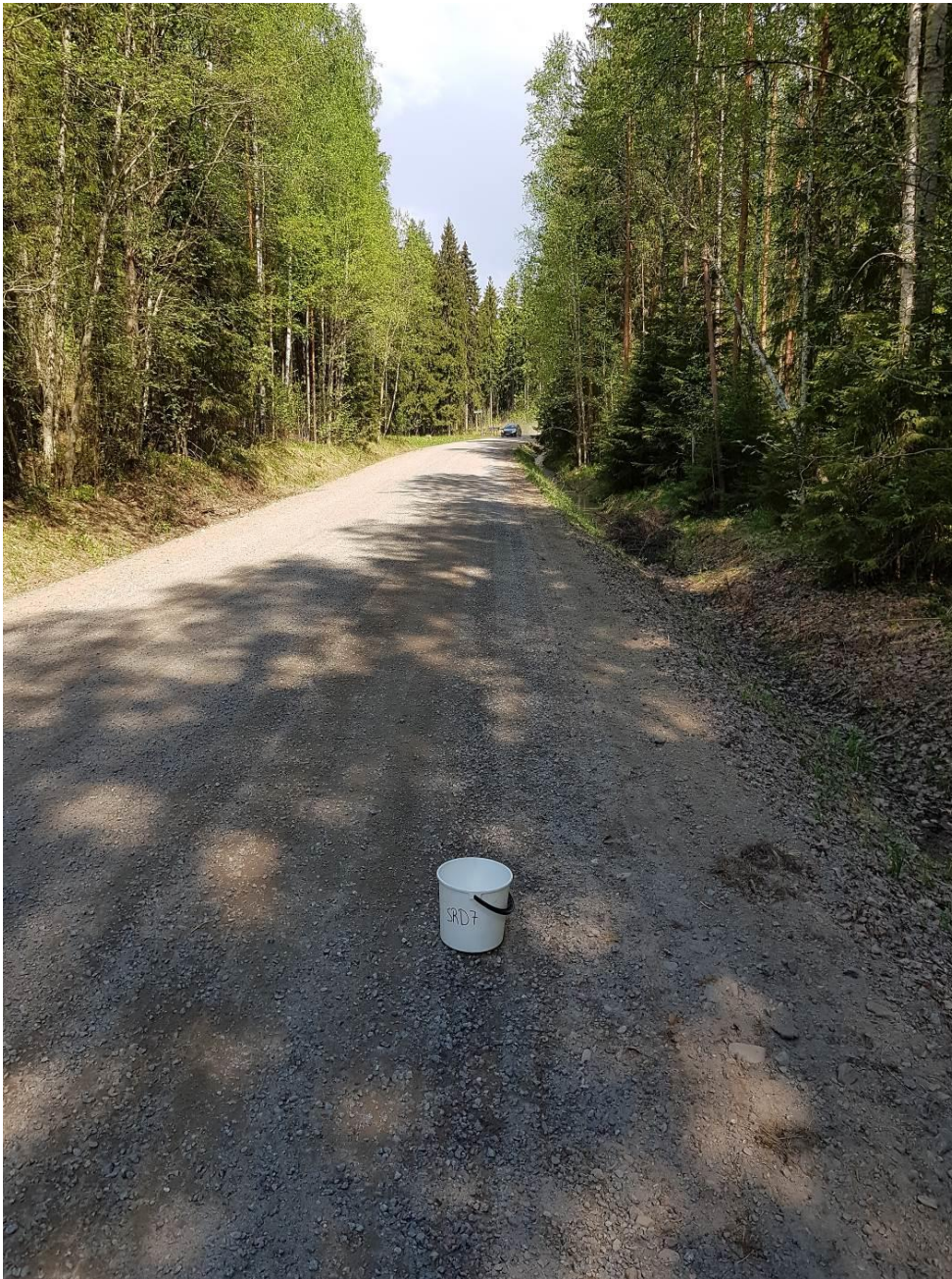
Kuva 27. Soratien pinta alueurakan SRD kohteessa 2.
