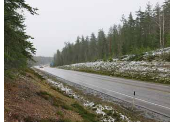
Kuva 2.2. Valtatie 25 on suunnittelualueella pääosin kaksikaistainen tie.
