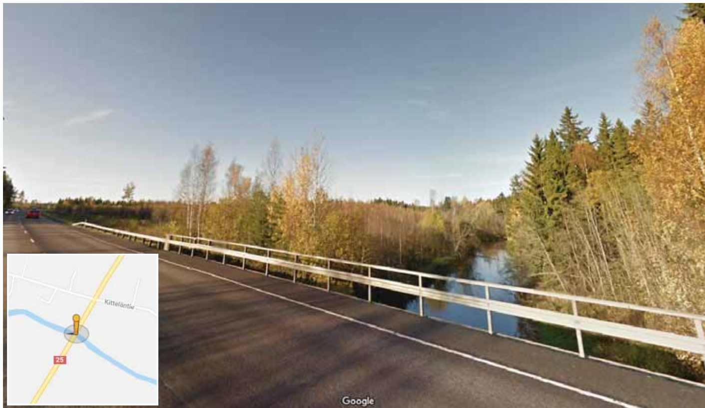
Kuva 2.38. Näkymä Vantaanjoen ylityksen kohdalla. Kuva © Google Street View.
