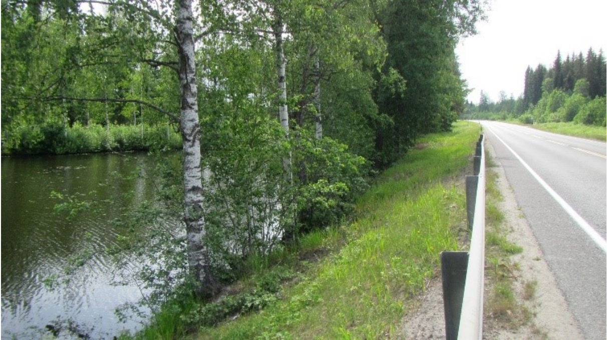
Kuva 18. Silmäankannon länsipuolella sijaitsevan Tukkilammen kohdalla riista-aita on sijoitettava luiskan alareunaan. Puut täytyy osittain poistaa luiskasta ja kuusten alaoksia karsia. Tien vastakkaisella puolella tiealue on laajempi, ja aita mahtuu hyvin tiealueelle. Laura Soosalu
