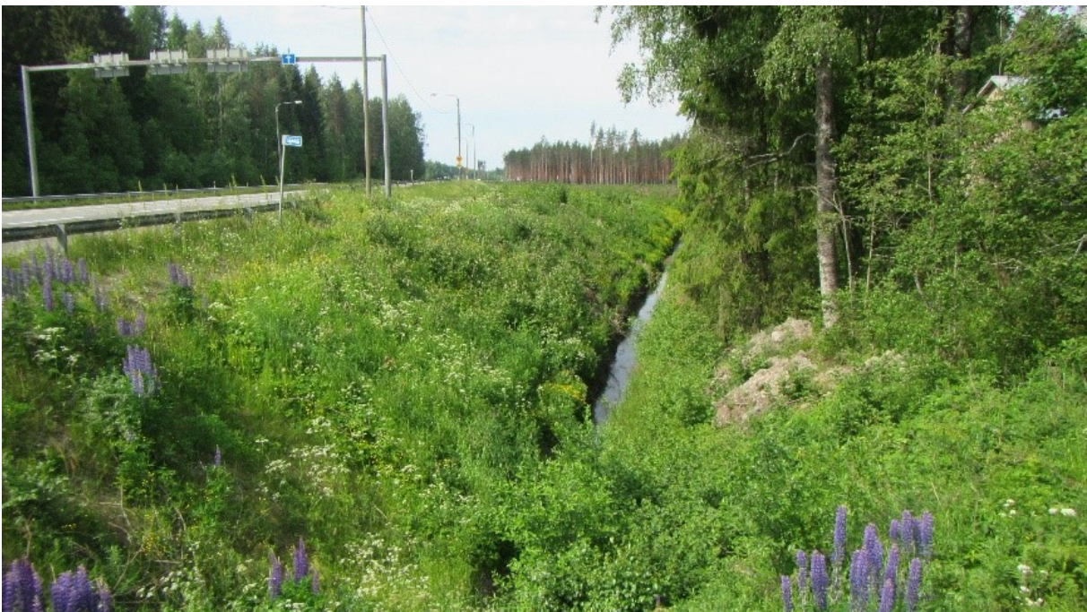
Kuva 19. Kormun liittymässä, Makkarahuhdansuon puolella, on syvä oja, ja riista-aita sijoitetaan tien puoleiseen luiskaan. Laura Soosalu
