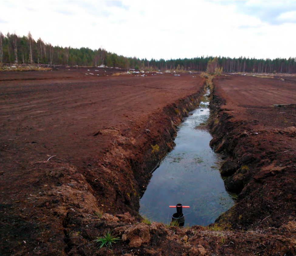
Turvetuotantoalueen sarkaoja, jossa lietesivennys ja päisteputki. Kuva: Ari Koski.
