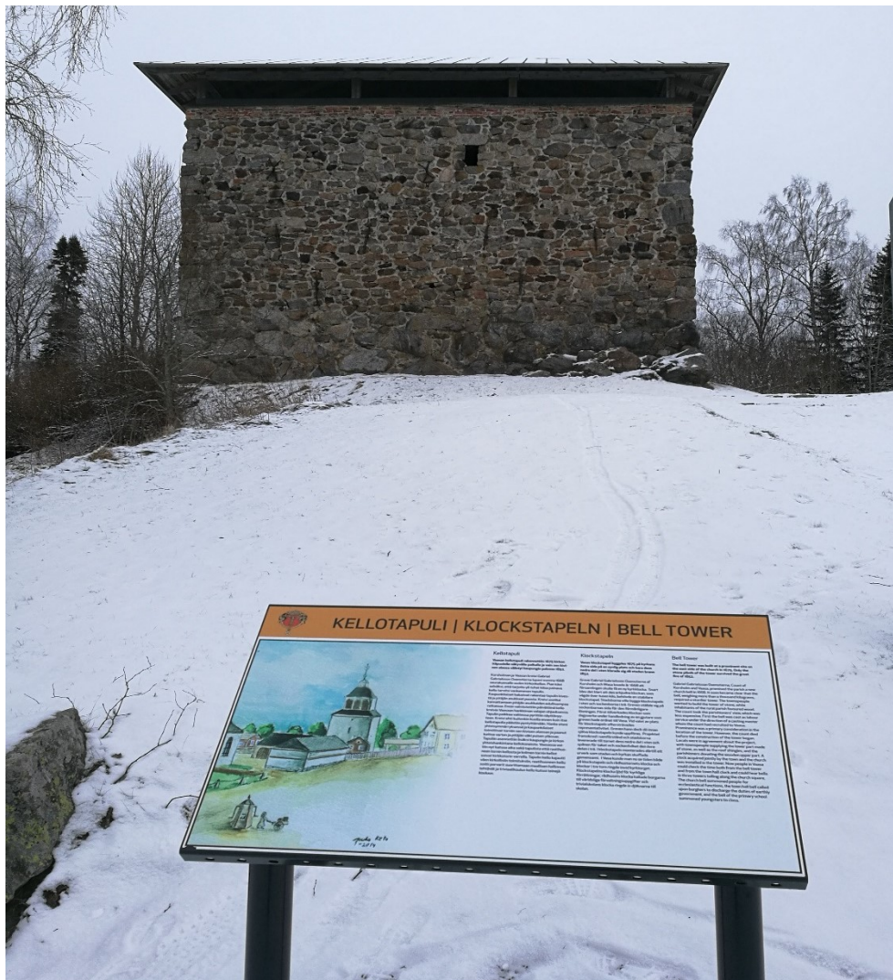
Bild 5 Klockstapel med objektsskylt. Fotograf Mattias Boije.
