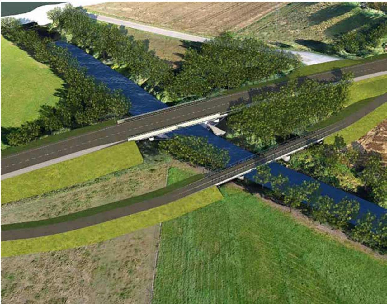
Kuva 27. Vantaanjoen ylitys ja erillinen kevyen liikenteen vesistösilta
