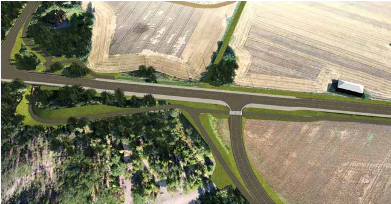
Kuva 26. Jalankulku- ja pyörätie alkaa kantatien 45 varrella Rantakulmantien liittymän alikulusta.
