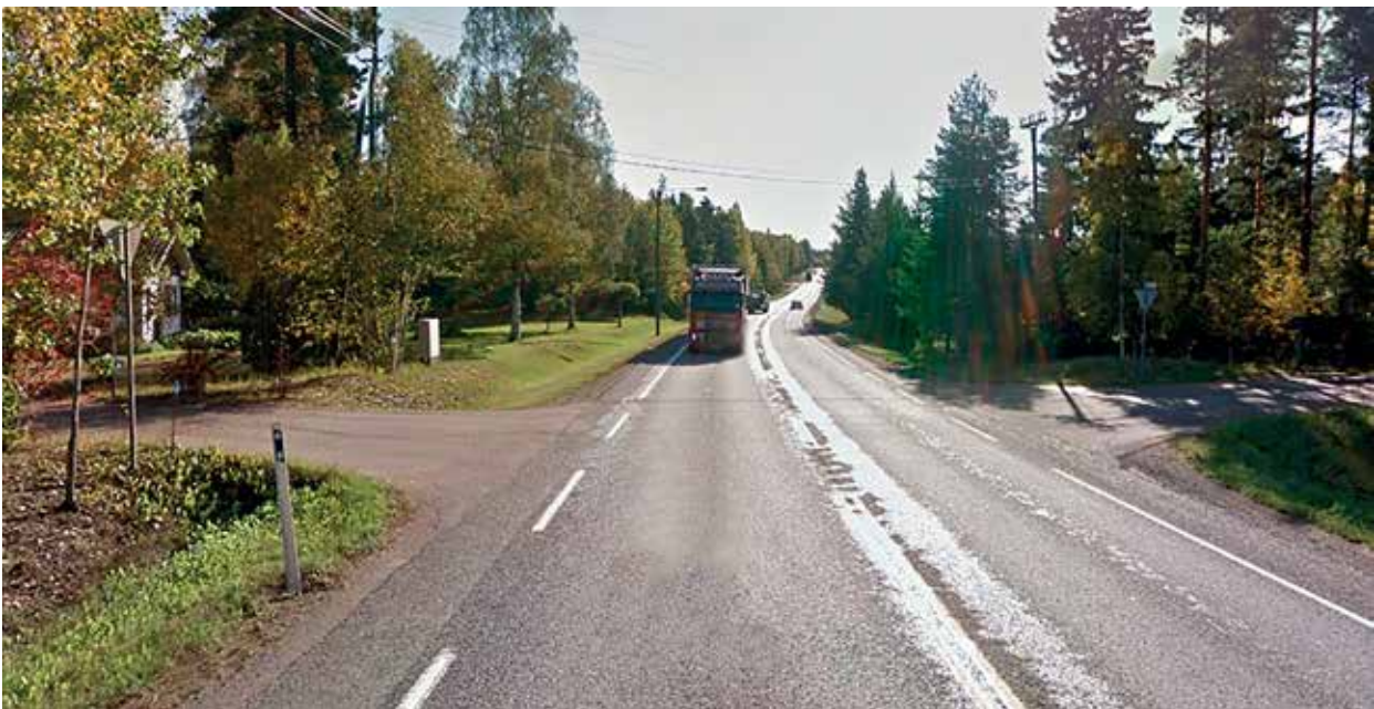
Kuva 1. Kantatiellä 45 (Hämeentiellä) on runsaasti nelihaaraliittymiä ja poikkileikkaus on kapea suhteessa liikenteen nopeustasoon. Jalankululle ja pyöräilylle ei ole erillistä väylää
