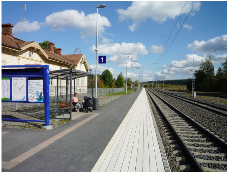
Kuva 23. Karkun aseman matkustajalaituri ja kulkuyhteys pysäköinti-alueelta on toteutettu esteettömästi. Vapaan tilan (tumma asfaltti) ja vaara-alueen (harmaa laatoitus) välillä tulisi lisäksi ohjeen (Rato 16)
