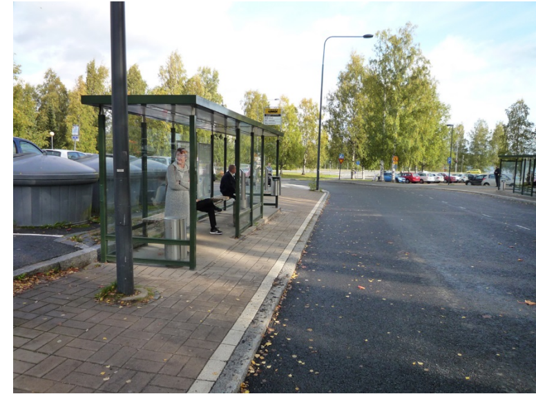
Kuva 22. Ylöjärven Matkatien pysäkkien odotustilan korotus ajorataan nähden toteutuu jalkakäytävän korotuksella. Pääsy suojaisaan katokseen on esteetön toisesta päädyistä, mutta katoksen mitoitus on esimerkiksi pyörätuolilla liikkuvalla liian kapea. Odotustila tulisi erottaa kulkuväylästä, mutta se on tilanpuutteen vuoksi paikoin vaikeaa.
