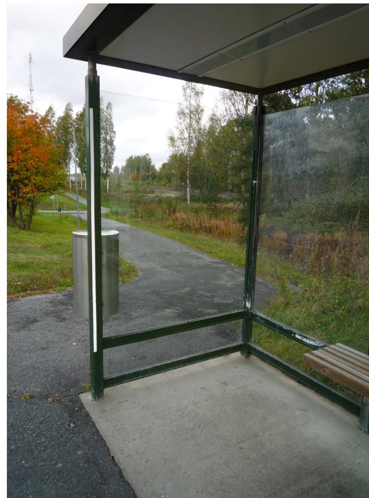
Kuva 26. Heijastinnauha Ylöjärven Urheilutalon pysäkkikatoksessa kantatien 65 varressa
