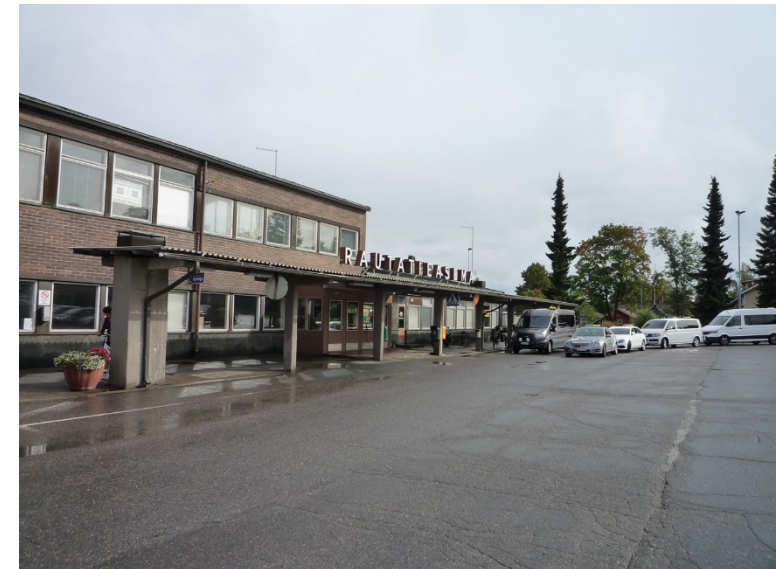
Kuva 11. Toijalan rautatieasemalla Akaassa linja-autopsäkki on aseman ulko-ovien vieressä, saman katoksen alla ja taksipalvelut toisessa päädyssä
