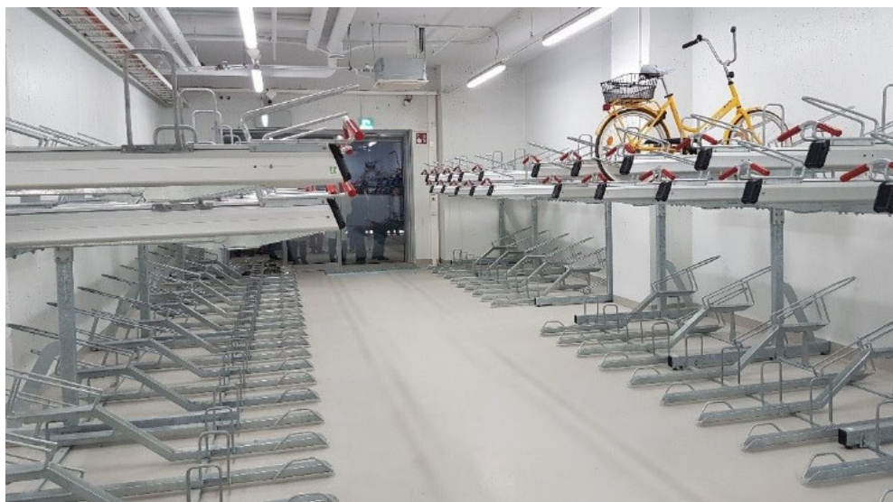
Kuva 11. Tikkurilan pyöräpysäköintihallissa on 164 pyöräpaikkaa kahdessa tasossa. Valvottuun, puolilämpimään tilaan pääsee HSL:n matkakortilla. Kuva: Vantaankaupunki
