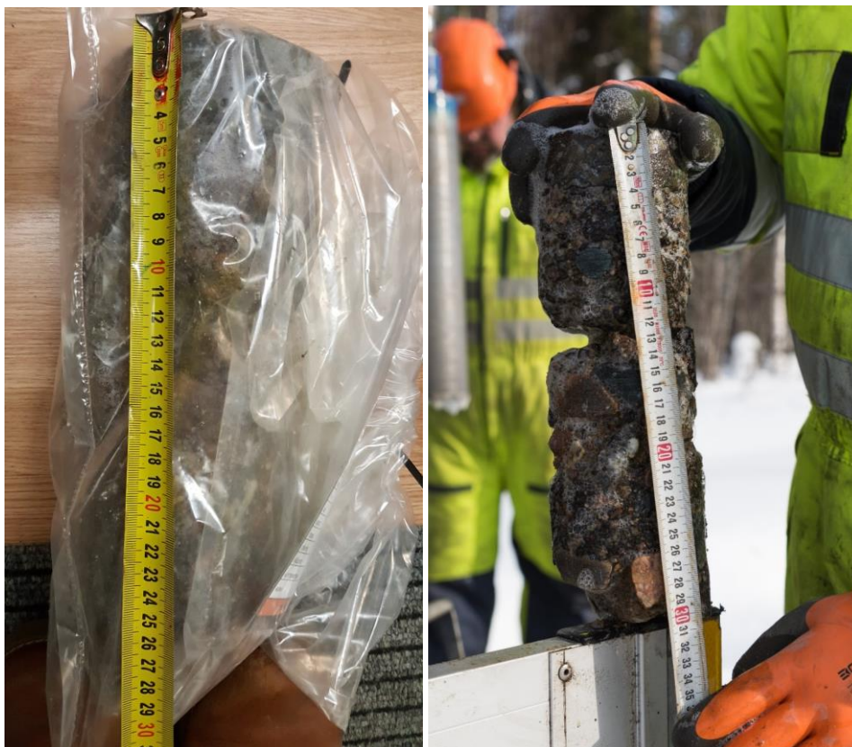
Kuva 16. Esimerkki osittain murentuneesta näytteestä, tie 942.
