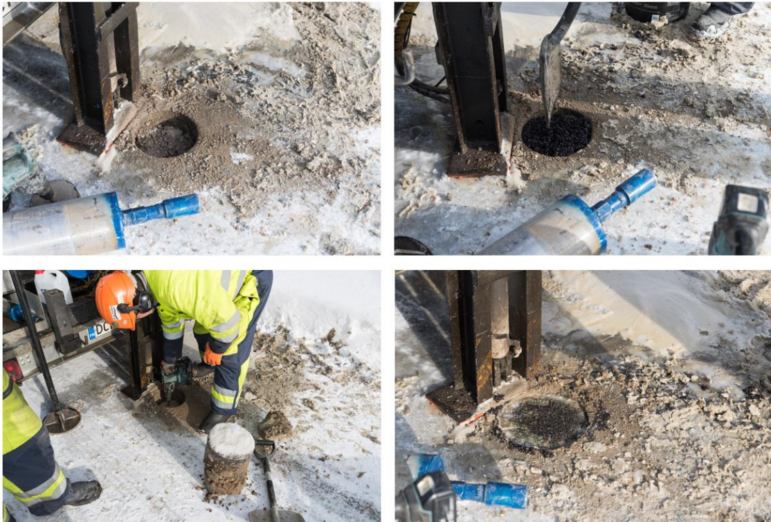
Kuva 11. Step by step-kuva reikien paikkaamisesta.
