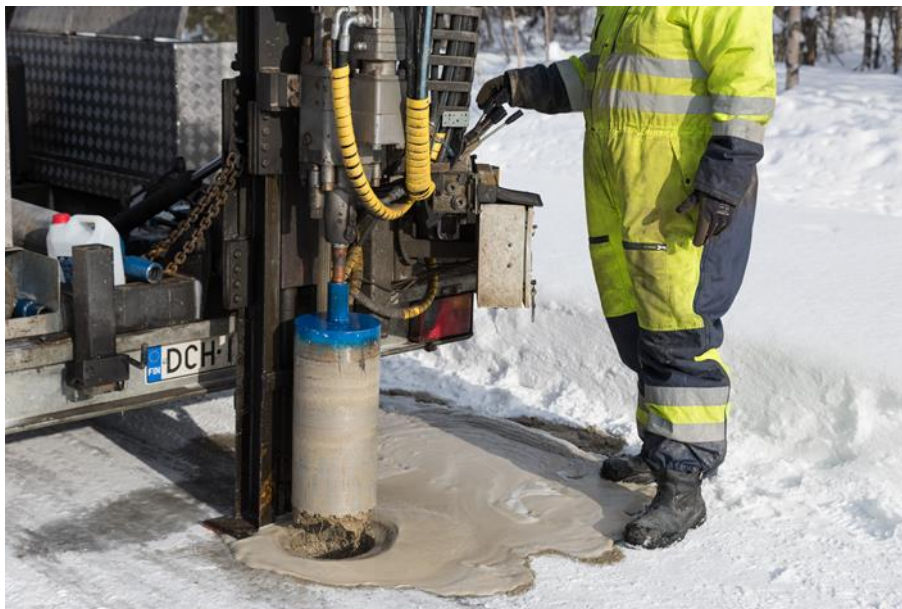
Kuva 13. West Coast Road Masters Oy:n timanttikaira.
