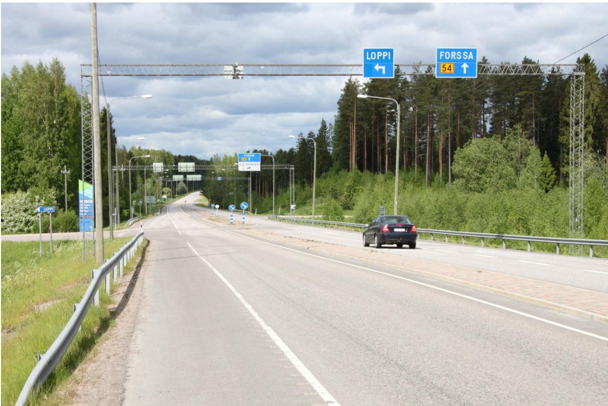
Kuva 10. Kantatien 54 ja Yhdystien (mt 13609) nykyinen korokkein kanavoitu tasoliittymä. Eritasoliittymän siirtopaikka on esitetty kuvan auton oikealle puolelle tiekaiteen taakse, Yhdystien linjalle.
