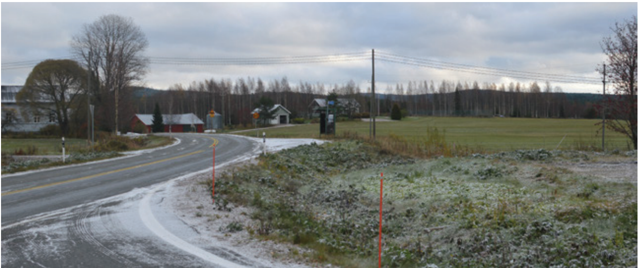
Sulkavantien risteys Sairalanmäentien puolelta kuvattuna Hiismäen suuntaan, parkkialue on oikealla.
