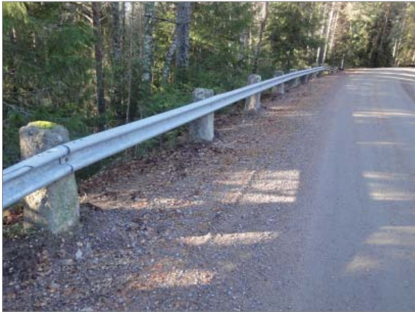
Työ on tehty huolellisesti. Tiepalle, "jätkänpolku", on poistettu kaitteen kohdalta. Kuva Martti Piltz
