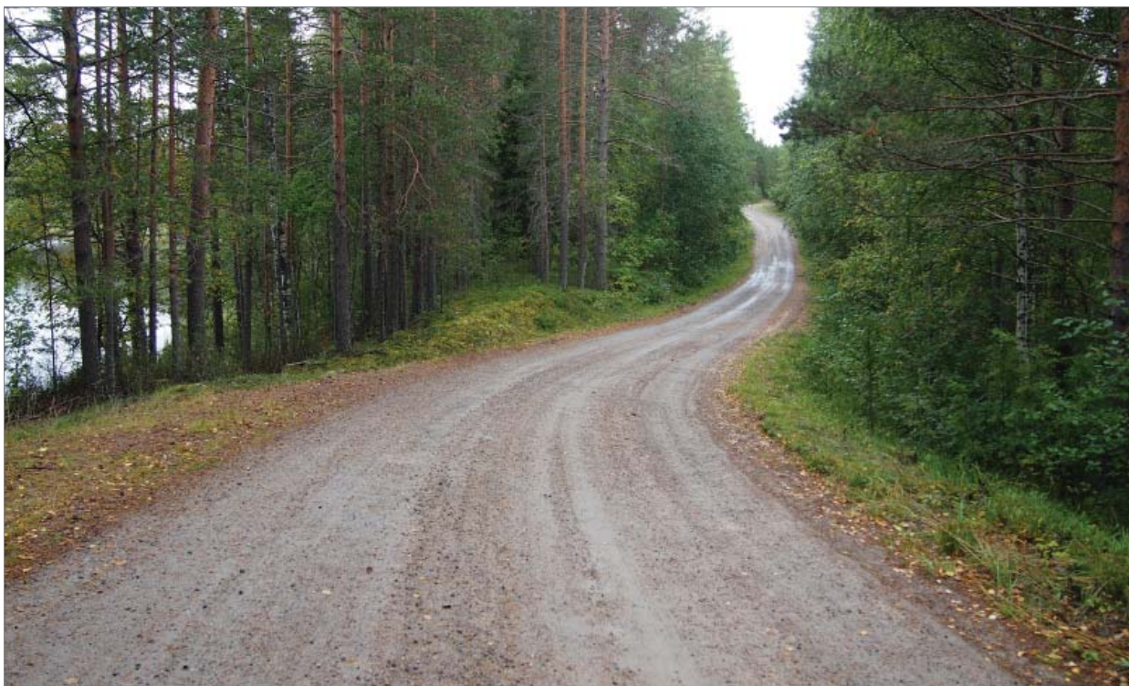
Vornan kapealla harjulla tien linjaus on säilynyt osittain varmasti sen vuoksi, ettei paremmille linjauksille ole tilaa harjun laella ilman suuria massansiirtoja. 1700-luvulta 1950-luvun alkuun liikenne on selvinnyt samalla linjauksella ja suunnilleen samalla tasauksella. Metsän reunan vesaikotuminen tiealueelle tukkii maisemat ja kaventaa tienäkemää. Kuva Martti Piiltz.
