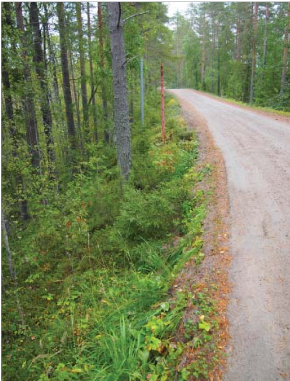
Esimerkki jyrkästä sisäluiskasta, joka voi vaarantaa liikenneturvallisuutta. Tavoite on, ettei museotielle asenneta tiekaiteita, vaan mieluummin luiskaa loivennetaan ja ajolinjoja muutetaan. Kuva Martti Piltz.
