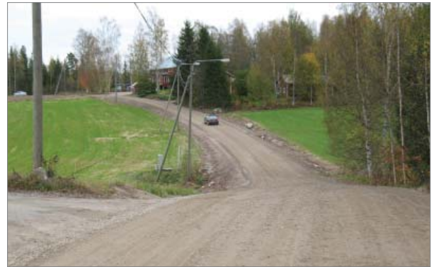
Lännestä kohti Seurataloa tien varret näkyvät siisteinä. Oikealla vastarinteessä on uusittu sivuohjarrumpu. Rummun vanhat sementtiputket ovat vielä tienpenkalla. Muovi katoaa näkyvistä heti, kun maan nurmettuu tulevana kesänä. Kuva Tapio Mård
