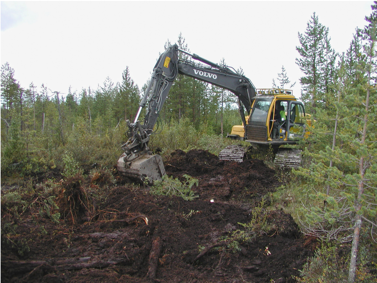
Kuva 17. Soiden ennallistamisessa ojat täytettiin koneellisesti. Täyttömaana käytettiin pääasiassa ojituksen yhteydessä syntyneitä kaivuumaita. Kuva Jouni Rauhala.
