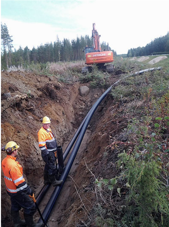
Kuva 6. Siirtoviemärin ja yhdysvesijohdon rakennustyömaa. Kuva Timo Karjalainen.
