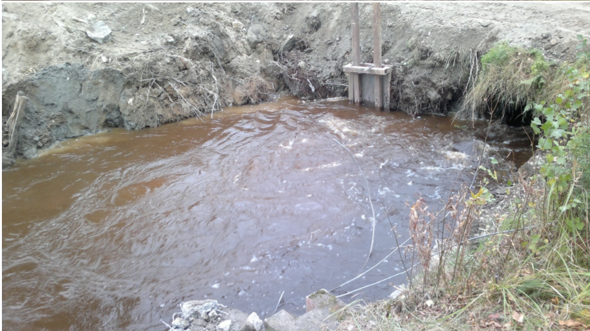
Kuva 5. Saarijärven säännöstelypato purettiin 19.9.2013 ja samalla Myllyjokea perättiin. Yläkuvassa on näkymä puretulle padolle ylävirtaan ja alakuvassa puretun padon paikka. Vesi virtasi Saarijärvestä vuolaana. Kuvaaja: Kari Saari.
