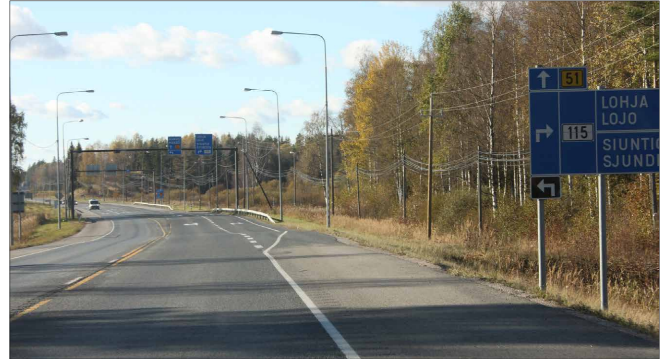
Kuva 31. Siuntiontien liittymän itäpuolella kantatien pohjoispuolelta edullisin siltapaikka erottuu selvästi tien nykyisestä tasauksesta: Muualla kuin etualalla tie on painunut huomattavasti enemmän, koska pehmeikkö on selvästi syvämpi.
