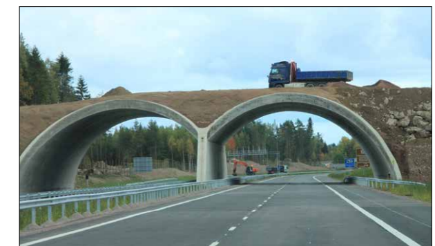
Kuva 26. Vihersilta E18-tiellä Loviisan lähellä. Vastaava on kantatiellä 51 Kirkkonummen itäpuolella.
