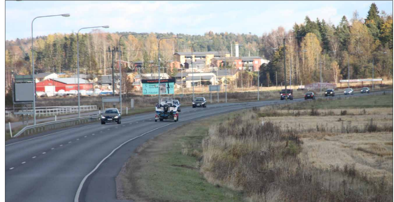
Kuva 19. Pedersin peltoaukealla kantatie on painunut jo lähes pellon tasoon ja painuminen jatkuu yhä.
