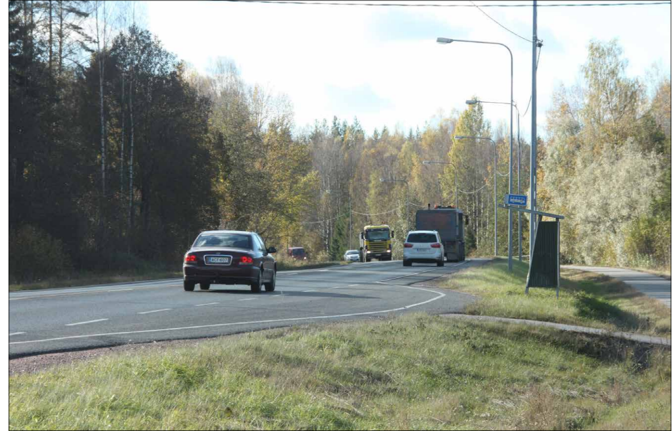
Kuva 37. Vuohimäenkin kohdalla kantatien ja liittyvien suuntien palvelutaso paranee merkittävästi tien nelikaistaistamisen ja eritasoratkaisujen avulla.
