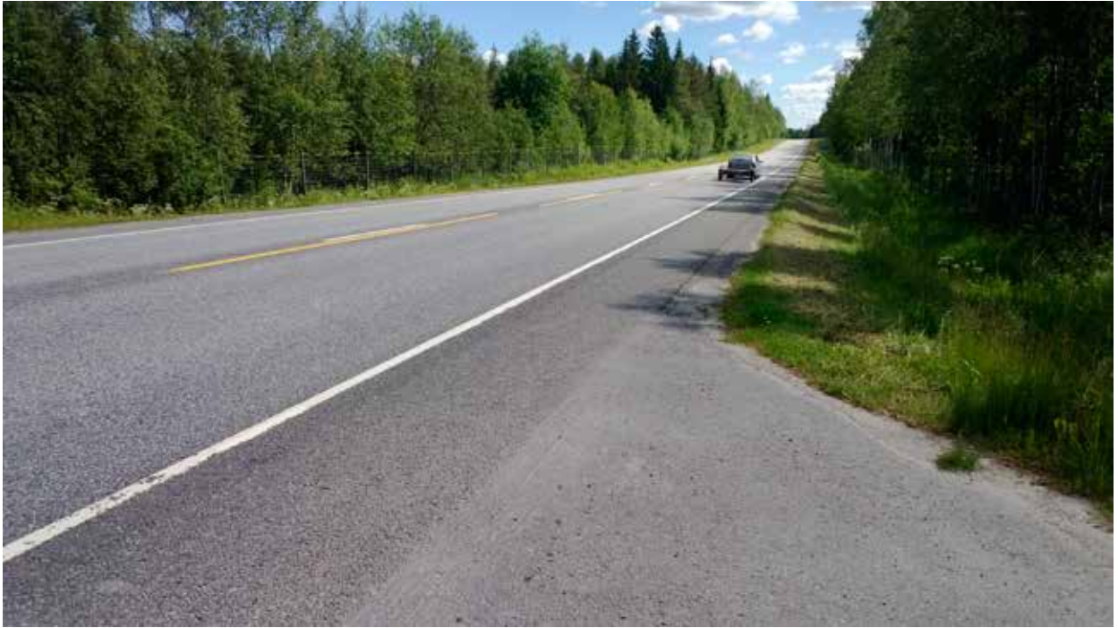
Bild 8. Den nya förbindelsens anslutningspunkt till befintlig riksväg 8 i Kuni.
