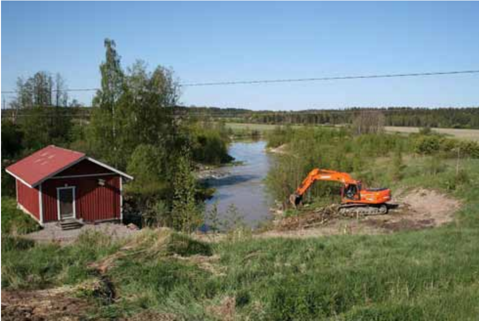
Kuva 2. Kuuskosken kalatien alaosan kaivutyöt ja työalueen pensaikon raivaus ovat meneillään 21.5.2008.
