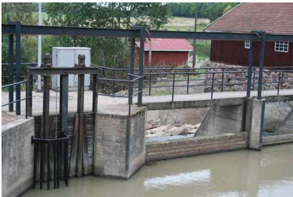
Kuva 15. Kuuskosken vesityspotken luukun säätötangon suojaamiseksi patorakenteisiin kiinnitettiin raudasta tehty kalterimainen rakenne.
