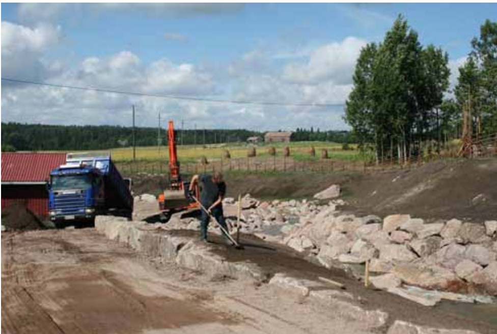
Kuva 12. Kalatien vasemmalle puolelle voimalaitoksen huoltotien reunaan tehtiin kivireunus. 12.8.2008 oli meneillään mullan levittäminen reunuksen ja kalatien väliselle kaistalle. Kalatiessä on koejuoksutus. Taustalla olevat rakennukset kuuluvat Kuuskosken molemmin puolin maat omistavalle Malmgårdin kartanolle.
