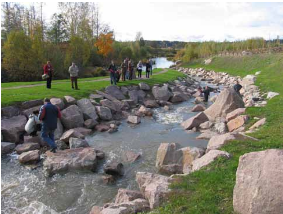
Kuva 18. Kuuskosken kalatien valmistumisesta järjestettiin 30.9.2008 tiedotustilaisuus, jonka jälkeen kalatiessä tehtiin sähkökalastus.
