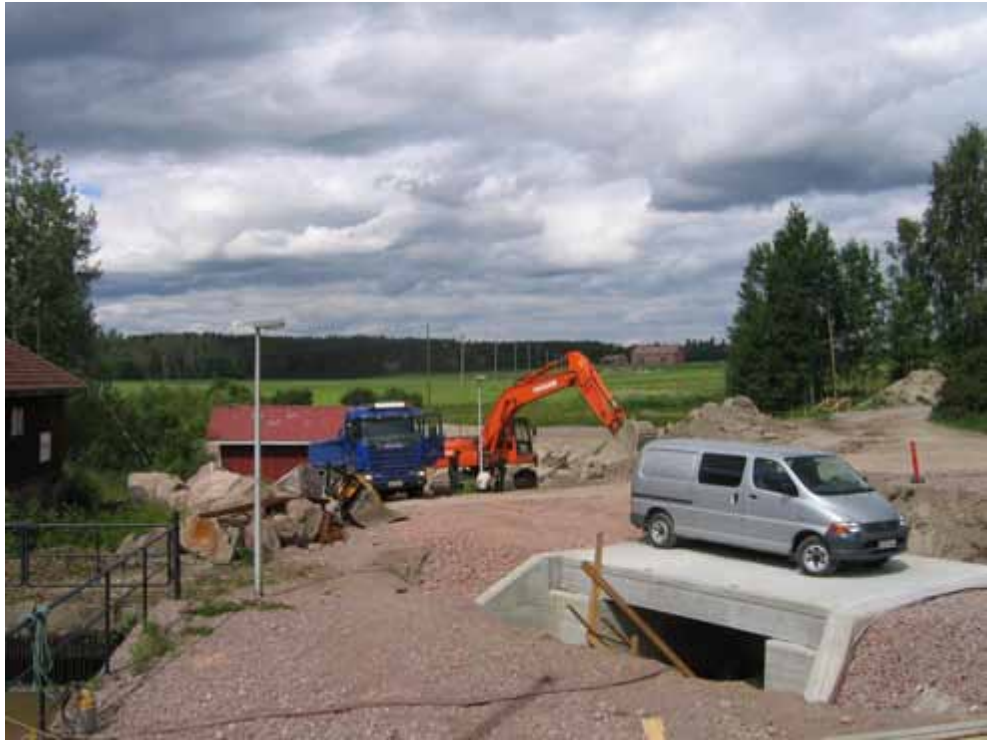
Kuva 6. Kuuskosken voimalaitoksen huoltoliikennettä varten rakennettu silta valutöiden jälkeen 8.7.2008. Sillan kaiteita ei ole vielä asennettu.
