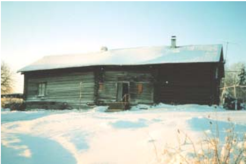
Hassilan vanha päärakennus on harvoja säilyneitä esimerkkejä koko maakunnassa kaskikauden rakentamistavasta. Erityisesti tupaosa (vasemmalla) on arvokas monien mielenkiintoisten rakennusratkaisujen ansiosta.
