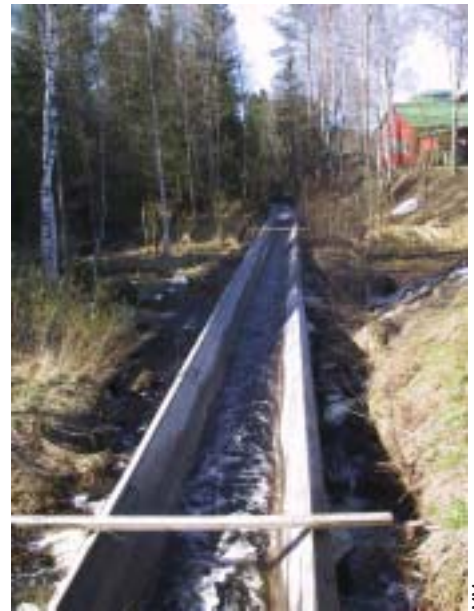
Ympäristökeskuksen johdolla rakennettiin uudestaan Sarvinginjoen uiton kouru.
