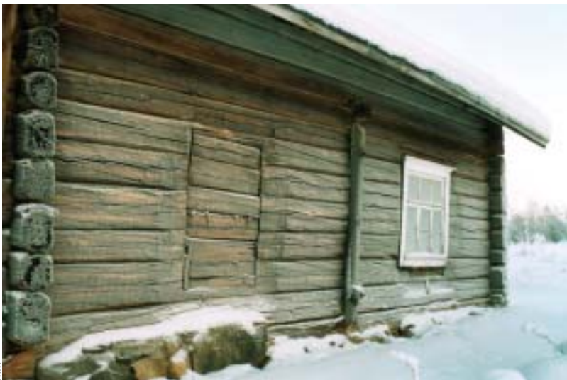
Pirttivaaran Riihiahon päärakennuksen tupaosan hirret ovat hyvinvalituista ja ajan nakerrusta kestävästä honkapuista.
