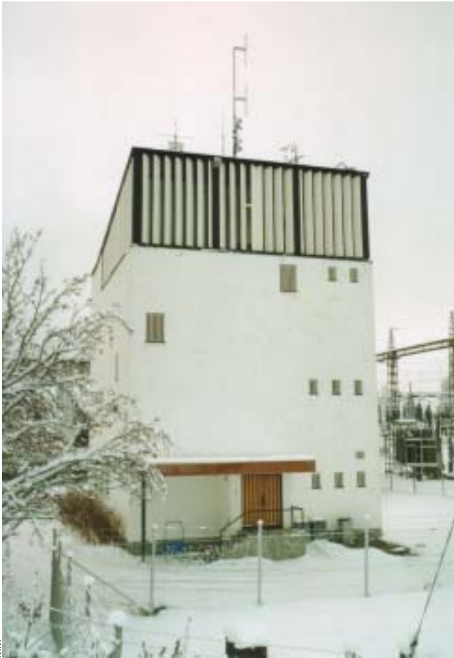
Pamilon voimalaitoksen valvomon on suunnitellut maailman-kuulu arkkitehti Alvar Aalto.
