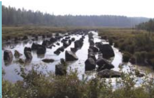
Kirkkonkylän itäpuolelle Harpatinlahdelle rakennettiin välirauhan aikaan 1940 voimakas puolustusasema. Matalaan veteen sijoitettiin kiviset panssariesteet.
