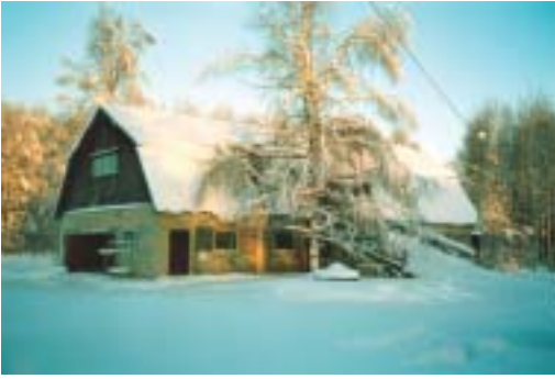
Kuusjärven Turulan hyväkuntoinen, vuonna 1930-luvulla valmistunut navetta poikkeaa tyyllillisesti ja rakennusmateriaaleiltaan perinteisestä navettarakennuksesta.
