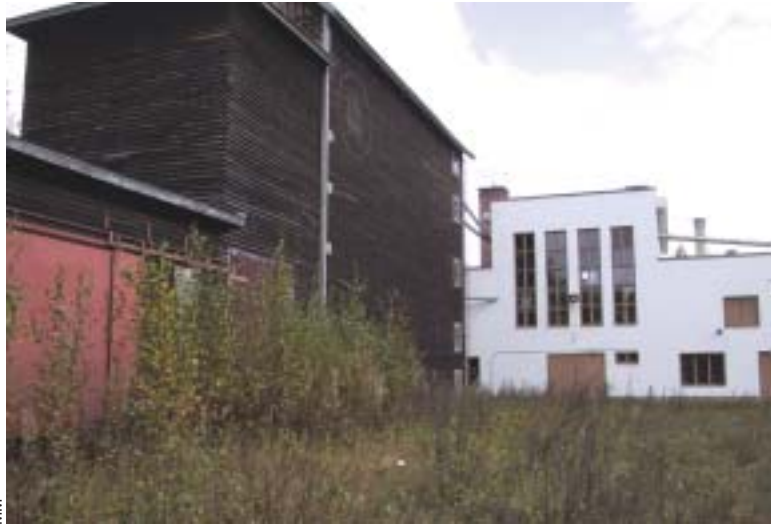
Metsähallituksen käpykaristamon rakennuksia Rahkeella. Vasemmalla korkea käpysiilo, jonka seinät on tehty päällekkäin ladotuista kakkosnelosista. Rahkee Oy:n entisen rakennuksen tiilliseinät Metsähallitus rappasi 1950-luvulla valkoisiksi.
