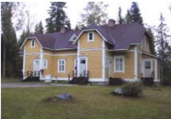
Kaltimon pahvitehtaan ympärille valmistui 1900-luvun alkupuolella arvokas puutaloalue. Kuvassa toinen Riihikasarmien nimellä kulkevista entisistä työsuhteasuntoloista.
