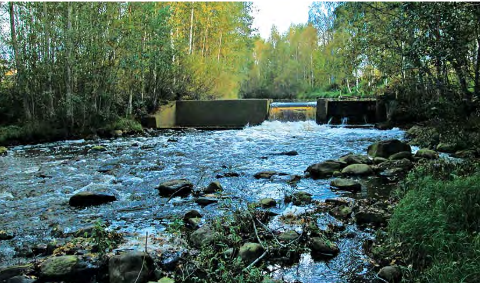
Figur 16: Kvarndammen i Peltokoski (nr 3) hindrar fisk från att vandra uppströms.
