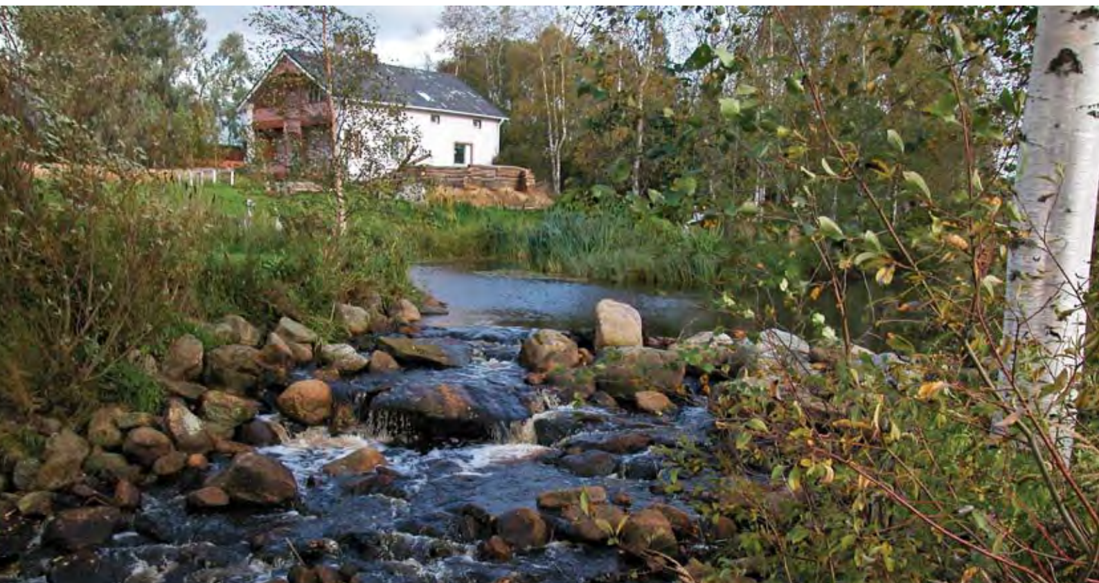
Figur 35: Den steniga bottendammen vid fors nr 10 i Horonkylä hindrar inte fiskens vandring uppströms ens vid lågvattenflöde.
