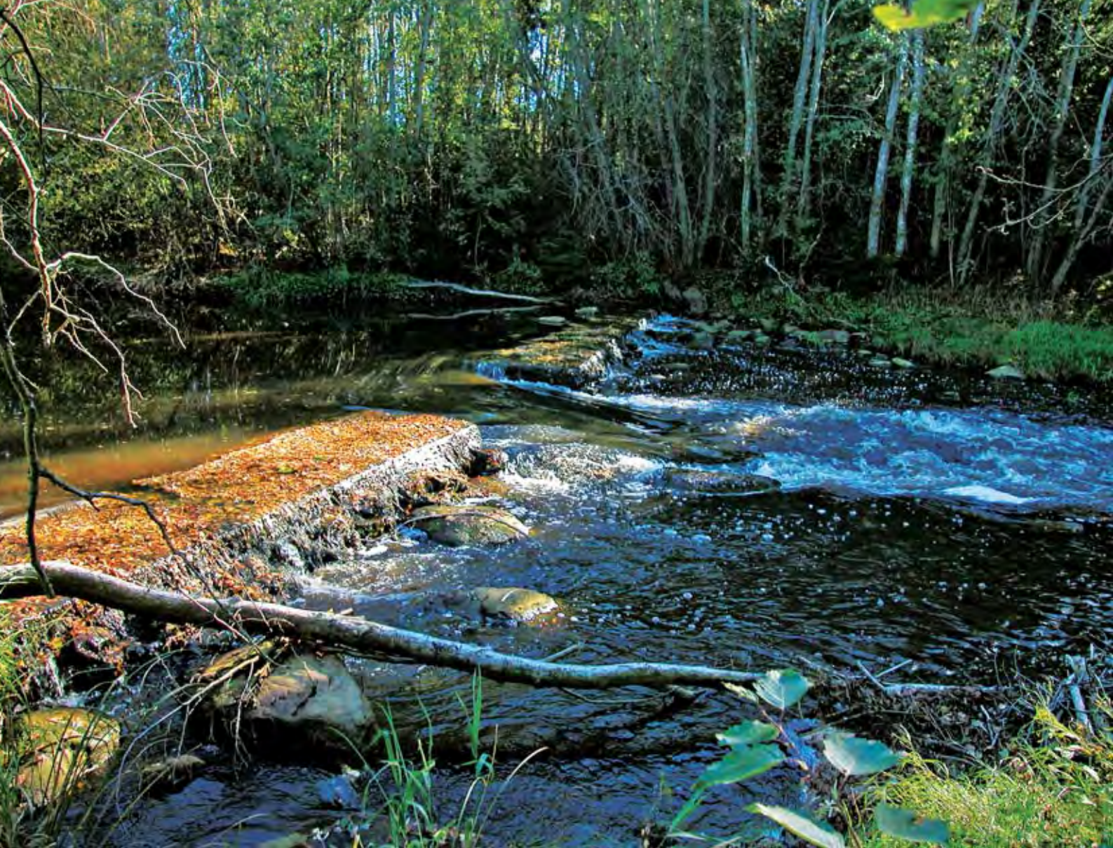
Figur 18: Dammen vid Gammelstuforsen (nr 24) försvårar fiskens vandring under lågvattenflöden.
