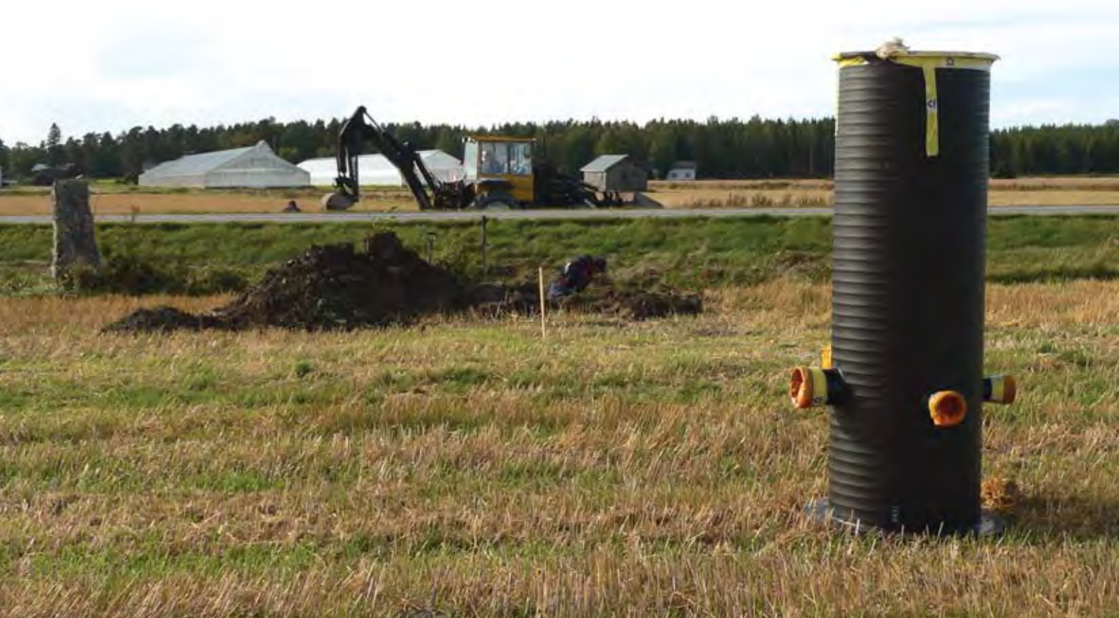
Figur 43: Med hjälp av reglerad dränering kan både närings- och försurningsbelastningen minskas. Foto: Anna Bonde
