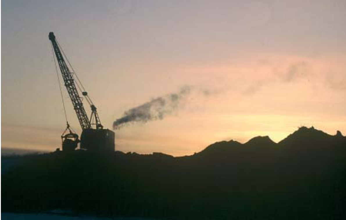
Lähes kaikki Kyrönjoen työt oli vuoteen 1980 asti aloitettu työluvalla turvin. Tiekasin pengerrys aloitettiin 1982 vielä vanhalla työluvalla, vaikka käytäntöä oltiin juuri kiristämässä.
