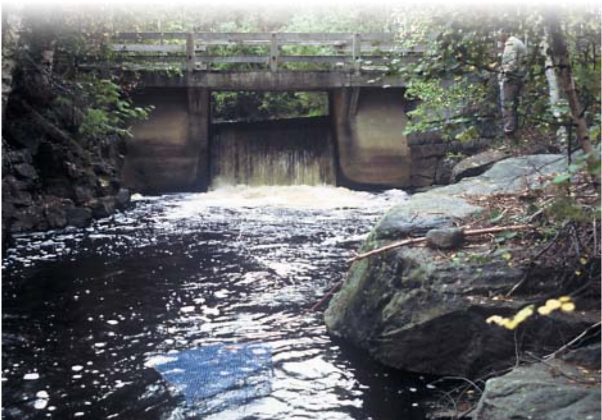
Vuonna 1957 valmistunut Seinäjärven pato uusittiin seuraavan kerran vasta 1990-luvulla.
