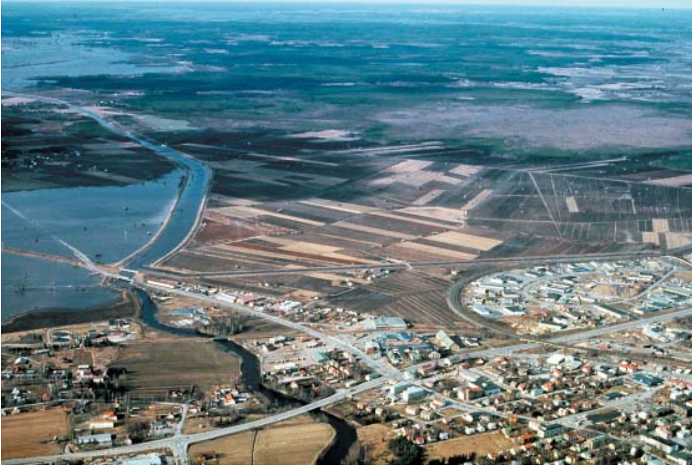
Seinäjoen oikaisu-uoman oikealle puolelle jäävä Pajuluoman pengerrysalue pysyi kevään 1984 suurtuvan aikana kuivana. Kuva on otettu 24. huhtikuuta 1984.
