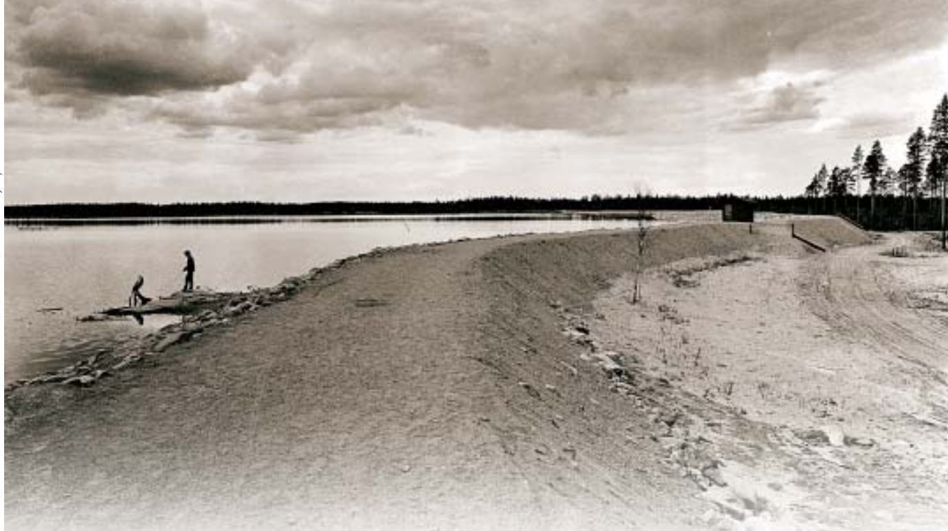
Liikapuron tekoallas valmistui 1968. Kyrönjoen ensimmäinen tulvasuojelua varten rakennettu tekojärvi on Seinäjoen latvavesillä, mutta Jalasjärven kunnan puolella.
