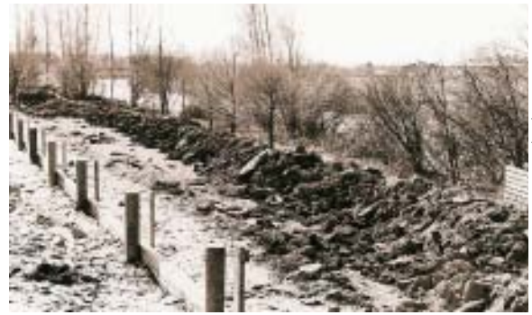
Jalasjärven rivitalot suojattiin vuonna 1985 penkereellä ja aitakehikolla, johon kasataan setit tulvan noustessa.
