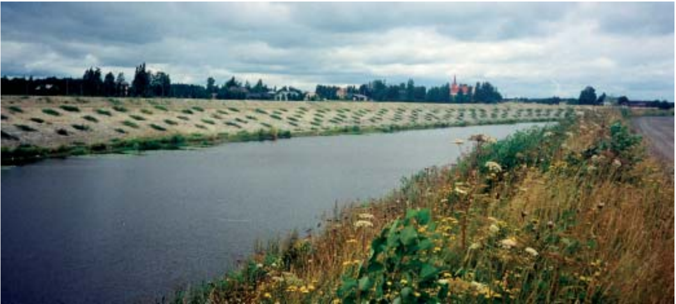
Kaivinkoneiden nostamat laikut kasvattivat penkereen parissa vuodessa täyteen alkuperäistä kasvillisuutta. Kuva on otettu heinäkuussa 1999 Kitinojan kirkon kohdalla.
