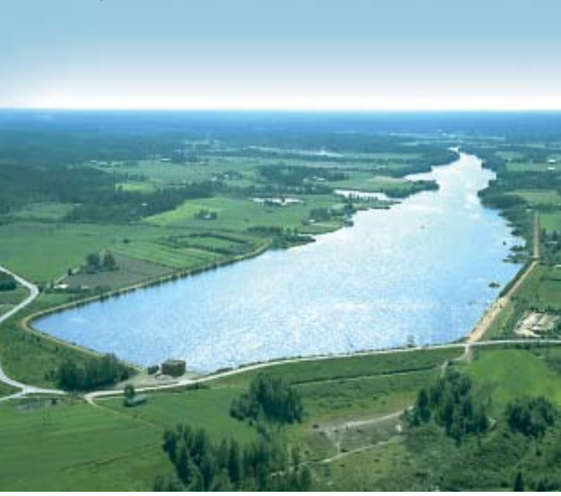
Pitkämön tekojärvi rakennettiin syvään kanjoniin. Sen 34 metriä korkea maapato oli valmistuessaan Suomen korkein, tosin myös yksi lyhyimmistä.
