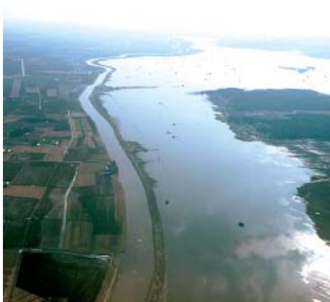
Vuoden 1985 kevättulva oli ensimmäinen, jossa Rintalan pengerryksessä näytettiin voimansa. Tiekin puolen pellot saatiin suojattua vasta 1990-luvun puolivälissä.
