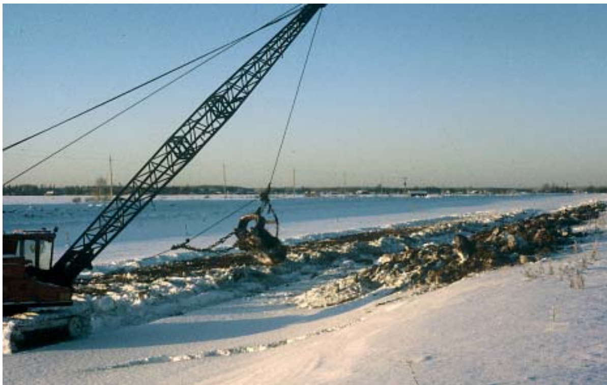
TVH aloitti Kyrönjoen työt Seinäjoen suuosan oikaisulla 1968-70. Viisi vuotta seisoneet työt saatiin päätökseen vasta 1983. Kuva on otettu vuoden 1981 viimeisenä päivänä.
