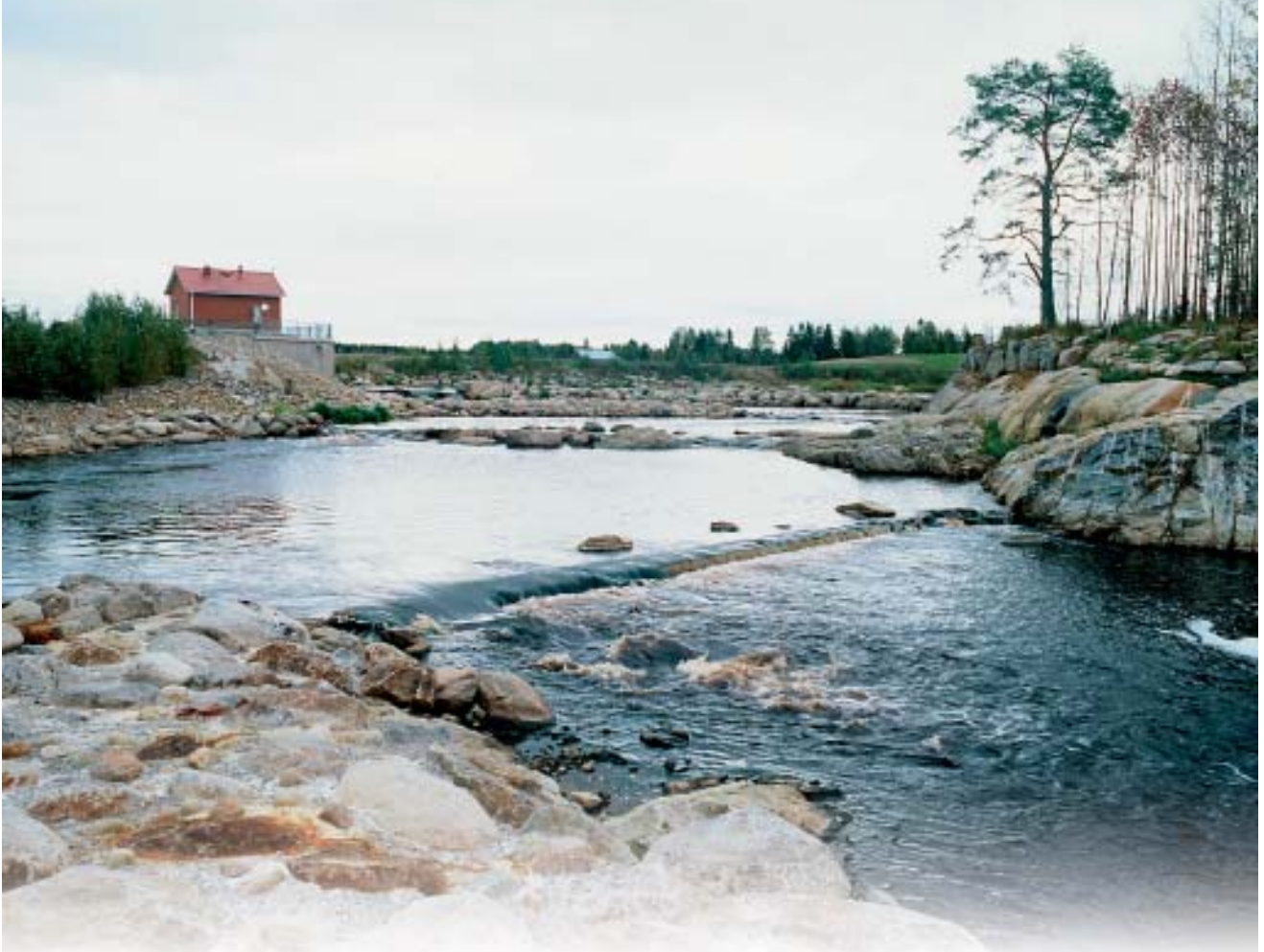
Malkakosken säätöpato ja koskipato töiden valmistuttua syksyllä 2003. Pinnan alle kätkeytyvät kalakourut sekä käsin asetellut luonnonkivet, vesikasvit ja uppotukit.
