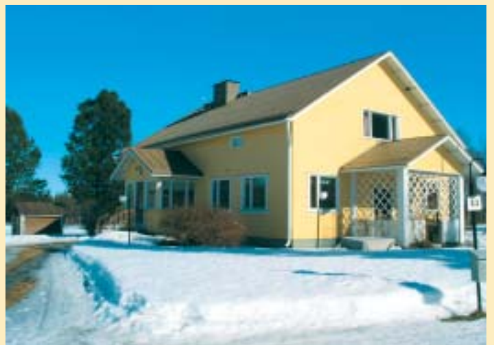
Majalan päärakennus. Kuva: Kainuun ympäristökeskus 2003.
