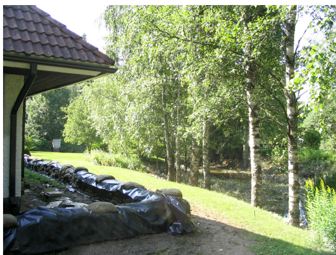
Kuva 1. Muovilla tiivistetty suojavalli hiekkasäkkeistä. Kuva: Ville Suhonen.
