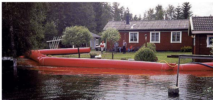
Kuva 17. NOAQ Tubewall -tulvamuuri. (Lähde NOAQ)
