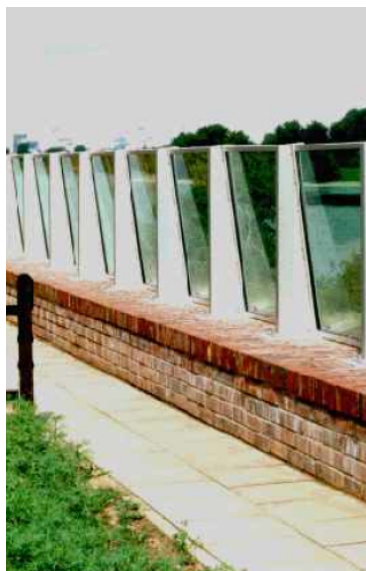
Kuva 22 Valmiiden perustusten varaan pystytettävä lasiseinä. (Lähde: AQUA-STOP)
