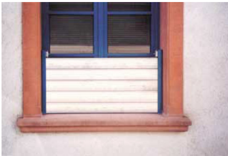
Kuva 19. Ikkuna-aukon suojaus alumiinisilla seteillä. (Lähde: WP Wasto)
