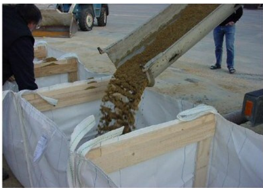
Kuva 3. Big Bag -tulvamuuri. (Lähde: Seidel GmbH)
