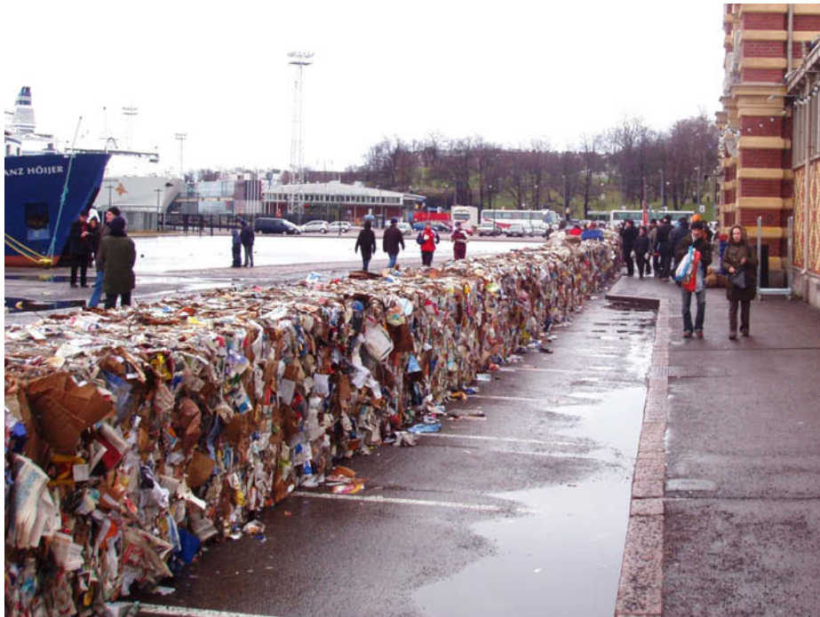
Kuva 34. Tulvamuuri kierrätyspahvipaaleista. Kuva: Helsingin kaupungin pelastuslaitos.
