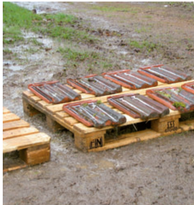
Peuran museon toimistosiiven kattotiilet poistettiin ehjinä liukurataa hyväksikäyttäen lape kerrallaan. Tiilet pestiin painepesurilla.
