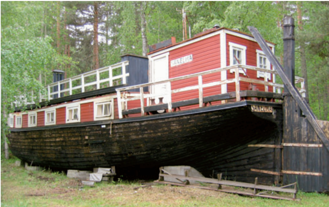
Puusto on saanut väistyä Sanelma-proomun läheisyydestä. Ikkunat ja puuosat on kunnostettu.
