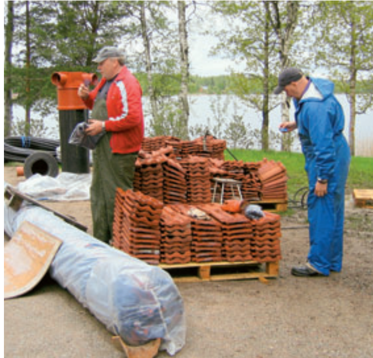
Peuran museon toimistosiiven kattotiilet poistettiin ehjinä liukurataa hyväksikäyttäen lape kerrallaan. Tiilet pestiin painepesurilla.
