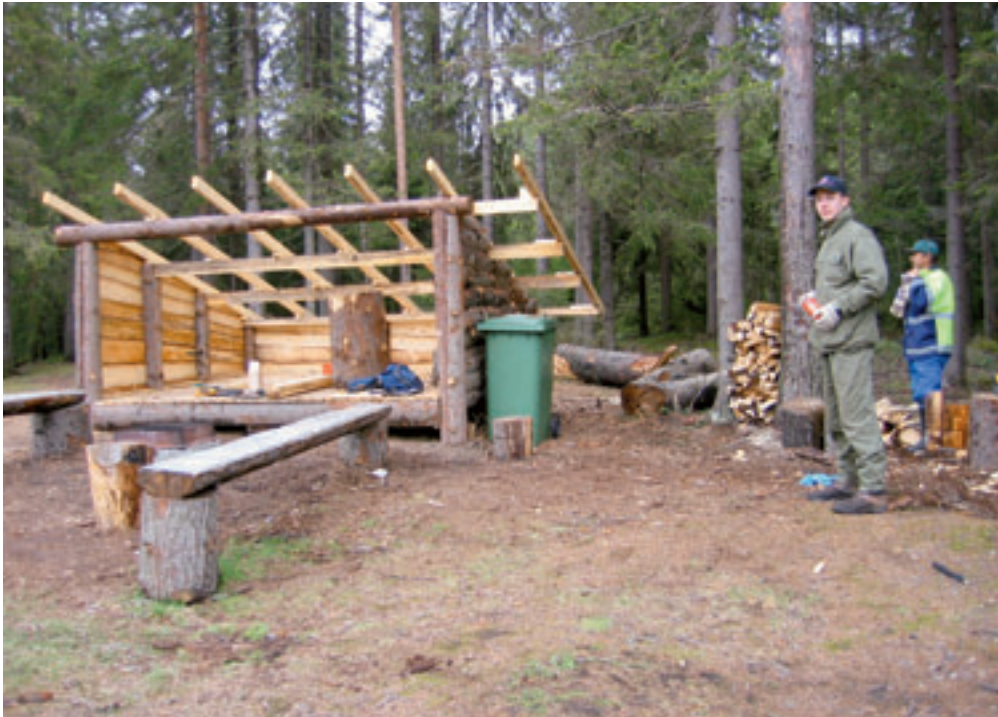
Laavun runko on valmistunut.
