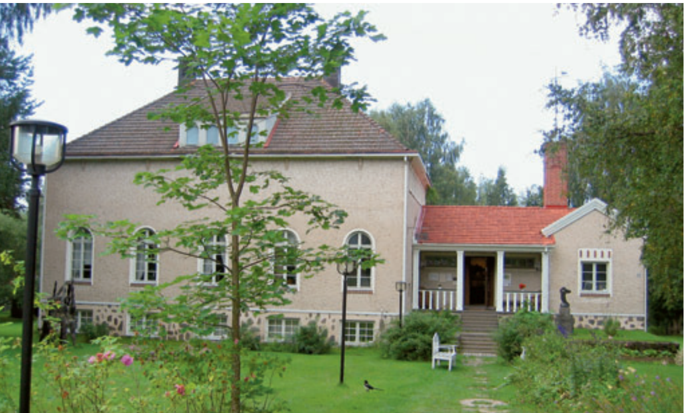
Puhdistuksen jälkeen tiilet palautettiin museon katolle. Puhdistetut tiilet paikalleen laitettuina. Valokuva Esko Karvinen.
