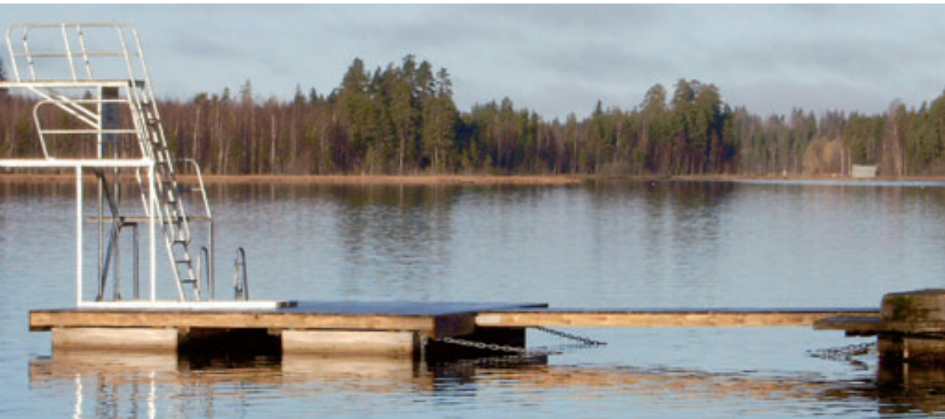
Sorsakoskelle rakennettiin uimalaituri, joka asennettiin paikoilleen kallioon riimujen avulla. Laiturin päälle asennettiin kolmetasoinen hyppytorni ja nousutikkaat. Valokuva Jari Komulainen.
