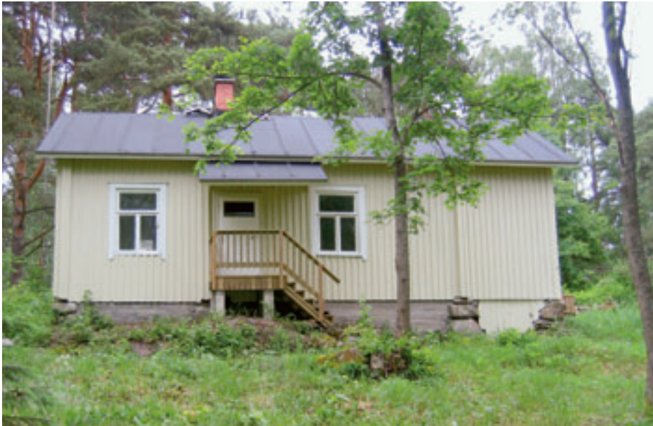
Kalliolan päärakennus kunnostettuna.
