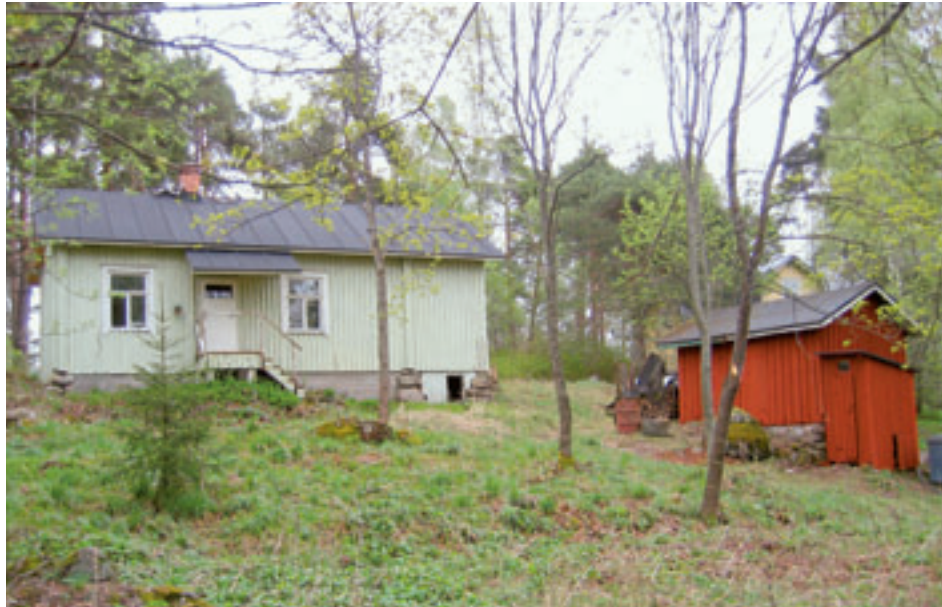
Lehtoniemessä sijaitsevan Kalliolan pihapiirin rakennuksia kunnostettiin. Ulko-ovi purettiin ja lahonneet osat vaihdettiin uusiin. Ulkoportaatta uusittiin. Ulkoseinät raapattiin ja maalattiin.
