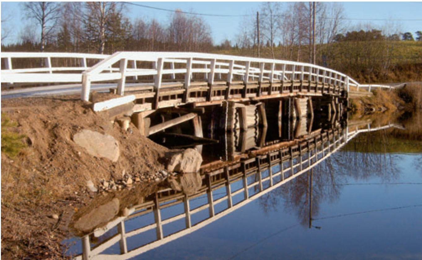
Liisalan silta kunnostettuna. Valokuva Jari Komulainen.
