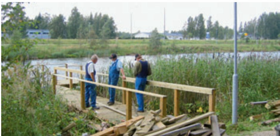
Laiturin rakentaminen on loppusuoralla.
