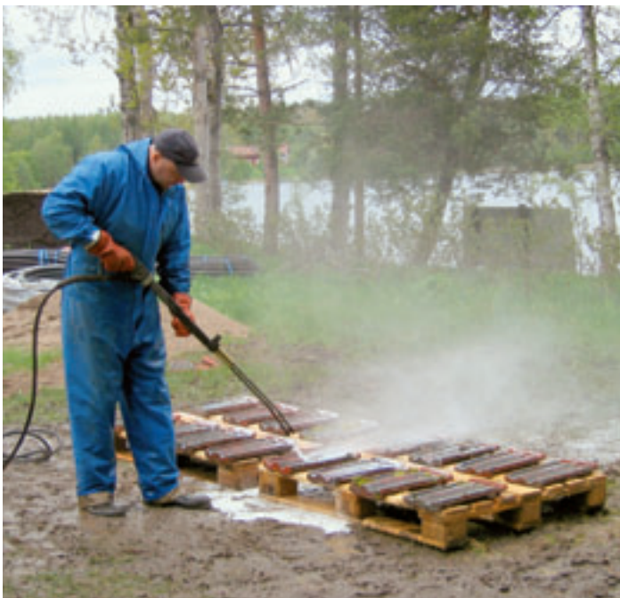
Peuran museon toimistosiiven kattotiilet poistettiin ehjinä liukurataa hyväksikäyttäen lape kerrallaan. Tiilet pestiin painepesurilla.
