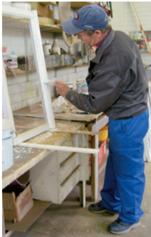
Päärakennuksen ikkunat kunnostettiin poistamalla laho-osat. Rikkoutuneet ikkunat ja kittaukset uusittiin. Kunnostuksessa käytetty kitti valmistettiin itse. Martti Kinnunen kittaa ikkunaa ja Markku Heljanti viimeistelee maalausta.
