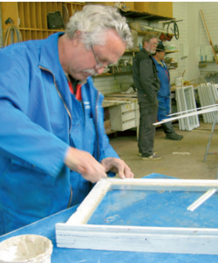
Päärakennuksen ikkunat kunnostettiin poistamalla laho-osat. Rikkoutuneet ikkunat ja kittaukset uusittiin. Kunnostuksessa käytetty kitti valmistettiin itse. Martti Kinnunen kittaa ikkunaa ja Markku Heljanti viimeistelee maalausta.
