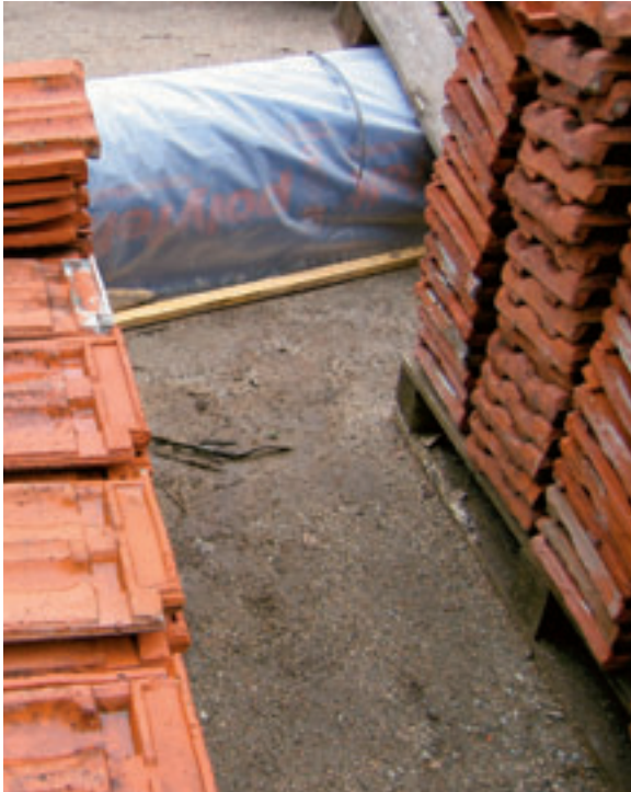
Peuran museon toimistosiiven kattotiilet poistettiin ehjinä liukurataa hyväksikäyttäen lape kerrallaan. Tiilet pestiin painepesurilla.
