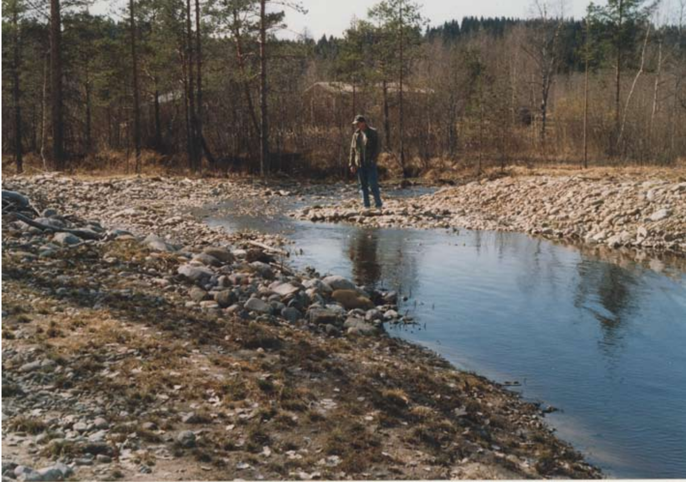
Kuva 5. Ukonpuron kosteikon pohjapato noin vuoden kuluttua rakentamisesta.
