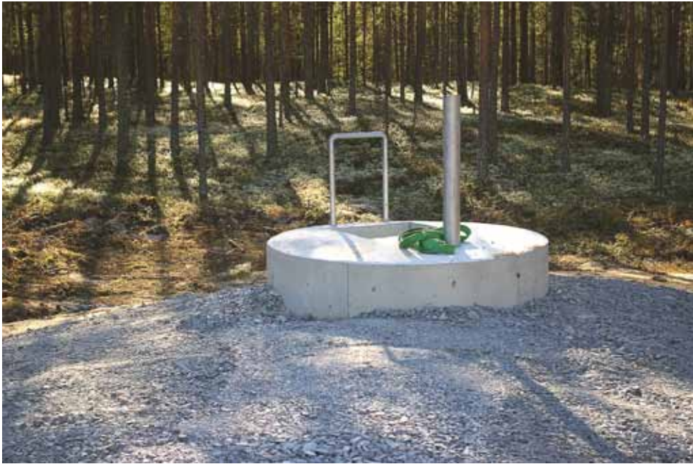
Kuva 8. Valmistumassa olevan vedenottamon kaivo Uusi-Somerossa, Kokkolan Kälviällä.
