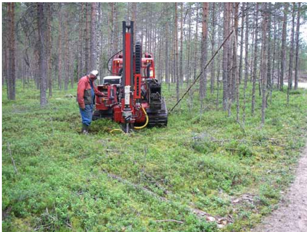
Kuva 9. Maaperäkairausta Kokkolan Lohtajalla
