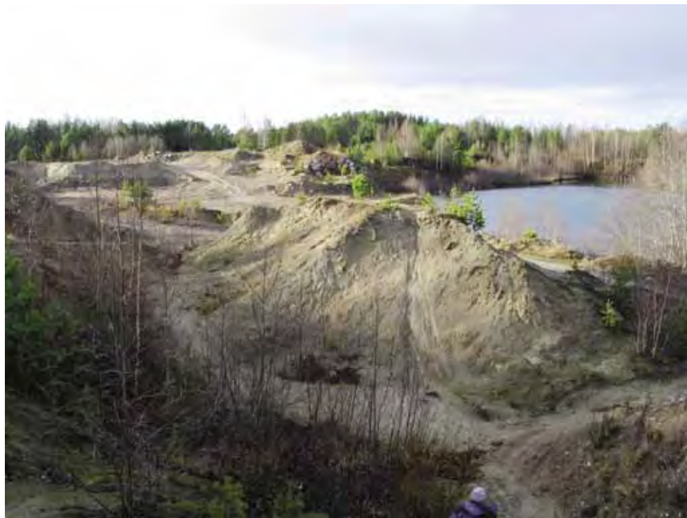
Kuva 186. Åsen B:n pohjavesialueen soranottoalueelle I on muodostunut soranoton seurauksena useita lampia. Alue on jälkihoitamaton ja alueella on runsaasti hienoainesmaakasoja. Alueen kunnostustarve on suuri.
