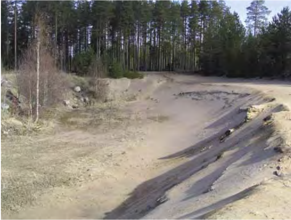
Kuva 95. Sarvikankaan pohjavesialueen soranottoalue 4 on muotoiltu. Alueelle ei ole levitetty pintamateriaalia.
