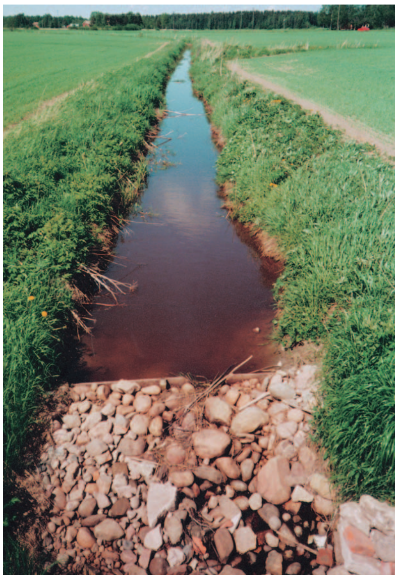
Kuva 14. Pohjapato on perusrakenteeltaan yksinkertainen. Kuva: Heli Nukki
