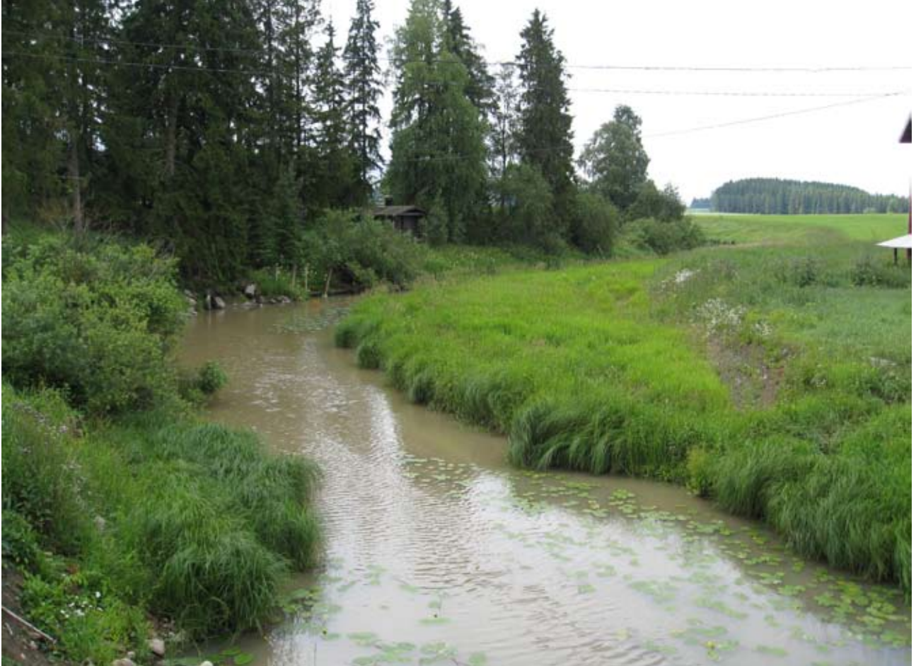
Kuva 13. Villikkalanjärven joet -projektissa Lanskinjoelle vuonna 2006 rakennettu tulvatasanne on jo kasvillisuuden peittämä. Kuva: Hanna Eskola.
