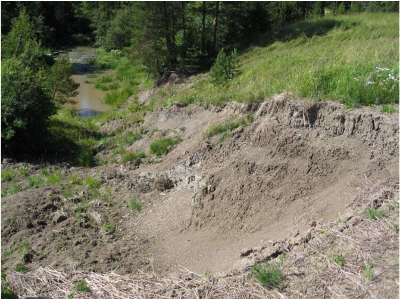
Kuva 5. Äärimmillään eroosio aiheuttaa laajoja sortumia. Kuva Lanskinjoen uoman reunalta Ala-Myllykosken alapuolelta. Kuvat: Hanna Eskola.
