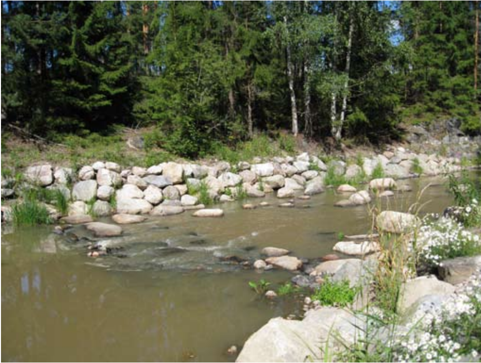
Kuva 4. Villikkalanjärven joet -projektissa rakennettiin Ylä-Myllykosken pohjapato Lanskinjokeen vuonna 2006.
