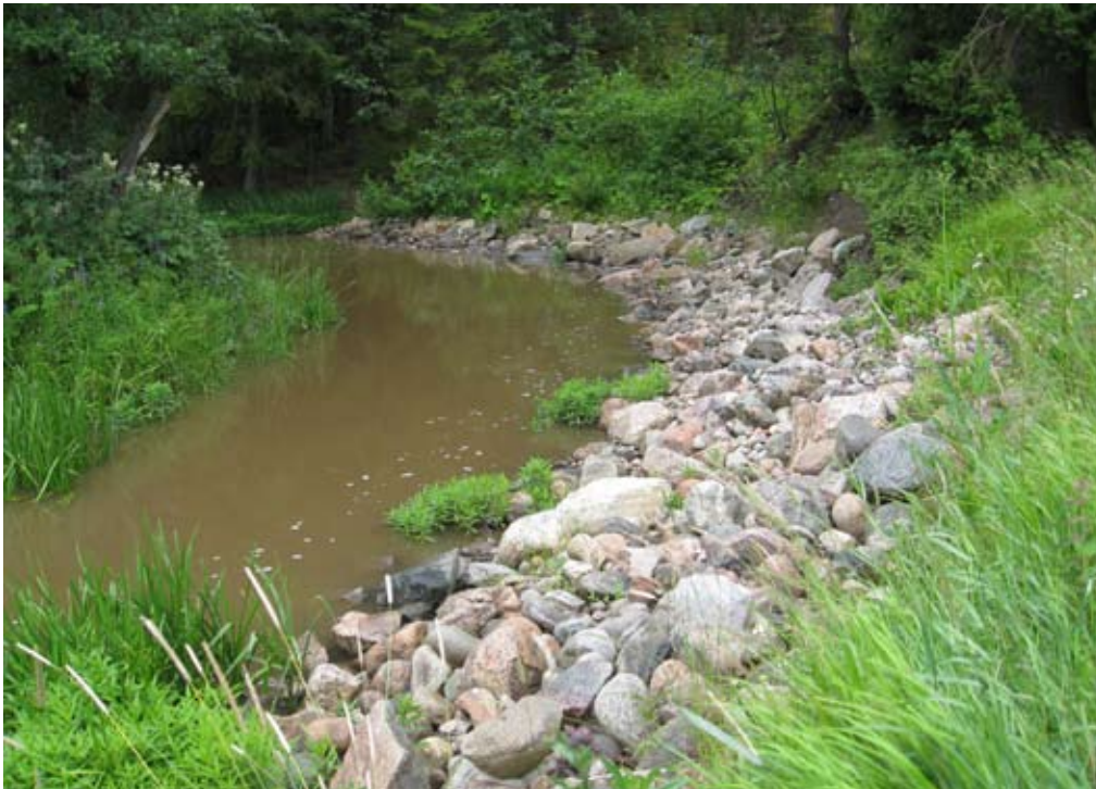
Kuva 11. Luonnonmukaisen rakennustavan mukaan tehty eroosikorjaus Köylinjoelta. Kuva: Hanna Eskola.
