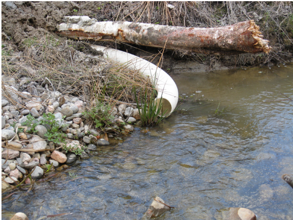
Kuva 8. Salaojien purkuputkien korkeudet tulee ottaa huomioon kosteikkoa suunniteltaessa, ettei lähipeiton kuivatukselle aiheudu haittaa. Kuva: Hanna Eskola
