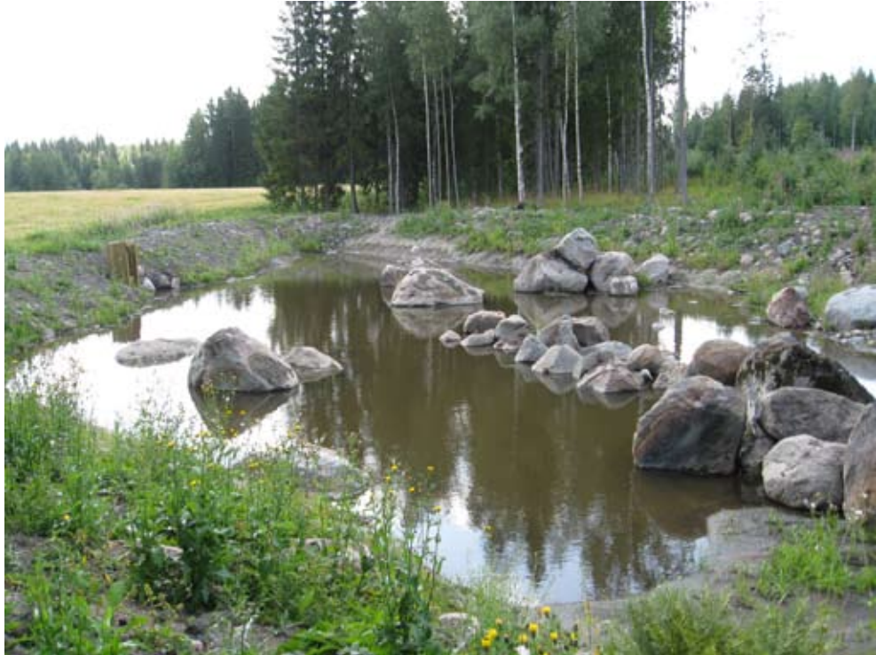
Kuva 27. Metsäkeskuksen ja Mustojan alajuoksun suojeluyhdistyksen yhteistyönä toteuttama laskeutusallas (kohde 140). Kuva: Hanna Eskola
