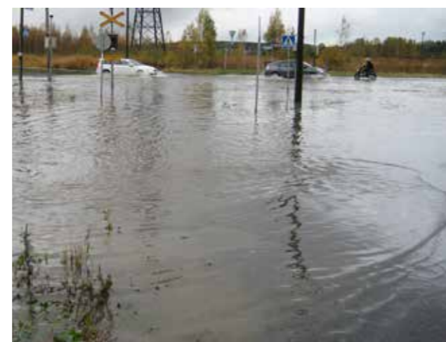
Kuva 67. Tulvatilanne E18-kehätiellä. Merivesi on noussut ajoradalle (kuva Varsinais-Suomen ELY-keskus/Veijo Niittyinen)
