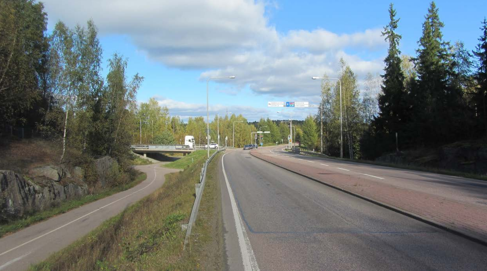
Kuva 60. Näkymä Merituulentieltä Kotkansaaren suuntaan Mussalontien nykyiseen liittymään. Vasemmalla toinen purettavista Etukylän alikulkukäytävistä.
