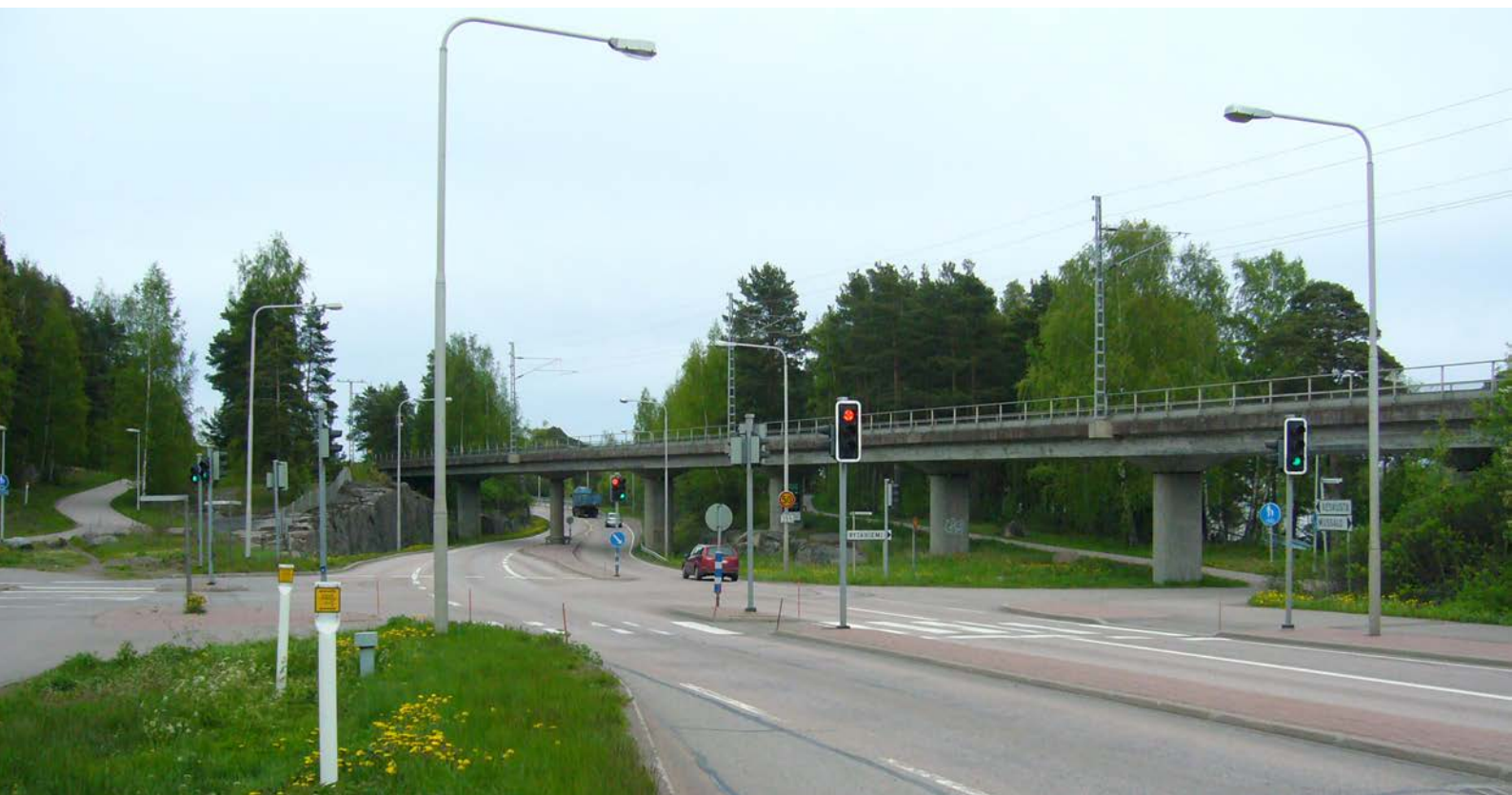
Kuva 13. Mussalon rata kulkee nykyisen Merituulentien yli Hirssaressa.
