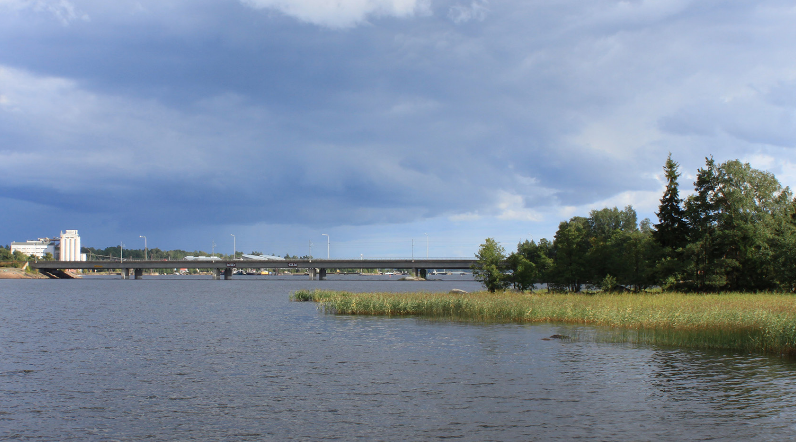
Kuva 61. Nykyiset Norssalmen sillat (maantie- ja ratasilta) pohjoisesta katsottuna.
