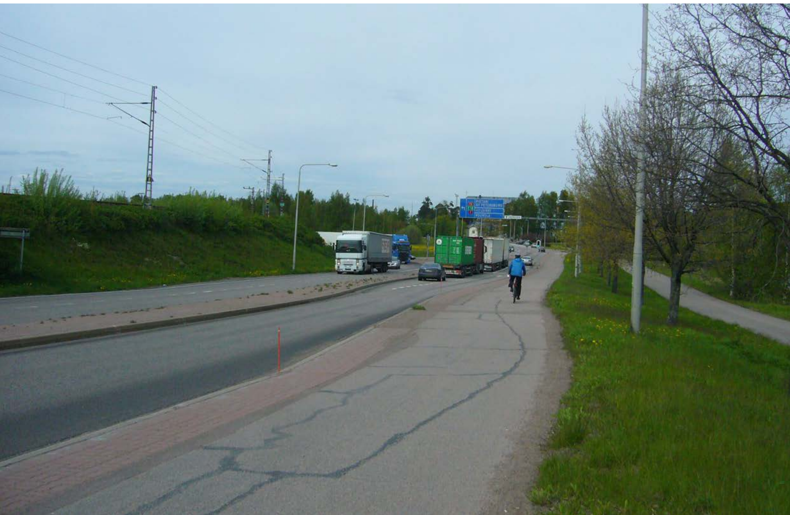
Kuva 4. Haukkavuoren liittymässä liittymiskaista Merituulentielle liityttäessä on lyhyt ja ylämäessä
