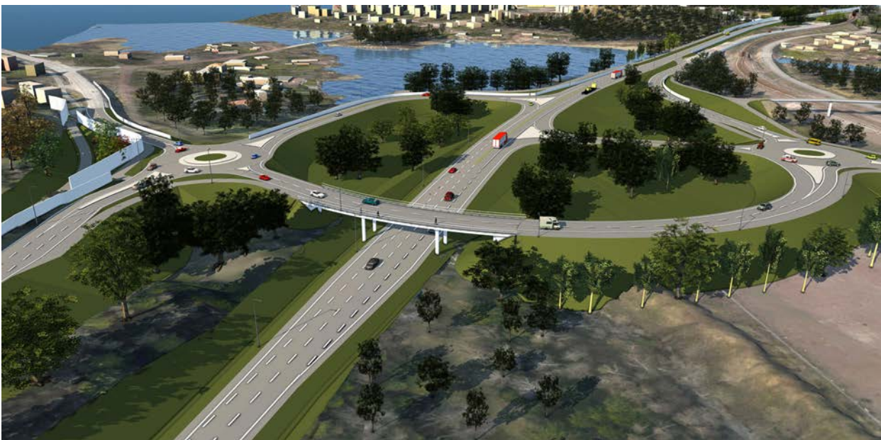
Kuva 1. Mussalon uusi eritasoliittymä
