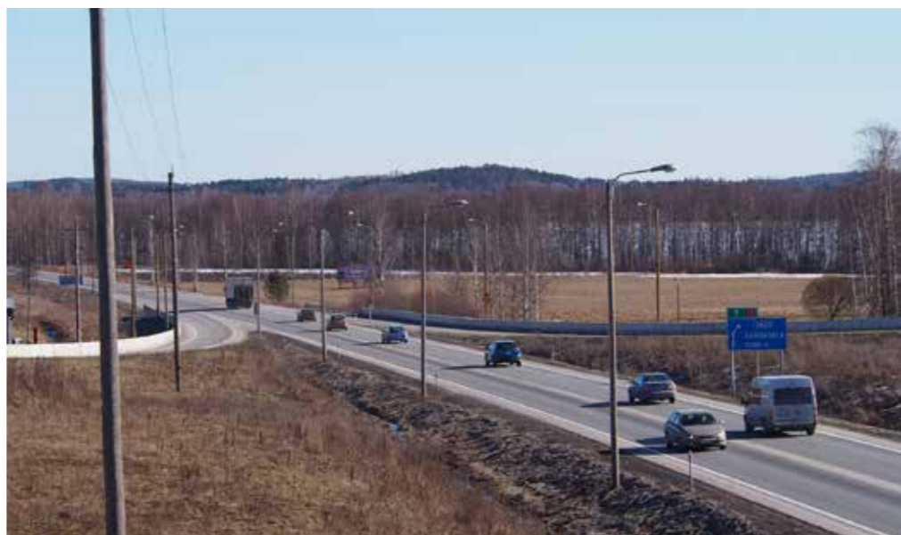
Kuva 56. Ranta-Koiviston eritasoliittymä. Taustalla näkyy Kirkkojärven Natura-alueita. (kuva: Kimmo Heikkilä, Ramboll)
