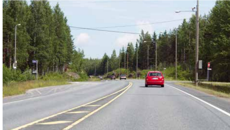
Kuva 57. Kanavoimattomat yksityistieliittymät Suinulan kohdalla ovat sekä liikenneturvallisuusriski että sujuvuusongelma. Kuvissa Havialantien liittymä.
