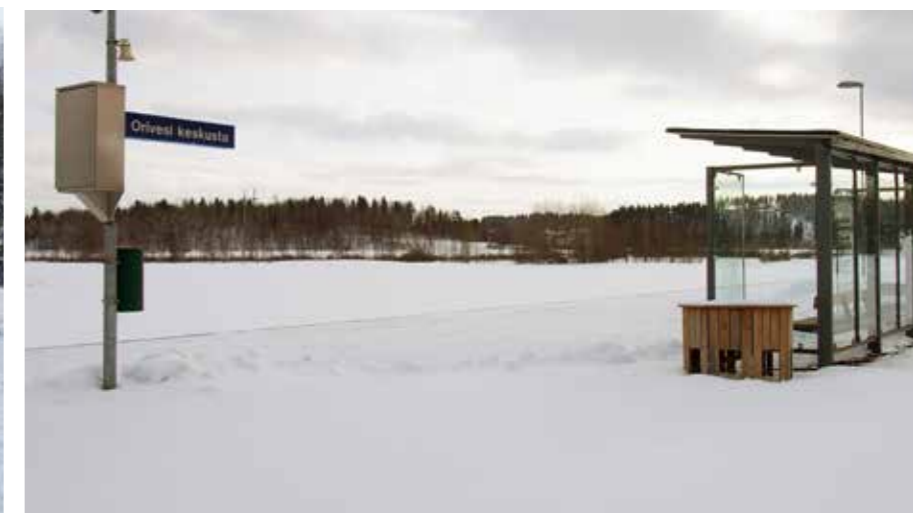
Kuva 59. Taajamajunien tarjontaa toivotaan lisäävän sekä pysähdysasemien että vuorojen osalta.
