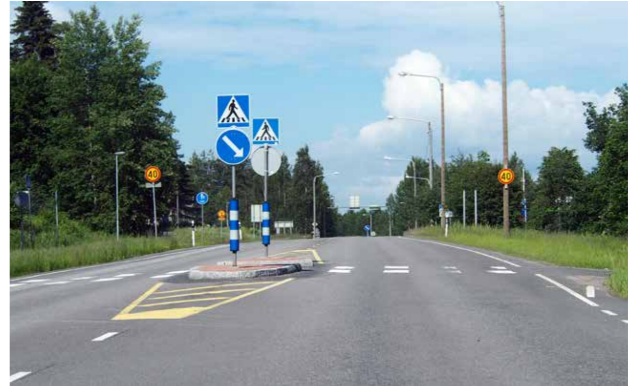
Kuva 17. Orivedellä kantatie 58 muodostaa pääväylän, joka yhdistää Oriveden keskustaajaman osat toisiinsa.
