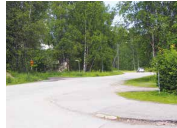
Kuva 107. Asematietä (yt 3261) Oriveden aseman kohdalla, tien vasemmalla puolella Laitamontien liittymä
