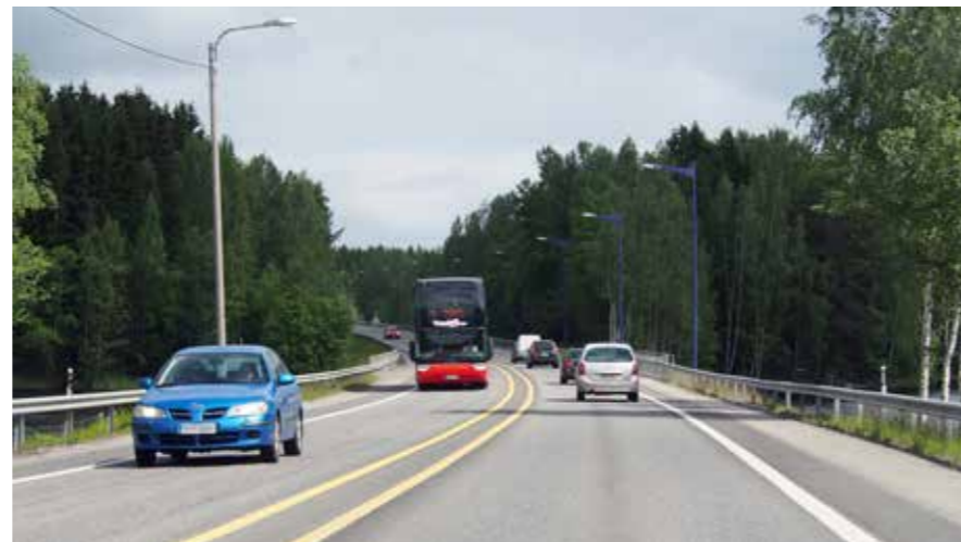
Kuva 113. Leveä keskimerkintä -kokeilu toteutettiin Alasjärven ja Aitovuoren välillä vuonna 2011.
