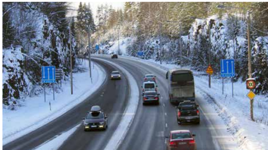
Kuva 112. Oriveden eritasoliittymästä alkavaa ohituskaistaa esitetään varustettavaksi keskikaiteella.
