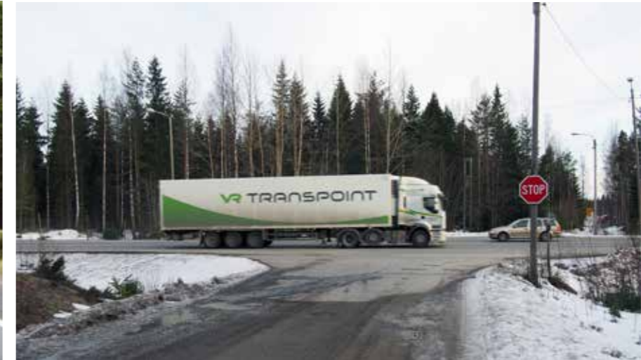
Kuva 57. Kanavoimattomat yksityistieliittymät Suinulan kohdalla ovat sekä liikenneturvallisuusriski että sujuvuusongelma. Kuvissa Havialantien liittymä.
