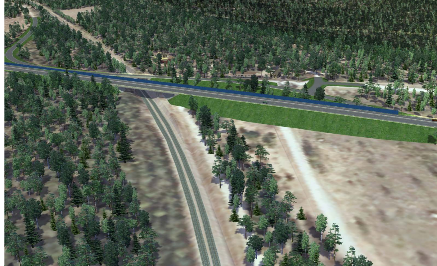
Kuva 4.10. Sitikkalaan rakennetaan uusi ylikulkusilta radan yli, joka toimii myös ekologisena yhteytenä. Nykyinen valtatie 12 jää rinnakkais- tien käyttöön. Havainnekuva etelän suunnasta.
