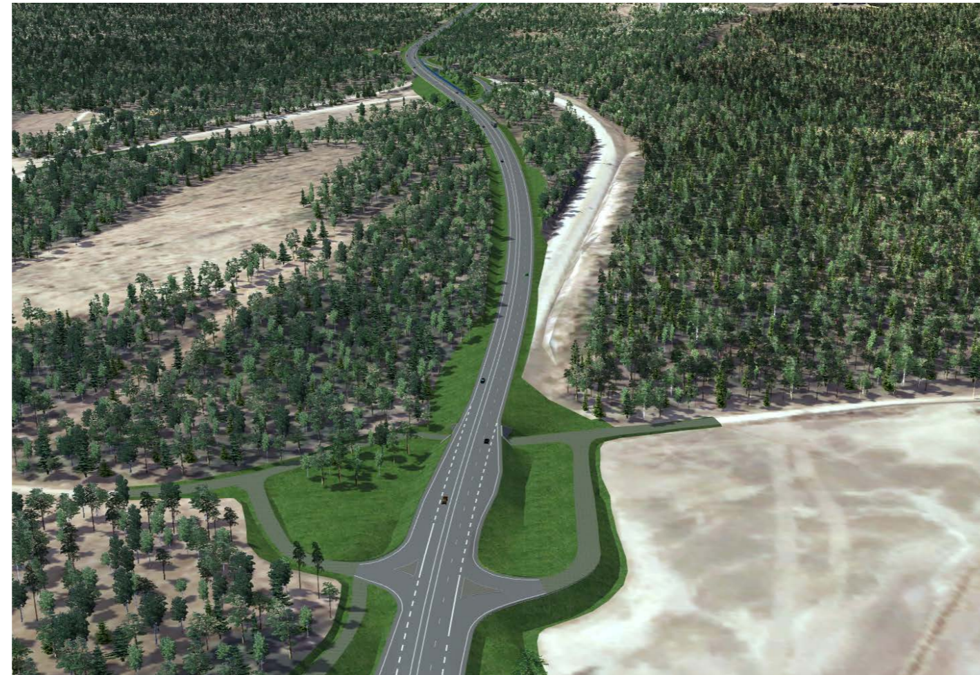
Kuva 5.23. Valtatien parantaminen ohituskaistatieksi parantaa liikenteen sujuvuutta ja turvallisuutta. Havainnekuva Sitikkalan oikaisusta Lahden suuntaan.
